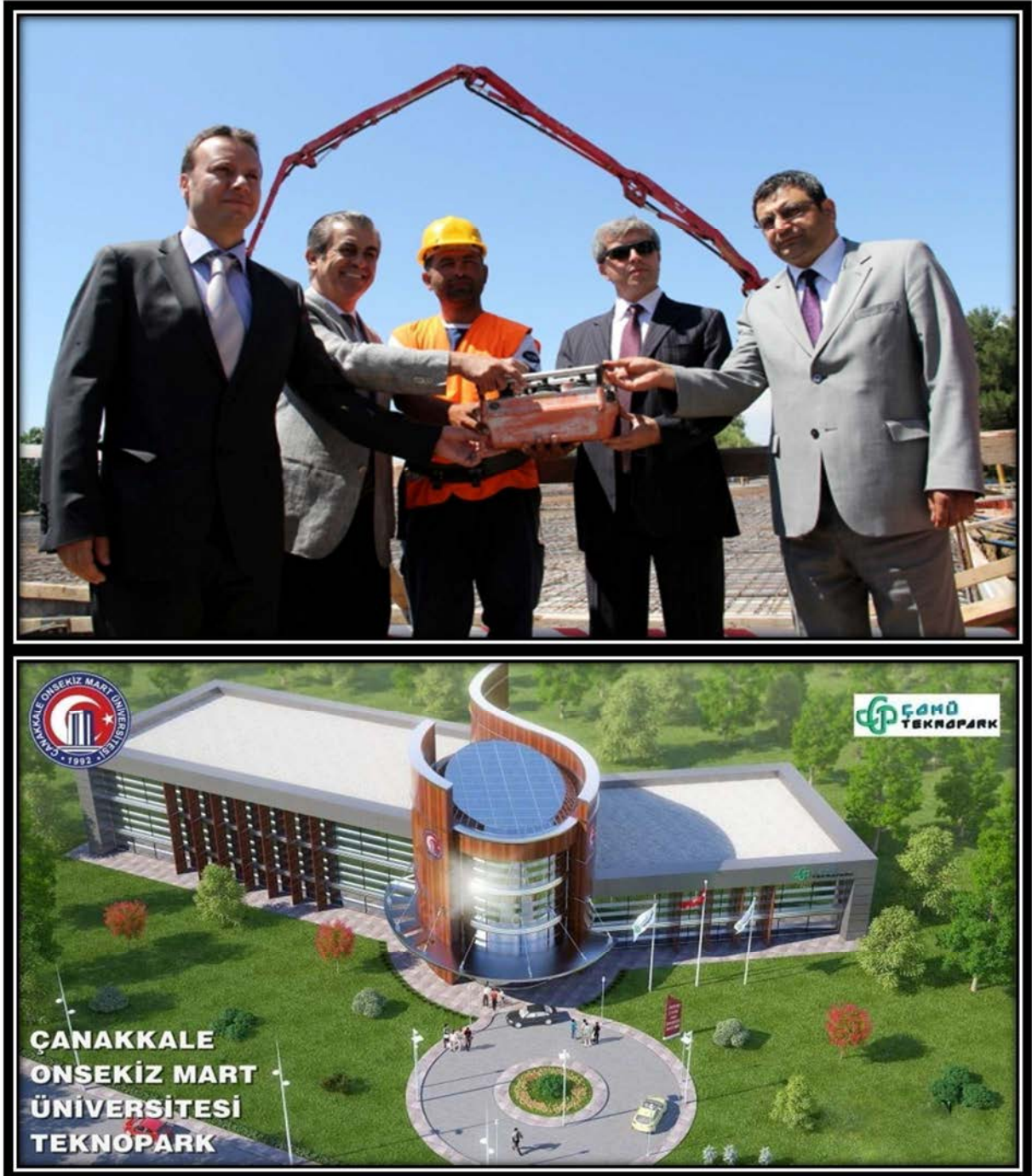
Fotoğraf 22 Teknopark ÇTSO Binası Temel Atma Töreni ve Modeli
