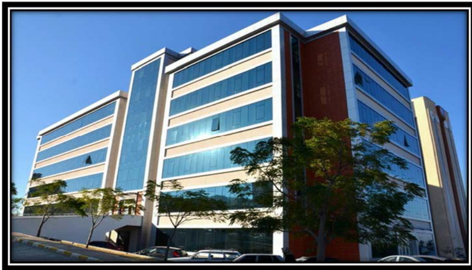
Fotoğraf 21 Bilgi İşlem Binası
