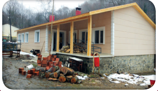
Elmaçukuru Köy Konağı Yapım-Onarım Çalışması (Sonrası)
