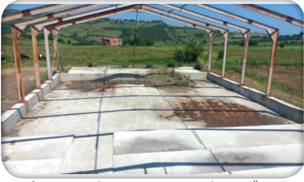
Taflan Düğün Salonu Yapım-Onarım Çalışması (Öncesi)
