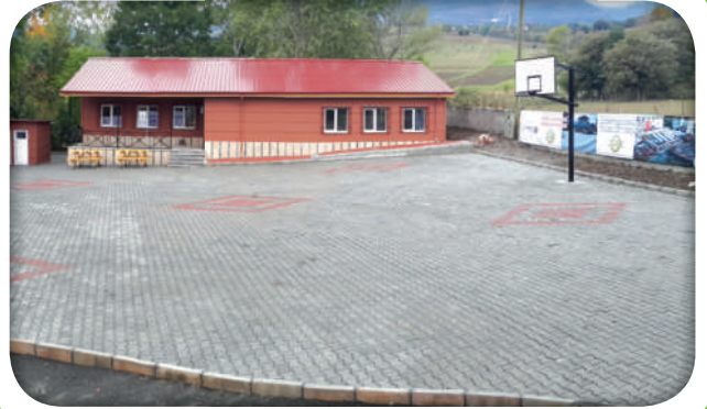
Sarıtaş Köy Konağı Parke Çalışması (Sonrası)
