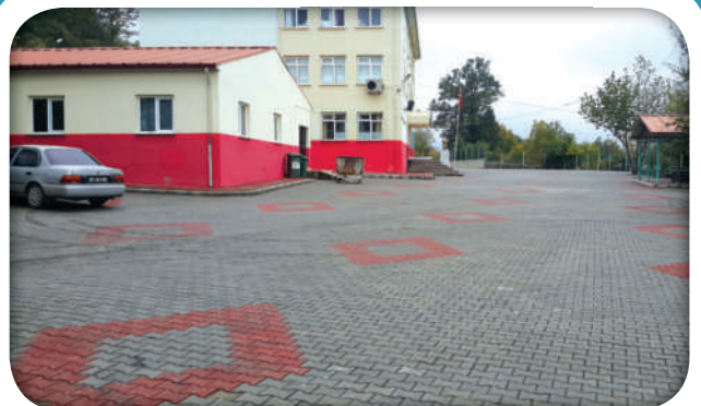
Saray Köyü İlkokulu Parke Çalışması (Sonrası)
