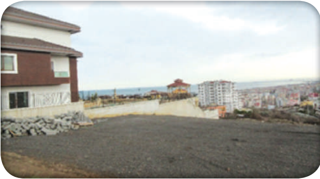
Alanlı 3402 Ada Park Yapımı (Öncesi)
