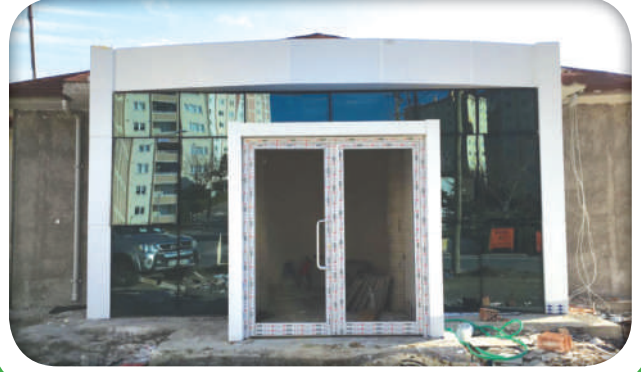
Atatepe Kültür Evi Yapım
