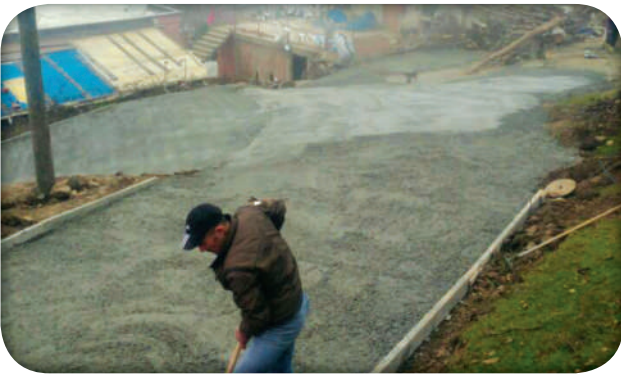
Aksu Mahallesi Beton Yol Çalışması
