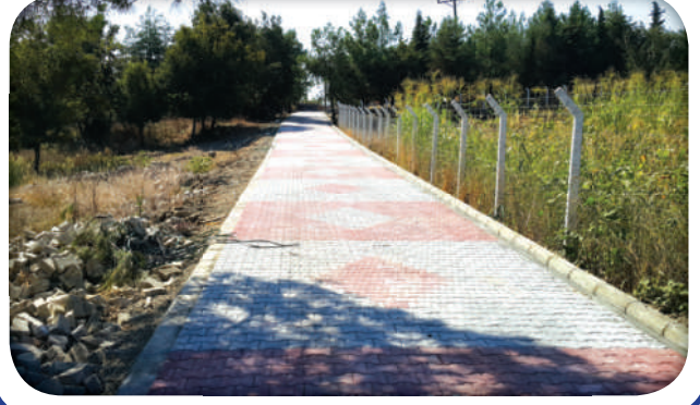
Kamalı Köyü Parke Çalışması (Sonrası)
