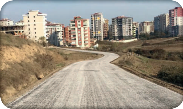
Yeni Yalı Mahallesi Sathi Kaplama Çalışması (Sonrası)
