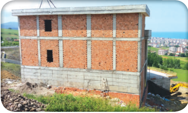
Seyir Tesisi Yapım
