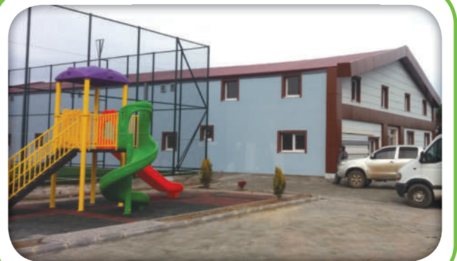
Taflan Düğün Salonu Yapım-Onarım Çalışması (Sonrası)
