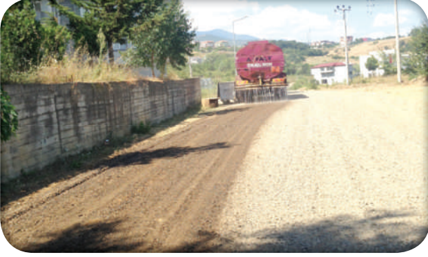
Körfez Mahallesi Sathi Kaplama Çalışması (Sonrası)
