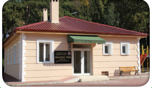
Akalan Köy Konağı Yapım-Onarım Çalışması (Sonrası)
