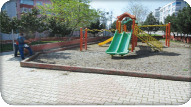
Şirinler Parkı Yenileme Çalışması (Öncesi)
