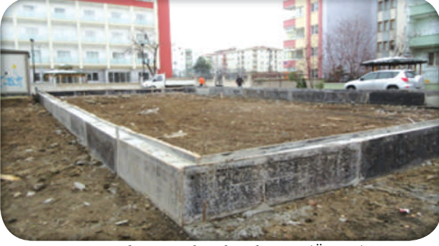
8435 Ada 2 Parsel Park Çalışması (Öncesi)
