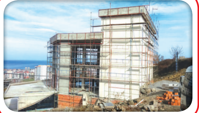
Seyir Tesisi Yapım
