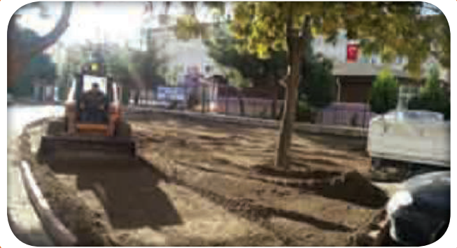
Mimarsinan Mahallesi Okul Önü Park Çalışmaları (Öncesi)
