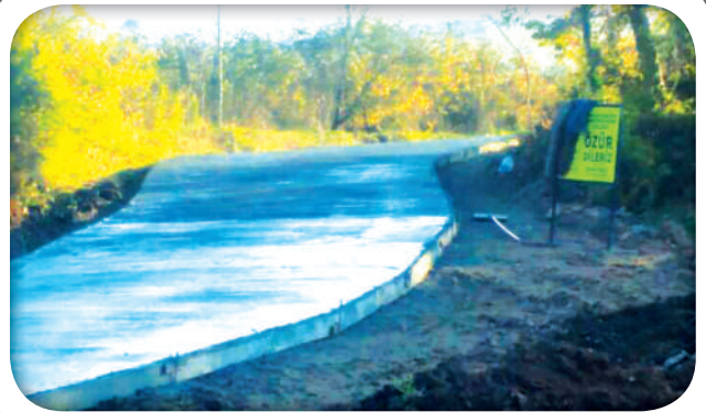
Taflan Cami Mahallesi Beton Yol Çalışması
