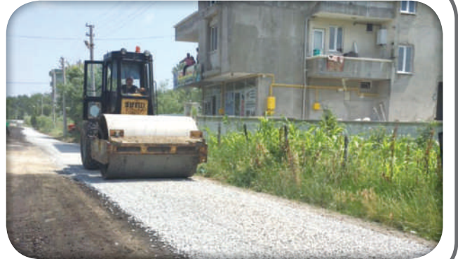
Çakırlar Yalı Mahallesi Sathi Kaplama Çalışması (Sonrası)
