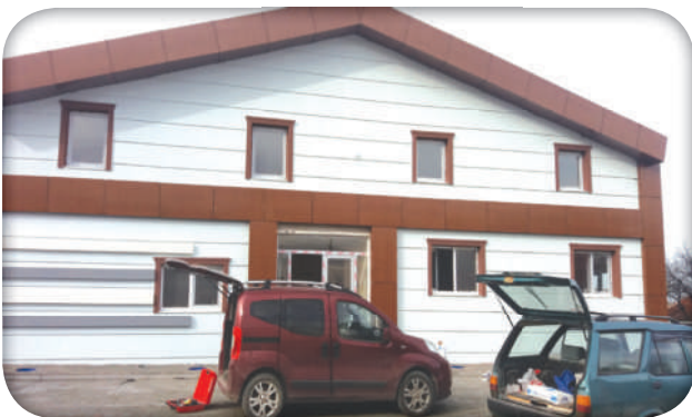
Taflan Düğün Salonu Yapım-Onarım Çalışması (Sonrası)
