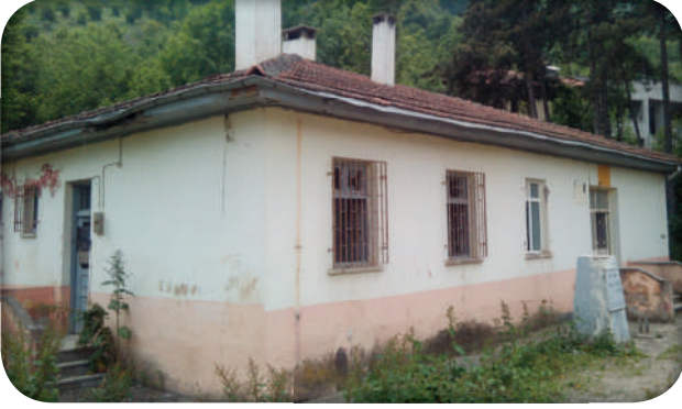
Akalan Köy Konağı Yapım-Onarım Çalışması (Öncesi)
