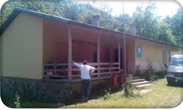
Elmaçukuru Köy Konağı Yapım-Onarım Çalışması (Öncesi)
