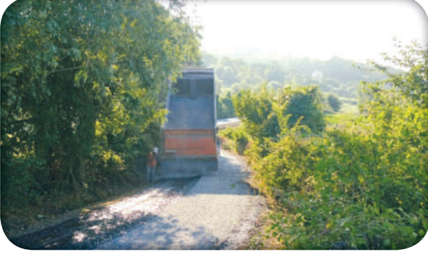
Yeşilyurt Mahallesi Sathi Kaplama Çalışması (Öncesi)
