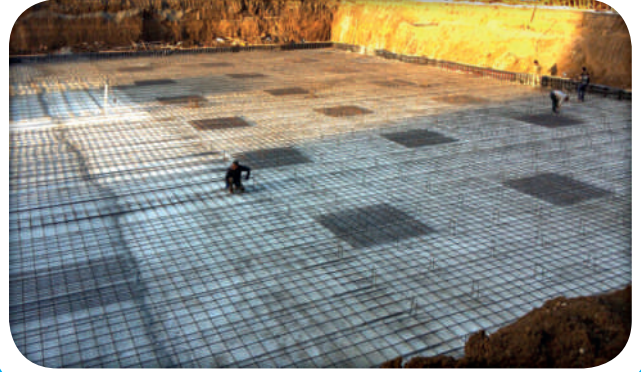
Atakum Spor Kompleksi ve Sosyal Donatı Alanları Yapım-Onarım Çalışması (Sonrası)
