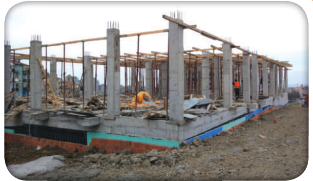
Osmanlı Hamamı Yapım-Onarım Çalışması (Sonrası)
