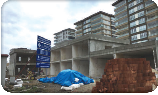
Sağlık Kompleksi ve Etüt Merkezi Yapım-Onarım Çalışması (Öncesi)
