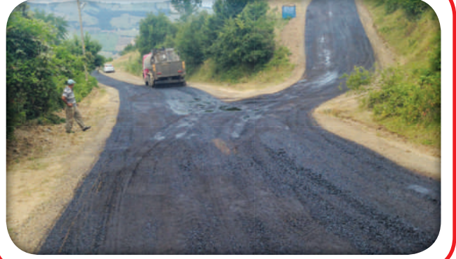
Taflan Cami Mahallesi Sathi Kaplama Çalışması (Sonrası)
