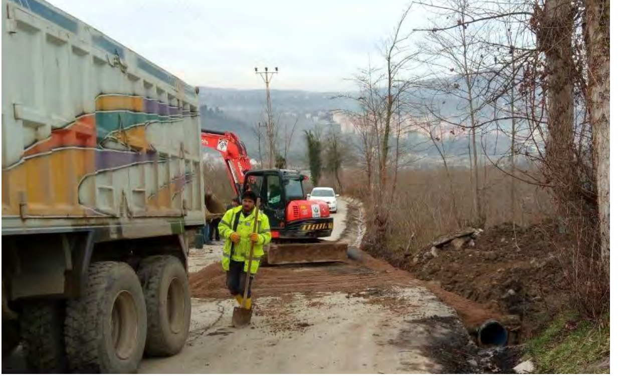
Hatıpli Mahallesi Kocacıoğlu Sokak Korusu Boru İmalatı
