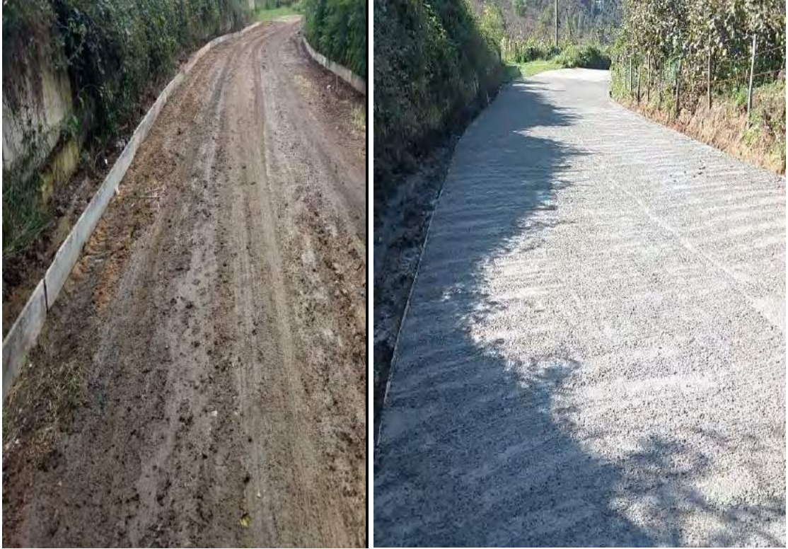
Yukarıtepe Mahallesi Merkez Sokak Beton Yol Yapım İşi İlk / Son Hali
