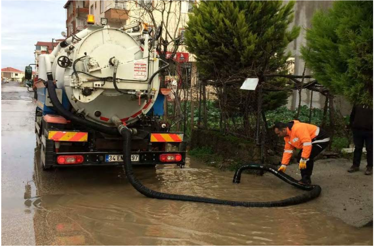
Vidanjör ile Yapılan Mazgal Açma İşlemi
