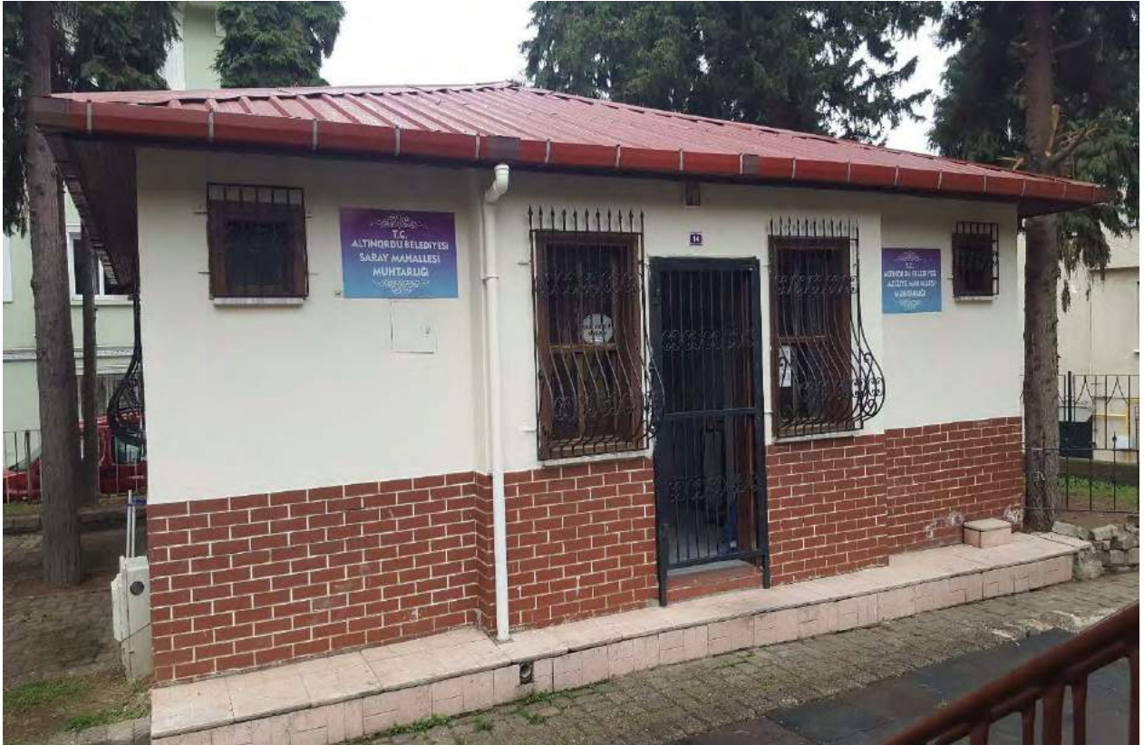
Karapınar Mahallesi Beton Laboratuvarı Yapım İşi
