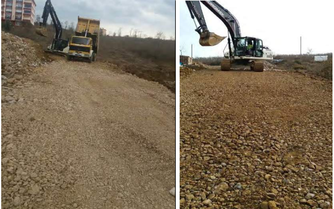
Karşıyaka Mahallesi 1025. Sokak İmar Yolu Çalışması İlk/Son Hali
