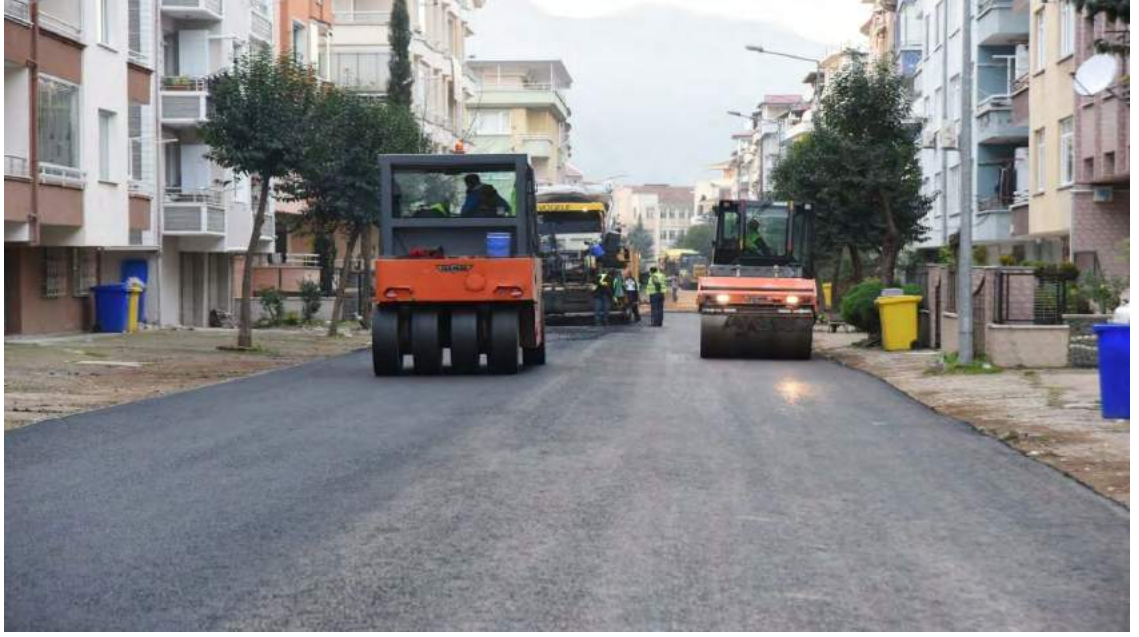
Bahçelievler Mahallesi Asfaltlama İşi İlk/Son Hali
