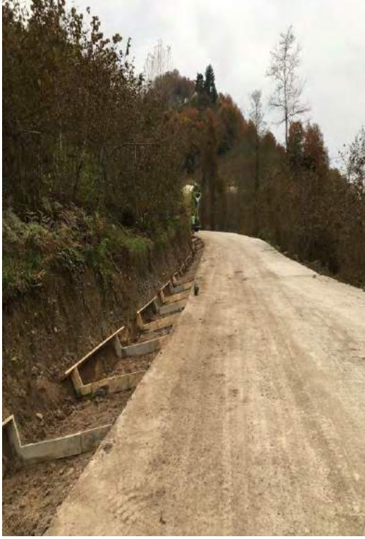
Akkese - Yağızlı Mahallesi Beton Yol- V Kanal Çalışması İlk/Son Hali
