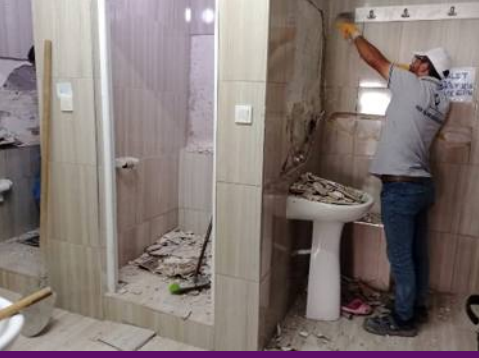
Köy konağı fayans onarımı yapıldı.
