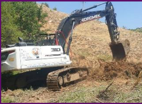
Mahalle içme suyu kazı çalışmalarımız gerçekleştirildi.
