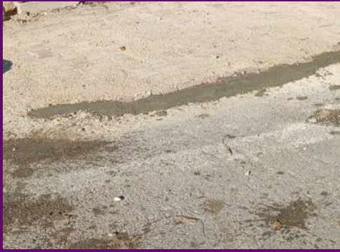
Camii girişi kilitli parke taşı yapıldı.
