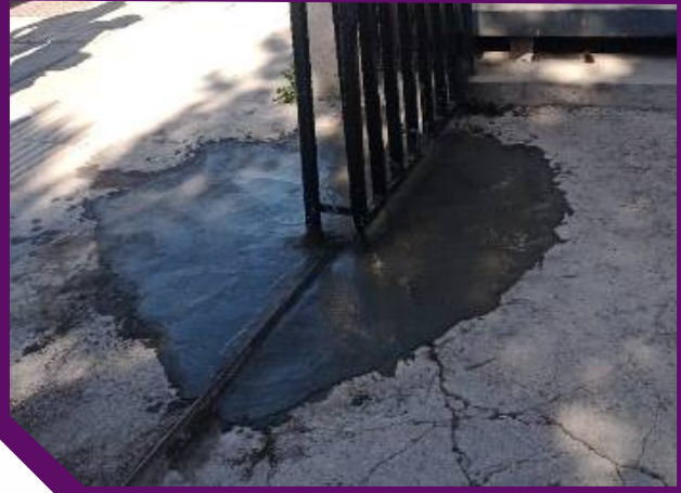
Bahçe kapı girişi beton atımı gerçekleştirildi.
