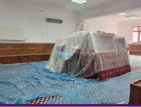
Köy konağı boya ve sıva işlerinin yapımı gerçekleştirildi.
