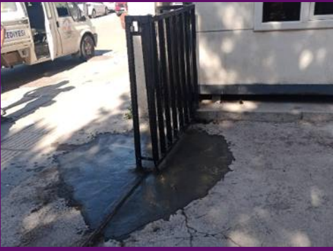
Bahçe kapı girişi beton atımı gerçekleştirildi.
