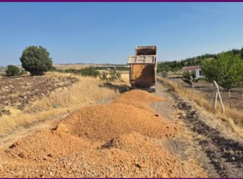
Mahalle içme suyu kazı çalışmalarımız gerçekleştirildi.
