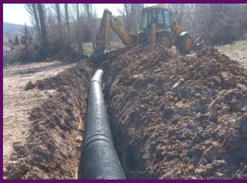
Çeşme çalışması için korge boru yerleştirildi.
