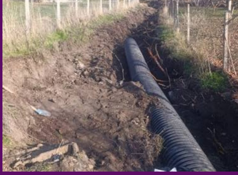
Dere yatağı koruge boru yerleştirilmesi
