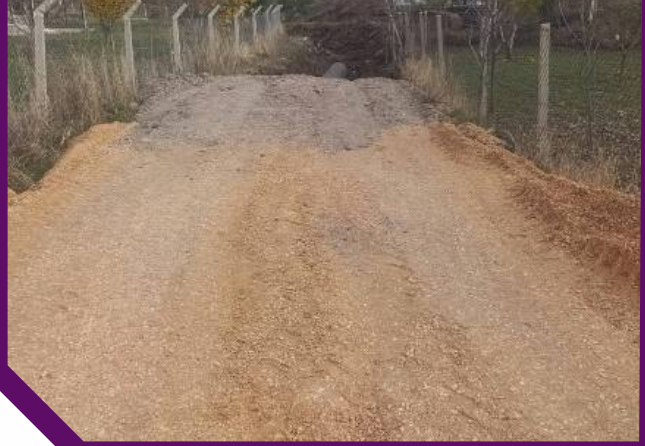
Dere yatağı koruge boru yerleştirilmesi
