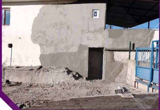
Konak tuğla örümü ve sıva bakım işlemleri yapılmıştır.
