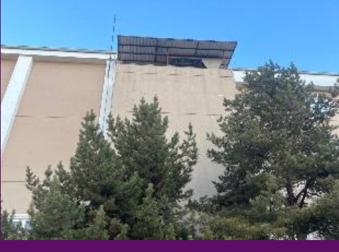
Balkon sundurma montajı yapıldı.
