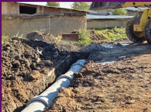
Dere geçiş yapıları beton büz ile yenilendi, gömleklimesin yapılıp kapatılarak araç trafiğine uygun hale getirildi. Garip dede mezarı tadilatı yapıldı.
