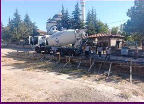
Köprü üstü betonu atıldı
