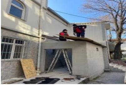
Gökçay Cami morg çatısı yapıldı. yapıldı.
