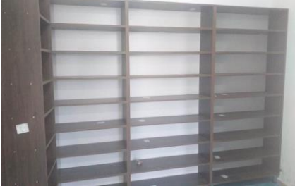
Abdulhamit Cami ayakkabılık dolabı montajı yapıldı.
