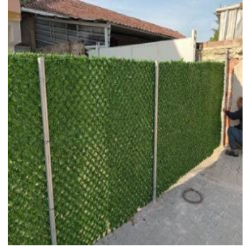
Adaköy İlkokulu yanı çit yapımı
