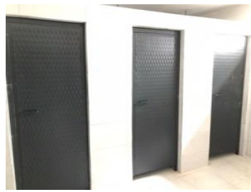
Kazıklı Camisi tuvalet kapısı montaj edildi.
