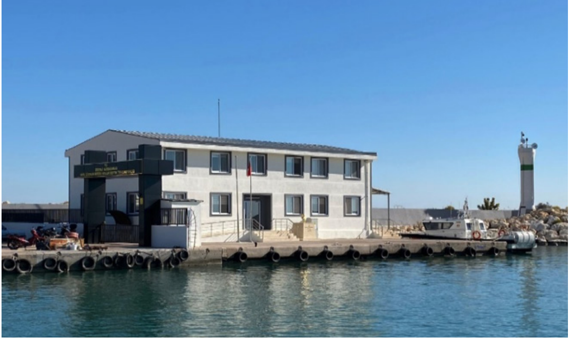
S.G. Erdemli Kolluk Destek Tim Binası İnşaatı
