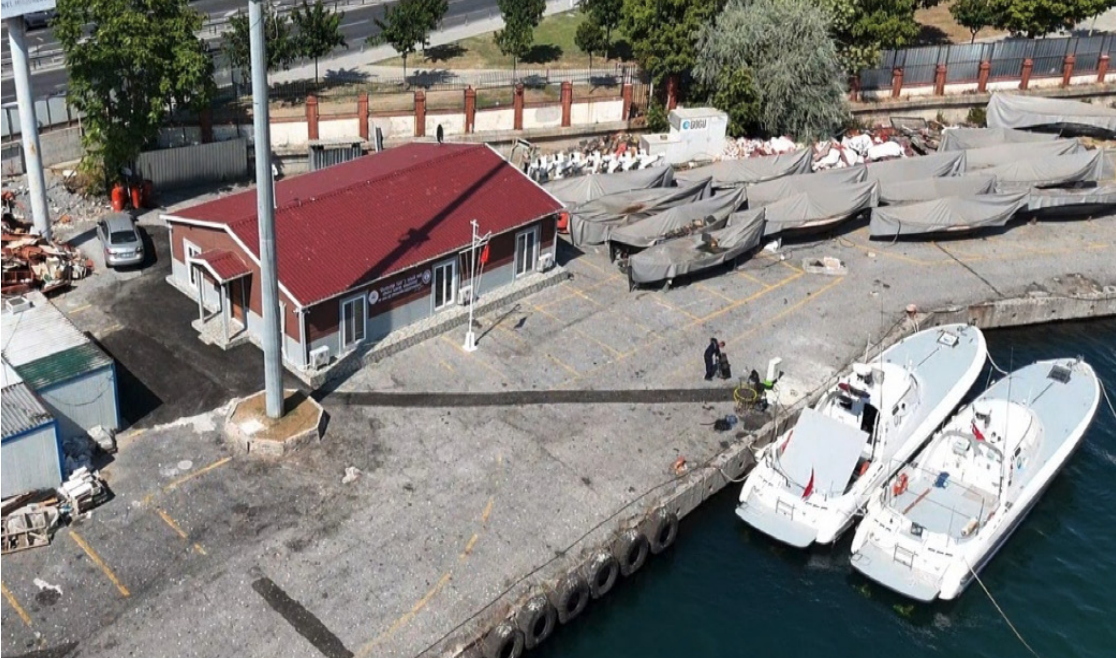
S.G. Kumkapı Kolluk Destek Tim Binası İnşaâtı
