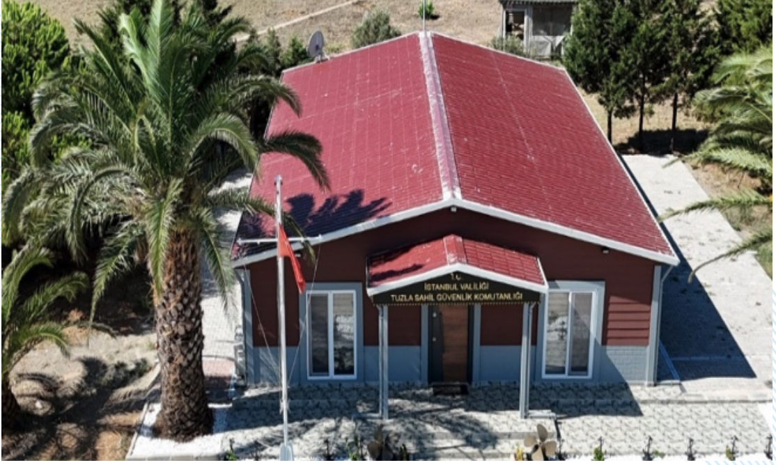
S.G. Tuzla DHO Kolluk Destek Tim Binası İnşaatı
