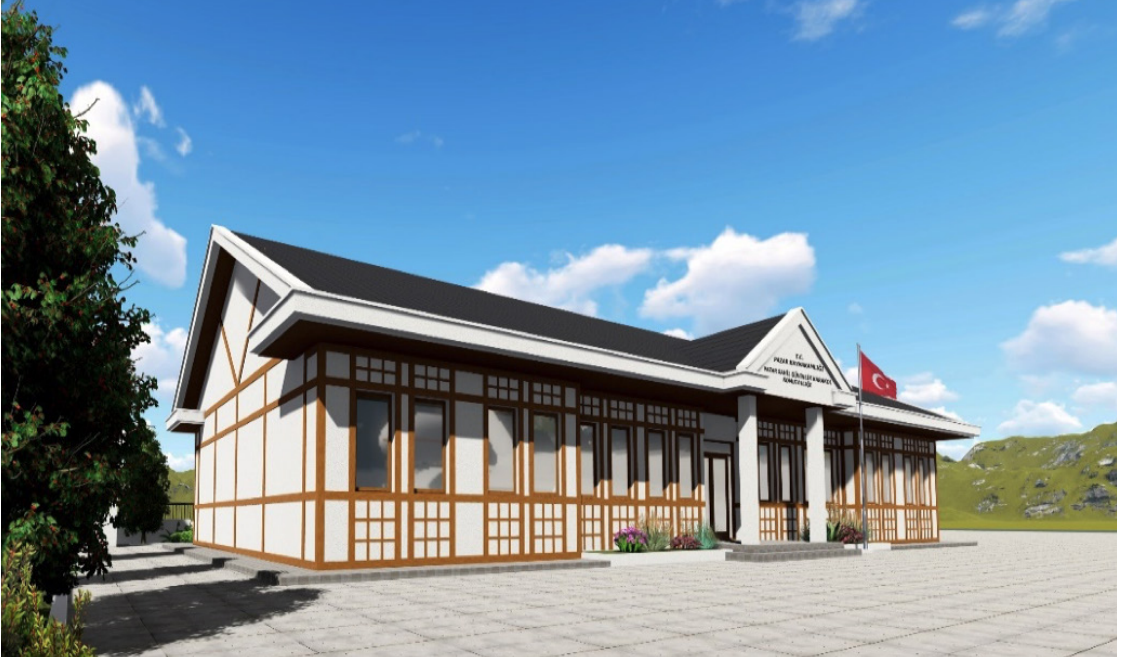
S.G. Pazar Karakol Komutanlığı Binası İnşaatı
