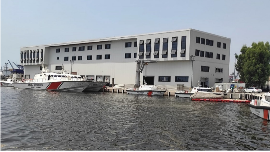
S.G. Akdeniz Onarım Destek K.lığı Binası İnşaatı
