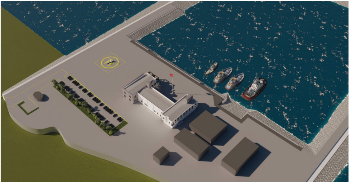
S.G. Çeşme Liman ve Karakol İnşaatı
