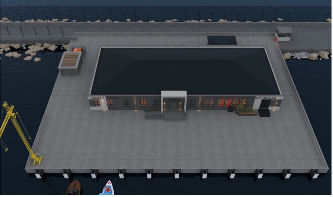
Karasu S.G. Karakol Komutanlığı İnşaatı
