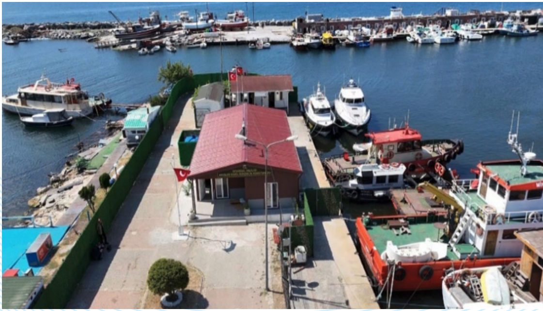
S.G. Avcılar Kolluk Destek Tim Binası İnşaatı
