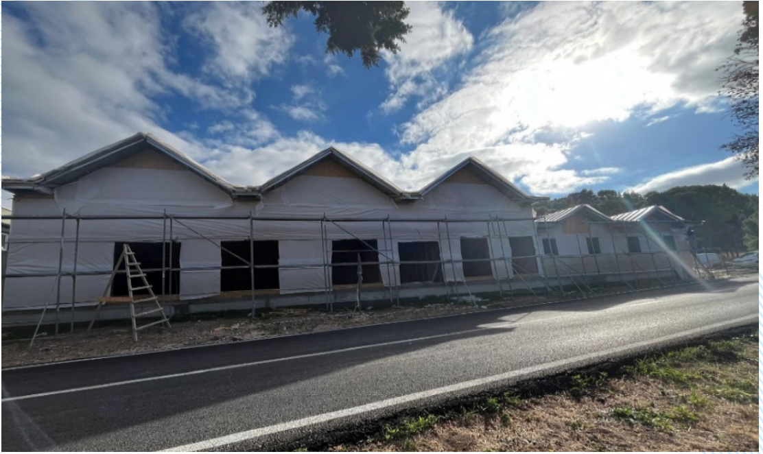
Nara S.G. Karakol Komutanlığı İnşaatı
