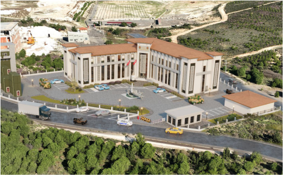
Foça SÖH Komutanlığı İnşaatı
