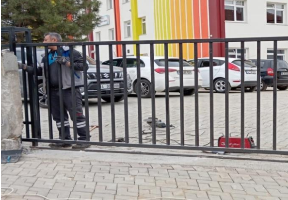
Paşaköy ilkokulu dış kapı imalatı ve montajı
