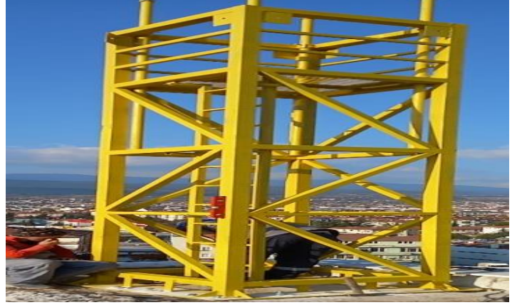
Bilgi işlem verici direk imalatı ve montajı
