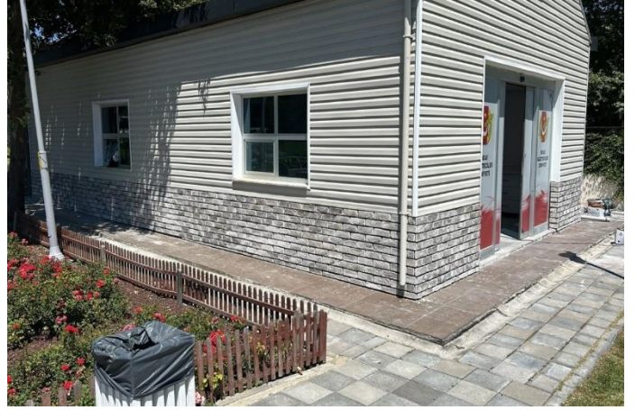
Nilüfer Park içerisinde bulunan yapının onarımı
