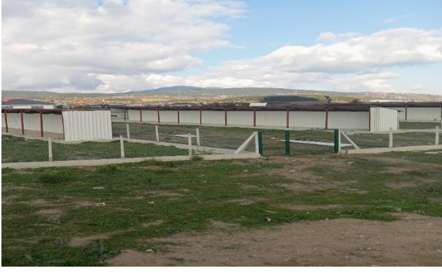
Veteriner işleri geçici hayvan barınağı sundurma imalatı ve montajı
