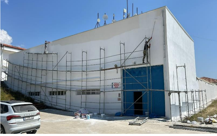
İçme suyu Arıtma Tesisi bina tadilatları
