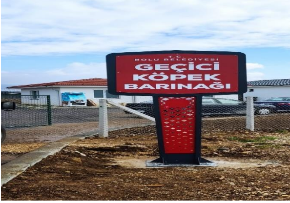
Geçici hayvan barınağı tabela imalatı ve montajı
