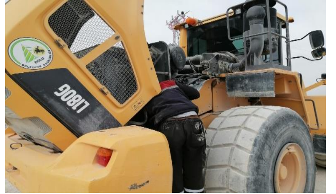
Çay şantiye iş makinası tamir bakım ve onarımı
