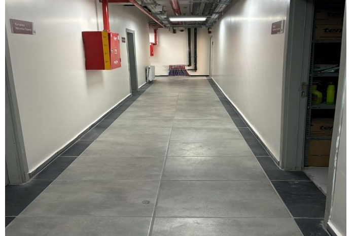
İtfaiye Binası tadilat tamirati
