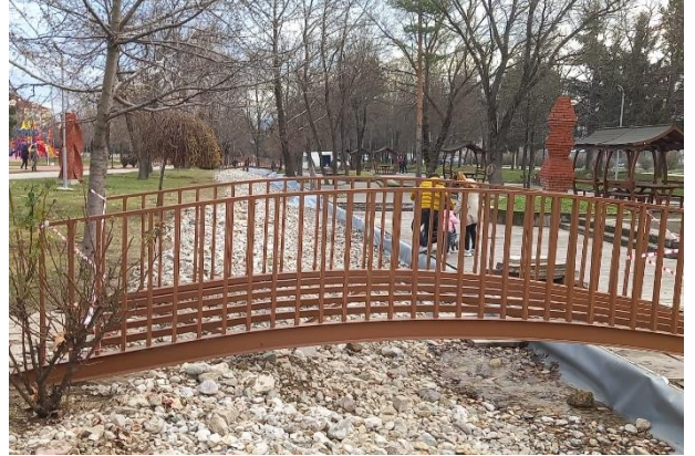
Atatürk orman parkı köprü imalatı ve montajı
