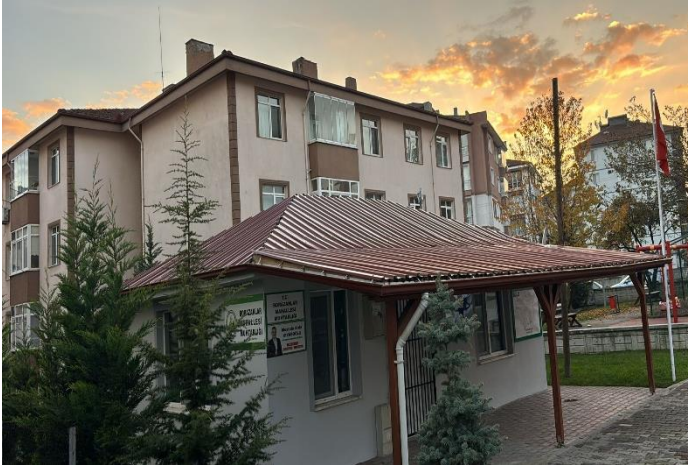
Borazanlar Muhtarlık Binası çatı değişimi
