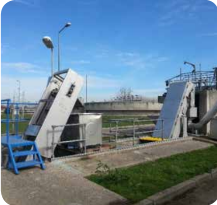
Yeni Zincirli Tip Mekanik İnce ve Perfore Elek Izgara
