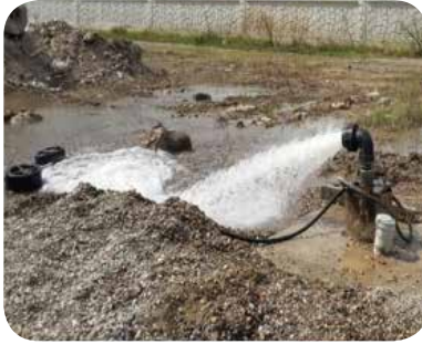
Karasu Kuyumculu derin kuyu yapımı
