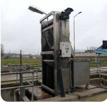
Yeni Zincirli Tip Mekanik İnce ve Perfore Elek Izgara
