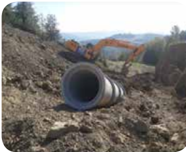
Taraklı Hacıyakup Gölü tahliye hattı yapım çalışmaları ve onarımı
