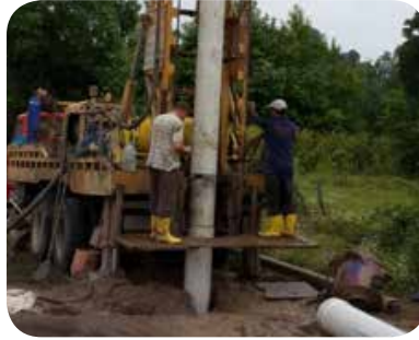
Akyazı-Kuzuluk derin kuyu yapımı
