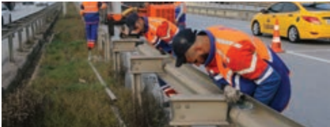
Havalimanı Kavşağı Otokorkuluk Yapım ve Onarımı, Pendik
