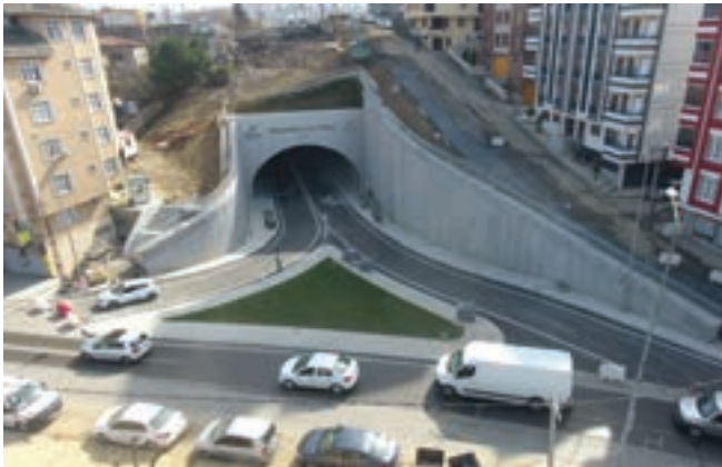
Silahtarağa Caddesi - Gaziosmanpaşa Caddesi Arası Karayolu Tüneli, Eyüpsultan
