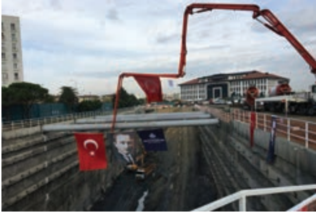
Çekmeköy - Sancaktepe - Sultanbeyli - Hastane - Yenidoğan Metro Hattı, Abdurrahmangazi İstasyonu
