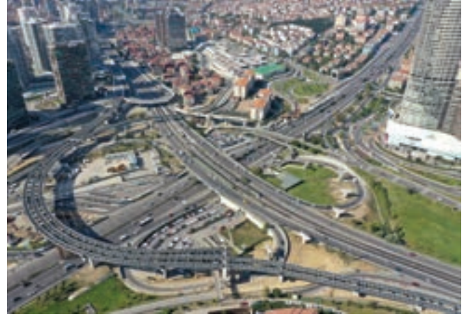
Fikirtepe İmar ve Ulaşım Yolu, Kadıköy
