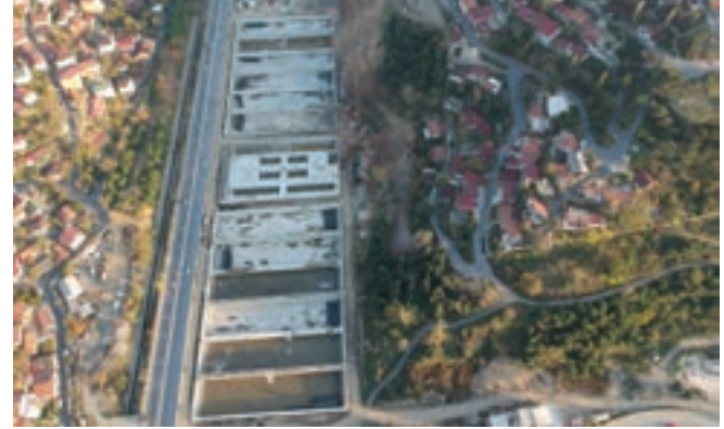
Baltalımanlı Biyolojik Atıksu Arıtma Tesisleri İnşaatı, İSKİ
