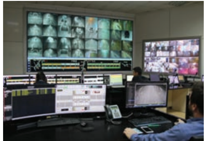
Tünel İşletim Merkezi, Şişli
