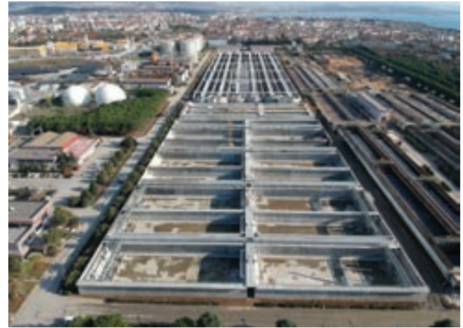
Tuzla İleri Biyolojik Atıksu Arıtma Tesisleri 3.Kademe İnşaatı, İSKİ
