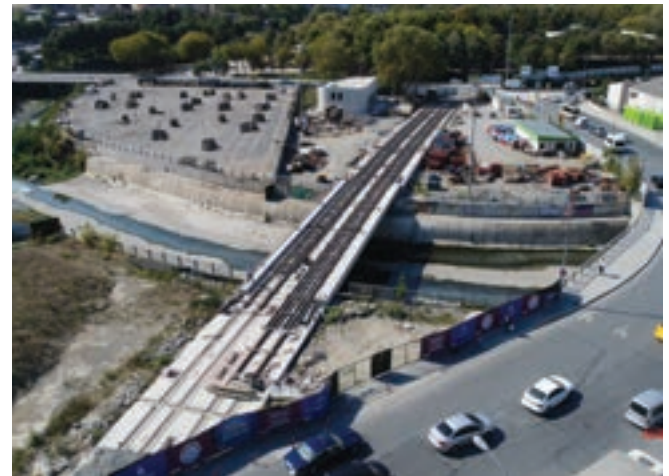
Eminönü - Alibeyköy Tramvay Hattı, Depo Sahası
