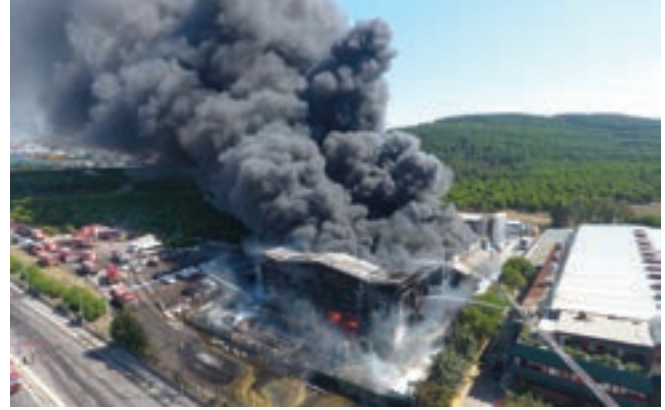
Fabrika Yangını, Tuzla
