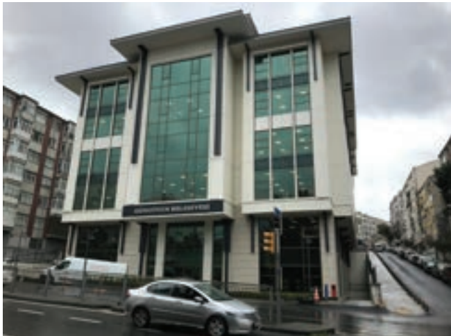
Güngören Belediye Hizmet Binası
