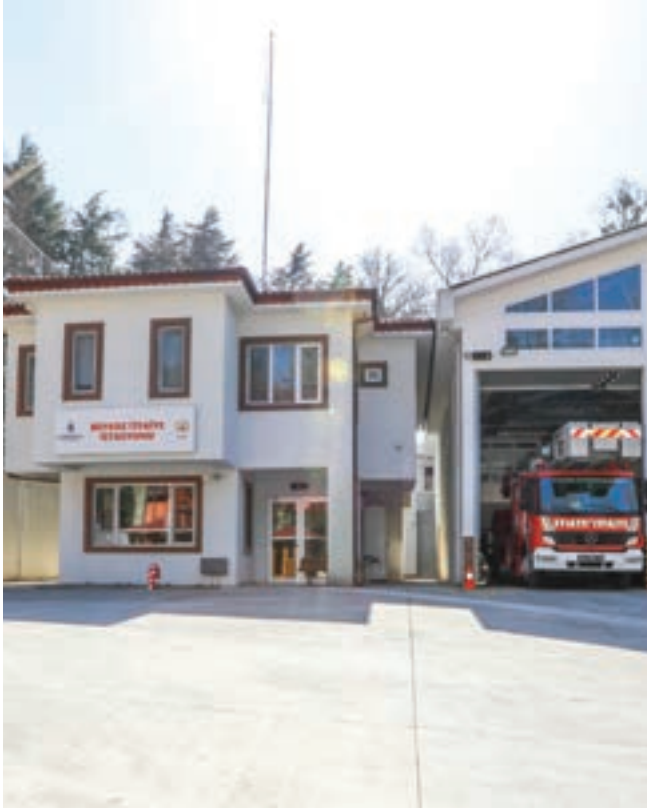
Beykoz İtfaiye İstasyonu
