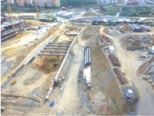
Başakşehir-Kayaşehir Metro Hattı, Şehir Hastanesi İstasyonu
