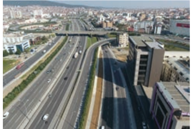
TEM Kuzey Güney Yan Yolları ile Ekol Caddesi Kesişimi Köprüsü, Sultanbeyli
