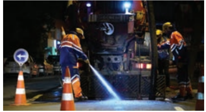
Okul Caddesi Yağmursuyu Kanal Temizliği, Beykoz
