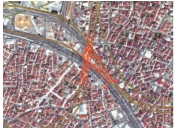
Kaynarca - Pendik - Tuzla Metro Hattı, Kaynarca İstasyonu
