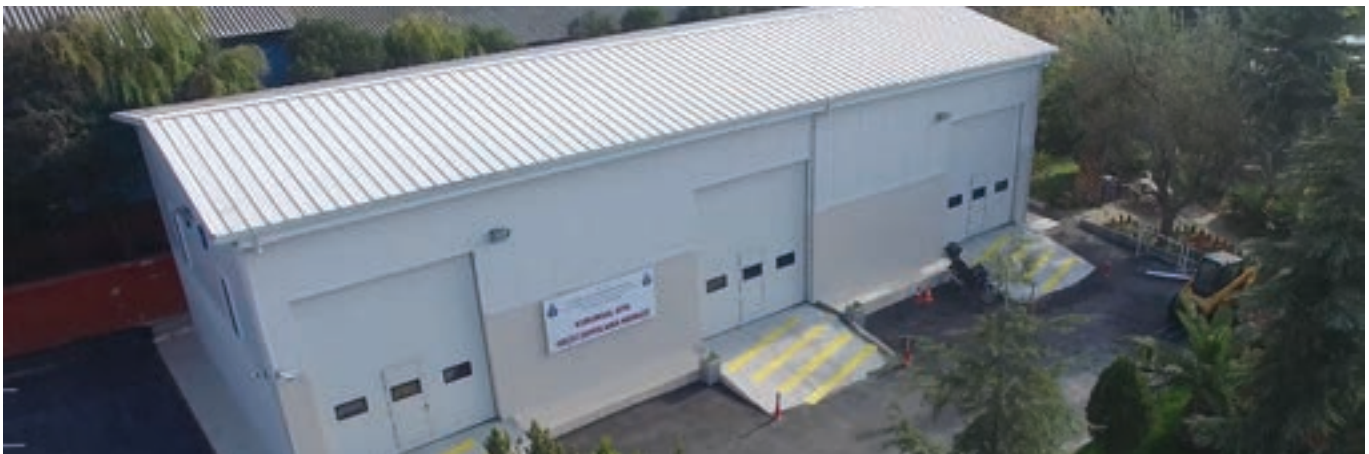
Kurumsal Atık Geçici Depolama Merkezi, Yenibosna
