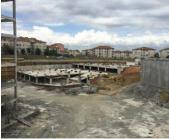
İnkılap Mahallesi Zeminaltı Otoparkı, Ümraniye
