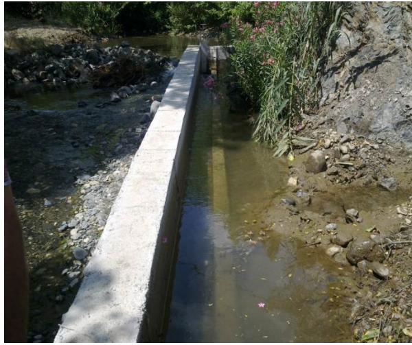
Antakya Tahtaköprü Sulama Tesis
