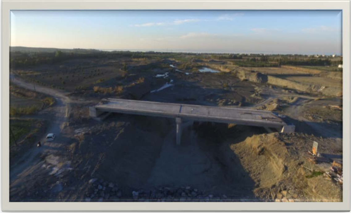
Resim 33:ARSUZ İLÇESİ ZİLLİ DERESİ ÜZERİNE BETONARME KÖPRÜ YAPIM İŞİ
