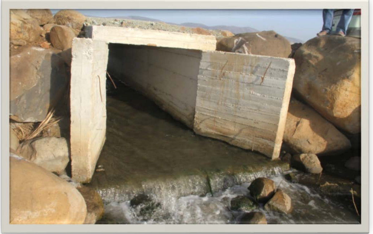
Resim 12: HATAY İLİ KIRIKHAN İLÇESİ KUTU MENFEZ, KAPLAMALI HENDEK VE DUVAR YAPIM İŞİ
