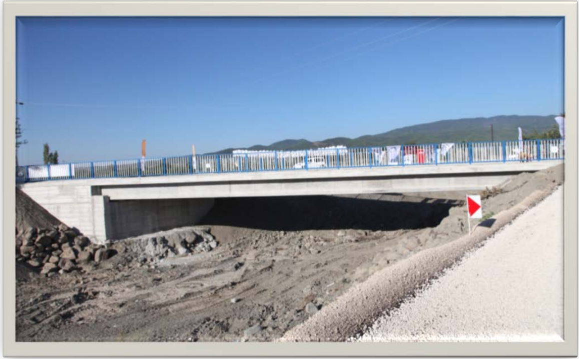
Resim 34:ERZİN İLÇESİ ESKİ ADANA YOLU ÜZERİNDE KÖPRÜ YAPIM İŞİ
