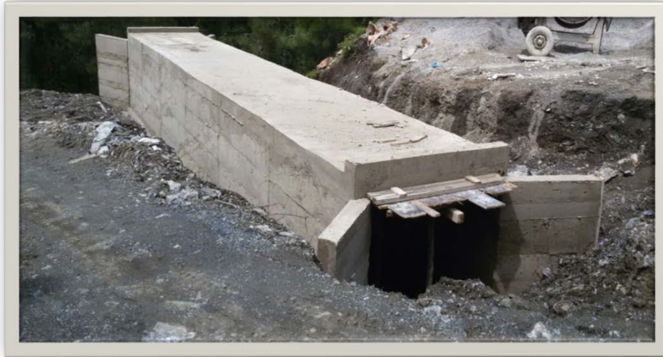
Resim 1: DÖRTYOL VE PAYAS İLÇESİ 6 ADET KUTU MENFEZ YAPIM İŞİ
