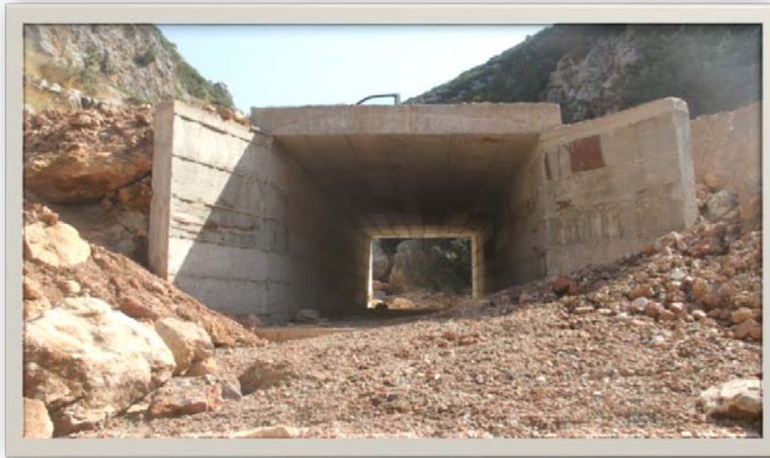
Resim 4: DEFNE İLÇESİ MENFEZ YAPIM İŞİ
