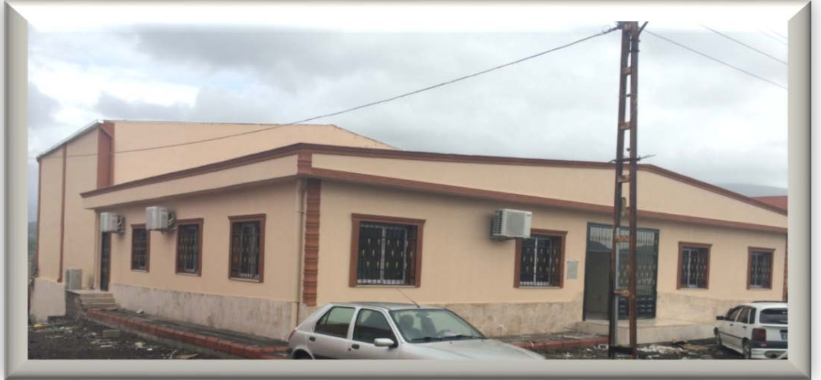
Resim 22 ARSUZ İLÇESİ PİRİNÇLİ MAHALLESİ ÇOK AMAÇLI SALON YAPIM İŞİ
