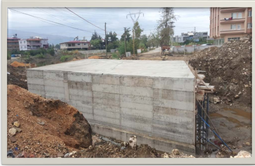
Resim 3: ANTAKYA İLÇESİ MENFEZ YAPIM İŞİ
