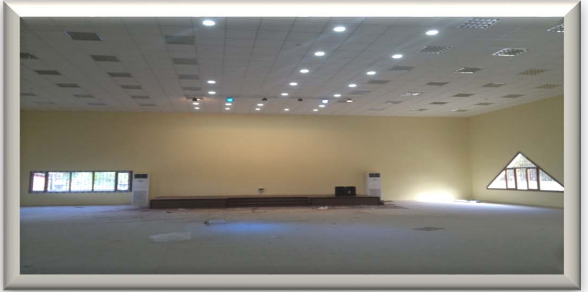
Resim 19:ARSUZ İLÇESİ HÖYÜK MAHALLESİ ÇOK AMAÇLI SALON YAPIM İŞİ
