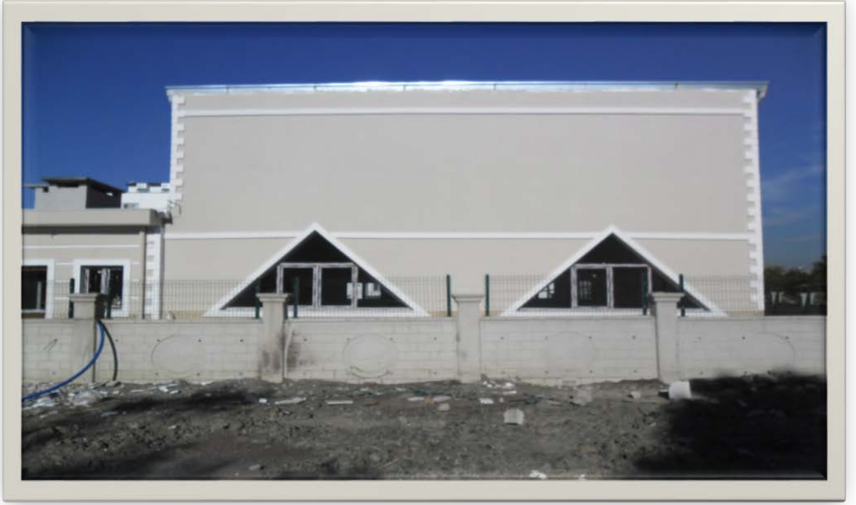
Resim 16: ARSUZ İLÇESİ ALAKOP MAHALLESİ ÇOK AMAÇLI SALON YAPIM İŞİ
