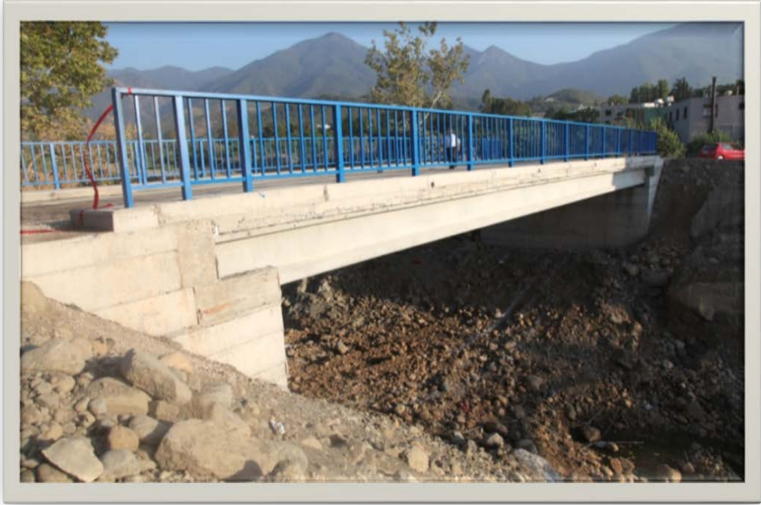
Resim 32:ARSUZ İLÇESİ HÖYÜK MAHALLESİNDE KÖPRÜ YAPIM İŞİ
