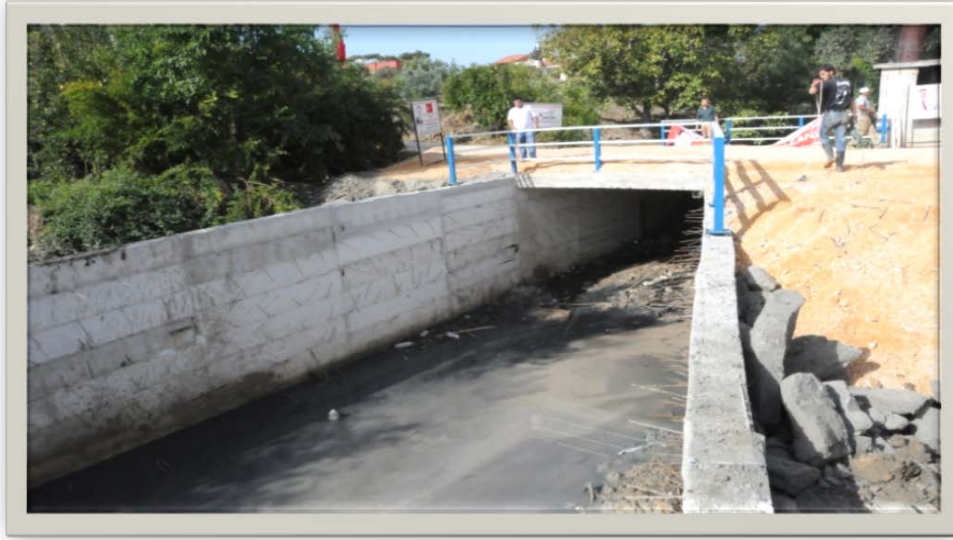
Resim 2:ALTINÖZÜ İLÇESİ MENFEZ YAPIM İŞİ
