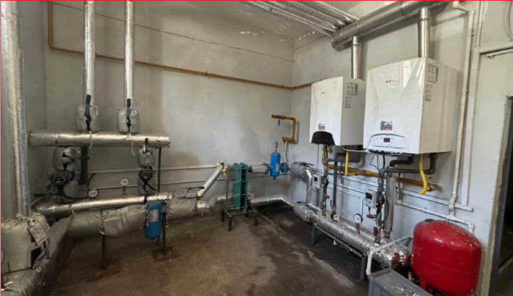
Küre İlçe Emniyet Amirliği Hizmet Binası ve Küre İlçe Emniyet Lojmanı Doğalgaz Dönüşüm İşi
