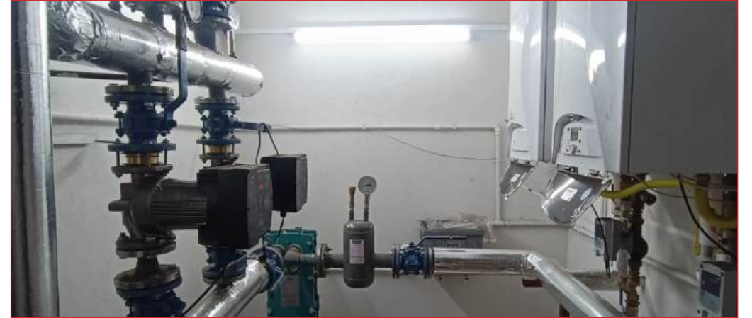
Çatalzeytin ve İhsangazi İlçe Emniyet Amirliği Hizmet Binaları Doğalgaz Dönüşüm İşi
