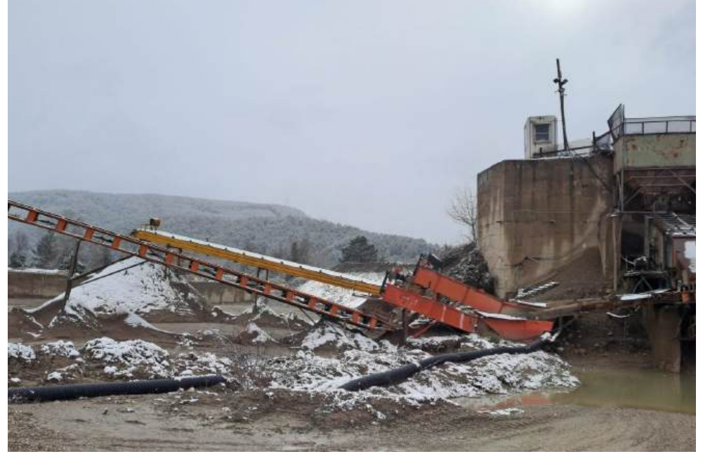
Mehmet Kumaş Kırma Yıkama Eleme Tesisi Taşköprü Alamabatak
