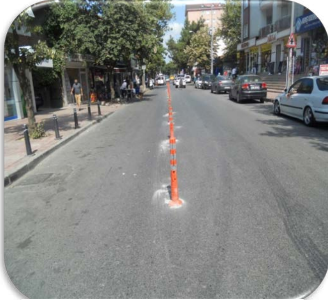
Kavacık Mahallesi Otağtepe Cad. Delinatör Uygulaması
