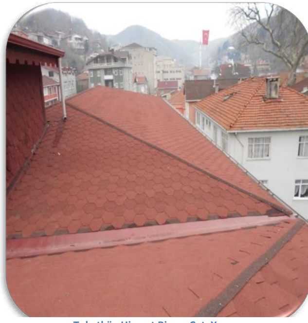
Tokatköy Hizmet Binası Çatı Yapımı
