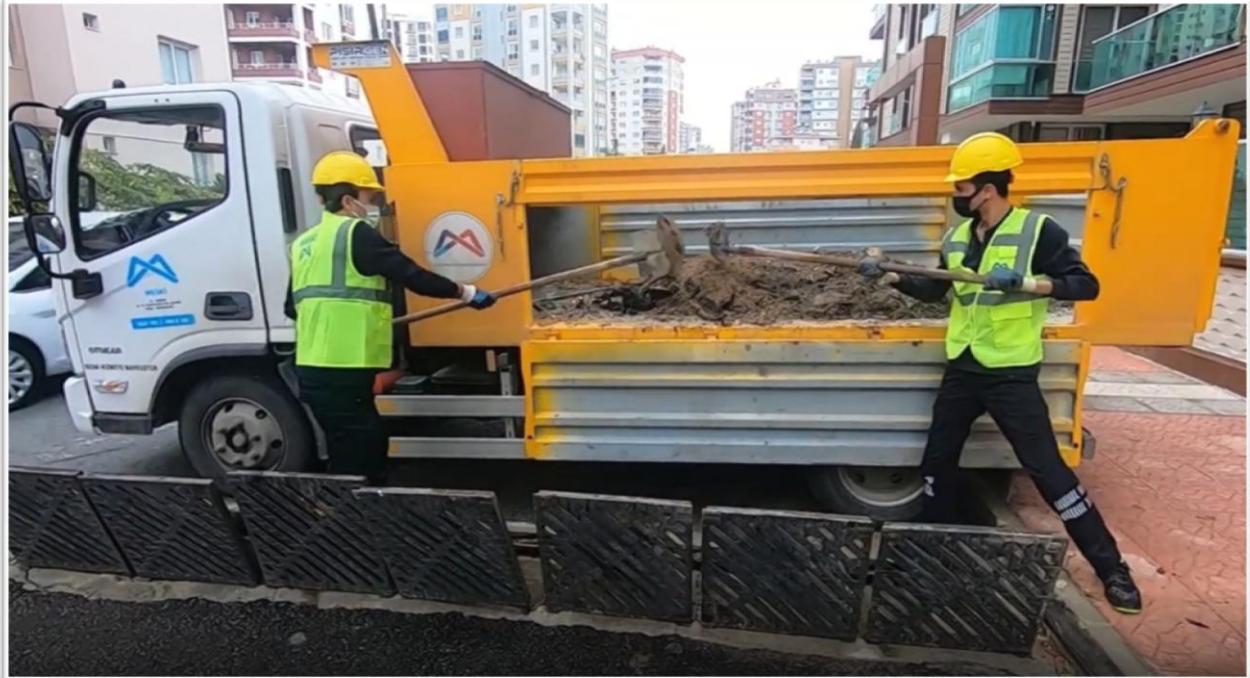
Yağmur Suyu Izgara Çalışmaları
