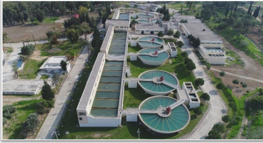
Berdan İçme Suyu Arıtma Tesis
