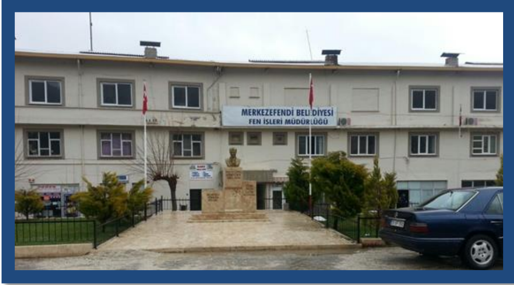
3 Nolu Ek Hizmet Binası
