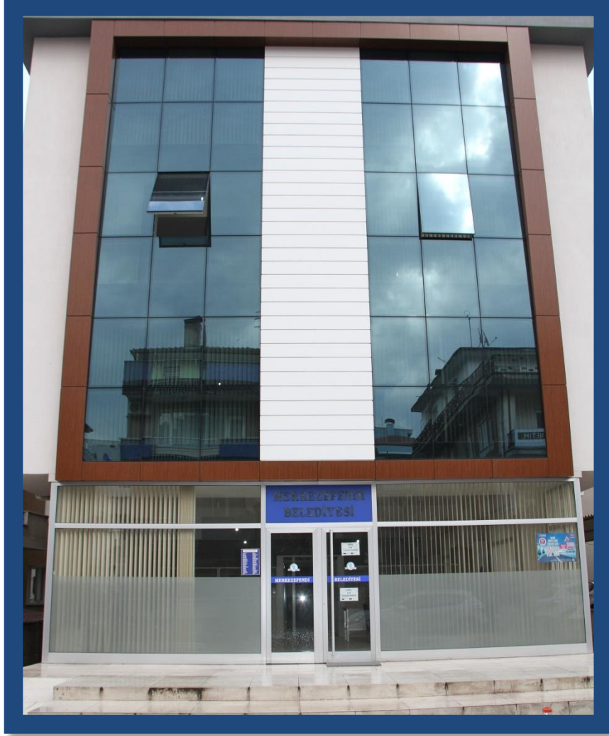
2 Nolu Ek Hizmet Binası
