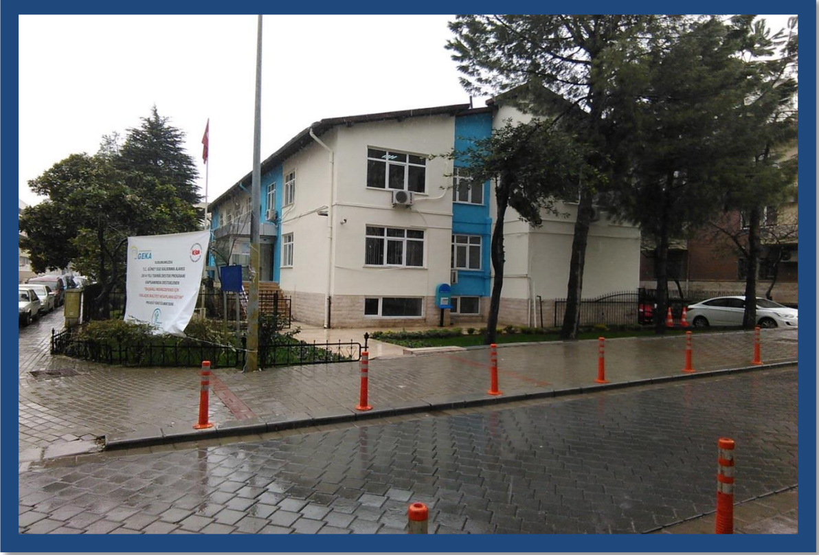
1 Nolu Ek Hizmet Binası
