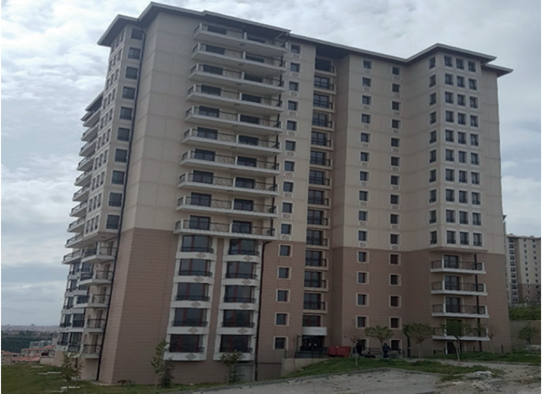
S.G. Ankara Kuzeykent Lojman Binası
