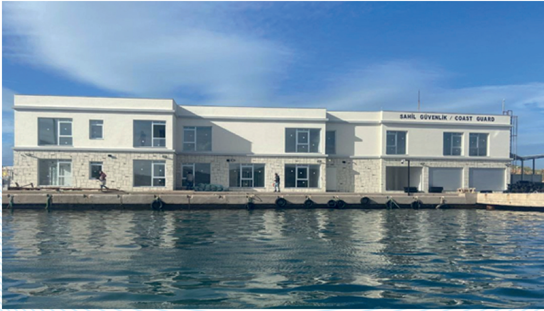
S.G. Foça Karakol Komutanlığı Binası
