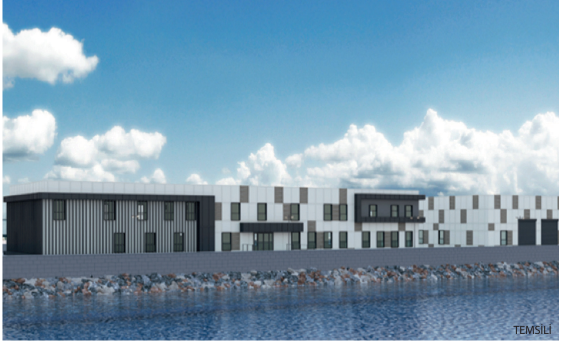
S.G. Sinop Rıhtım ve Karakol İnşaatı
