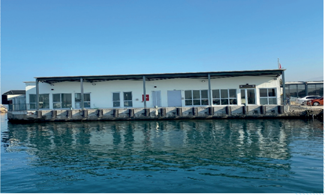
S.G. Güzelbahçe Kolluk Destek Binası
