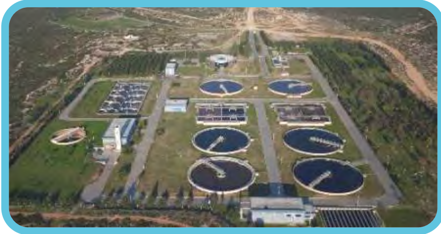
Didim Atık Su Arıtma Tesisi
