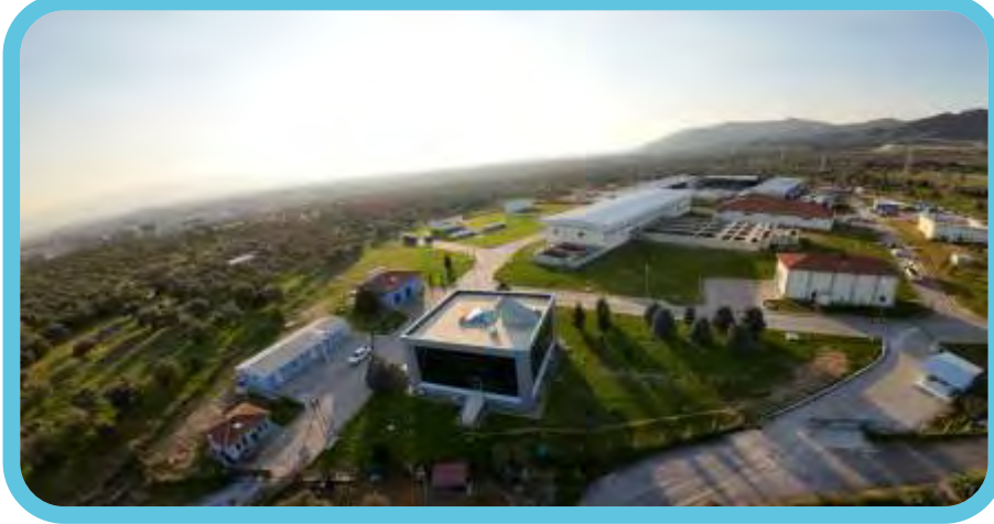
Balıkköy İçme Suyu Arıtma Tesisi
