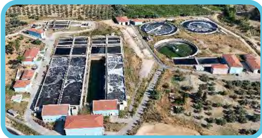
Kuşadası İleri Biyolojik Arıtma Tesisi
