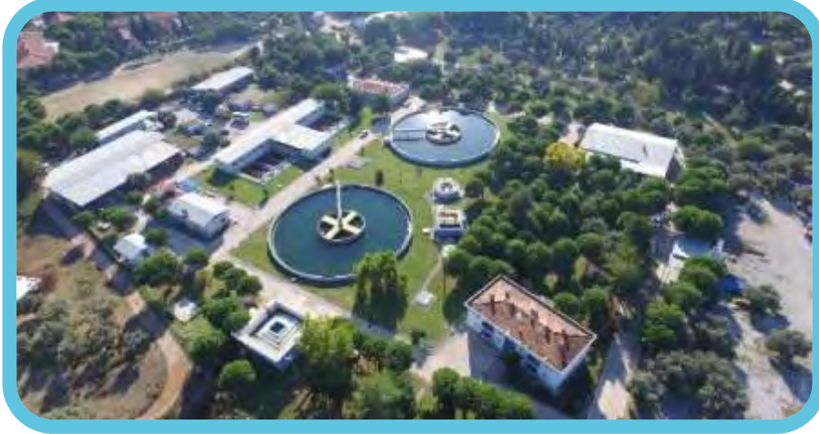
Topyatağı İçme Suyu Arıtma Tesisi
