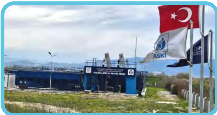
Koçanlı Atık Su Arıtma Tesisi
