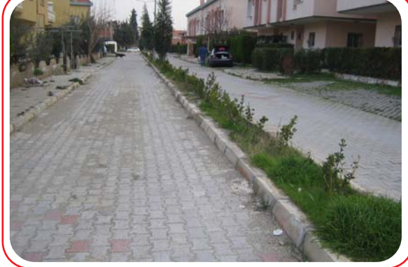
Dokuz Eylül Mahallesi, Nasır Villaları Kilit Parke Ve Beton Bordür Döşeme işi.
