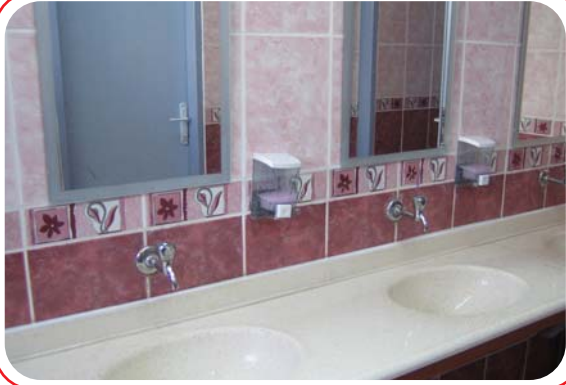
Dokuz Eylül İlköğretim Okulunun Tuvalet Tamirâtı Yapım İşi.
