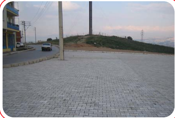
Emrez Mahallesi 186, 189 Sokaklar Kilit Parke Ve Beton Bordür Döşeme İşi.
