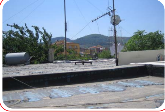
Belediye Çatı Tadilatı Yapım İşi.
