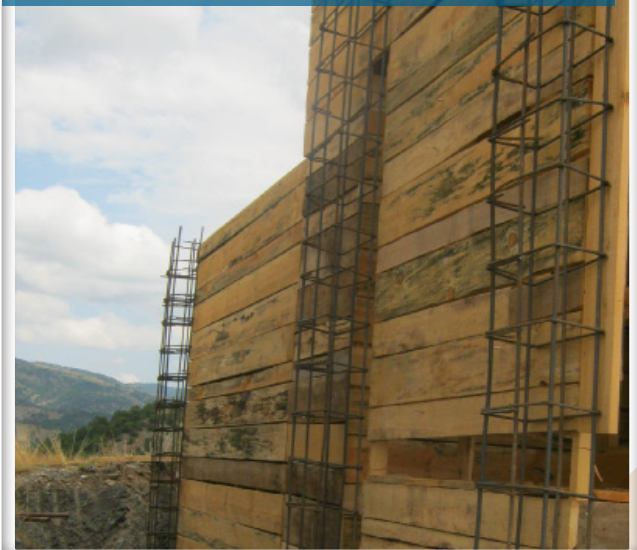
İçmesuyu Depo İnşaatı
