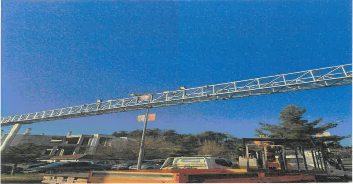
4- Merkez İle Beşiri İlçesi KGYS Sistemi Kurulumu Ve Genişleme İşi
