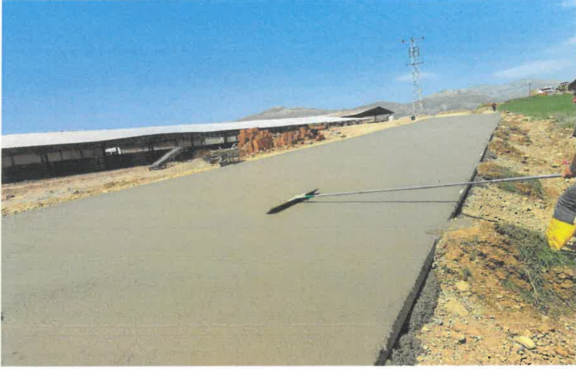
Sason İlçesine Bağlı Kaşayla Köyü Elmapınar, Güneycik-Kulp Aygün Bağlantı Yoluna Ait Beton Yol ve Sanat Yapıları Yapım İşi
