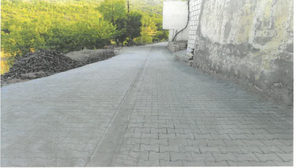
Kozluk İlçesi Tosunpınar-Armutlu-Geçitaltı Grup Köy Yolu Girişine Ait Yol Genişletme,BSK Asfalt Kaplama ve Sanat Yapıları Yapım İşi
