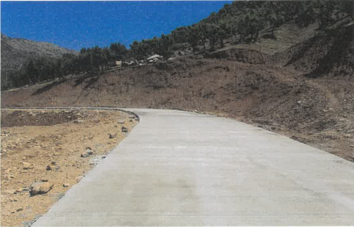
Merkez ilçesi Yeşilöz Köy yoluna Büz yerleştirme işi
