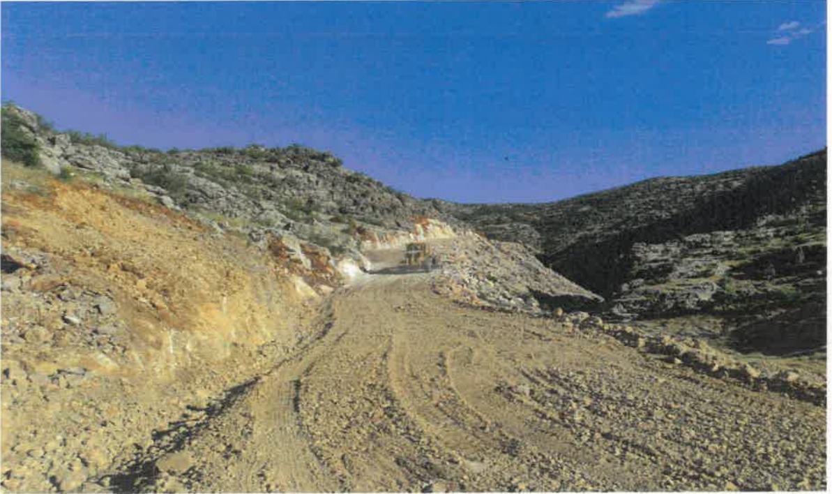
Kozluk ilçesi Gündüzlü Köyü Köy Girişi Beton Yol Yapım İşi
