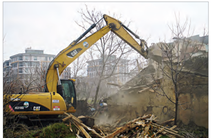
Metruk Bina Yıkımı
