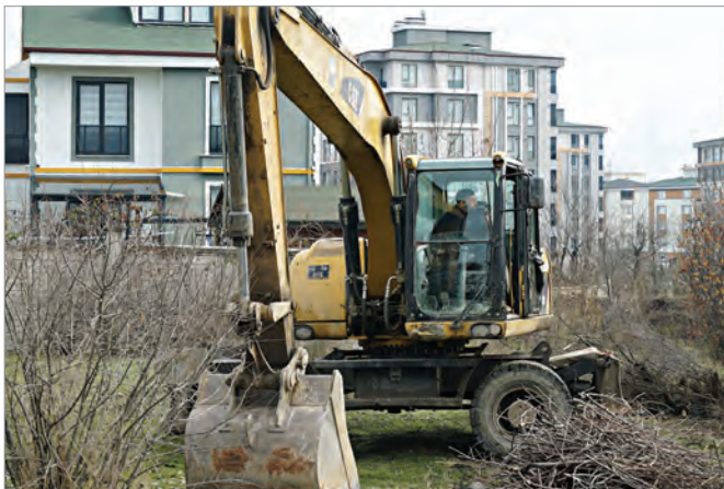
Metruk Bina Yıkımı
