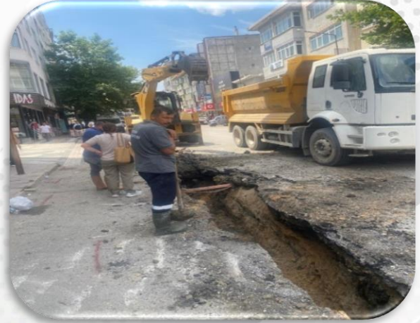
İçme ve Kullanma Suyu Hattı Döşeme Çalışmaları
