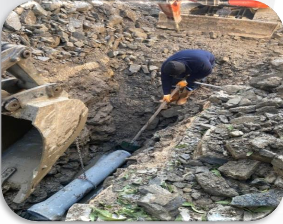
Kanalizasyon Hattı Döşeme Çalışmaları
