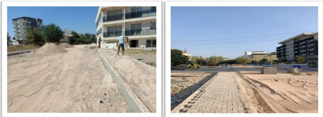
Resim 152 Parke Taşı Yol Çalışması
