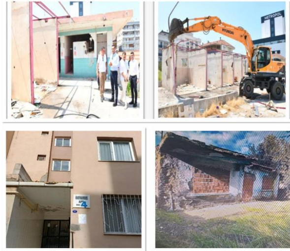
Resim 142 Riskli Yapı Tespiti, Güvenli Hale Getirme Ve Yıkım Çalışmaları
