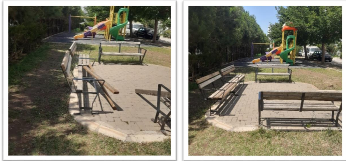
Resim 64 Bank Bakım/Tamirat Çalışması
