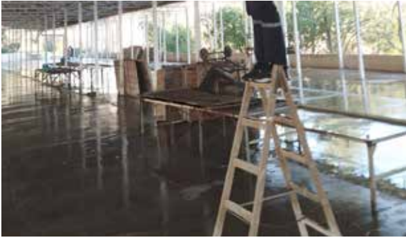
SEVGİ MAHALLESİ PAZARYERİ AYDINLATMA ONARIM İŞİ
