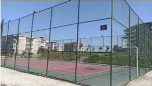
3 FİDAN PARKI BASKETBOL SAHASI AYDINLATMA İŞİ
