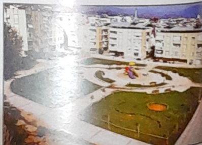
Yaklaşık 2000 m²'lik alanda Park ve Bahçeler Müdürlüğüne projelendirilmiş olan park çalışmalarına Fen işleri müdürlüğü, su, yağmurlama ve kanalizasyon, bordür, parke taşı kaplama, elektrik direkleri dikilerek parkın aydınlatılması yapılmıştır. Vatandaşlarımız rahatlıkla dolaşip dinlenebilecekleri, çocuklarımızın ise güvenli oynayabilecekleri, etrafının koşu yolu olarak tasarlanarak hem Fitness spor aletleri çocuklarımızın oyun oynayabilecekleri uygun konulup parkın etrafında yeşillendirme çalışmaları yapılmıştır.
