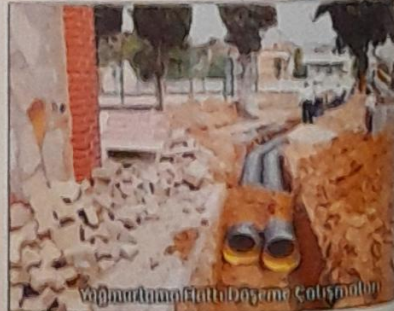
Kanalizasyon Hattı Döşeme Çalışmaları
