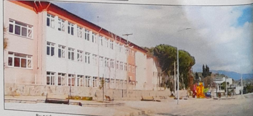
Bu parkımızın diğer bölümüne vatandaşlarımız için oturma grubu bank monte edilmiştir.
