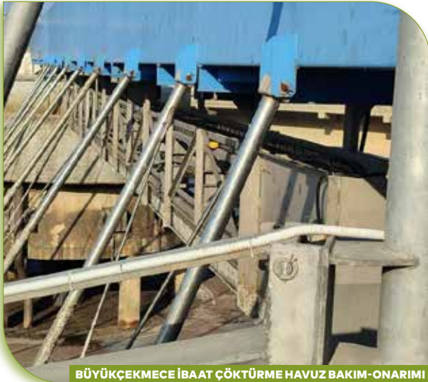
BÜYÜKÇEKMECE İBAAT ÇÖKTÜRME HAVUZ BAKIM-ONARIMI
