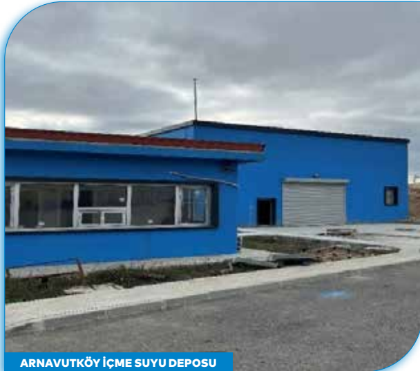
ARNAVUTKÖY İÇME SUYU DEPOSU
