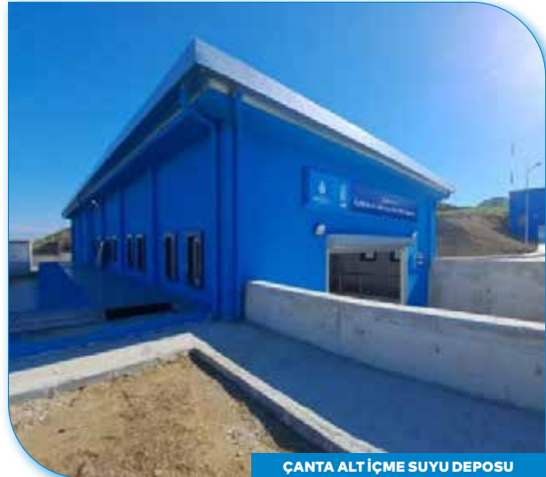
ÇANTA ALT İÇME SUYU DEPOSU
