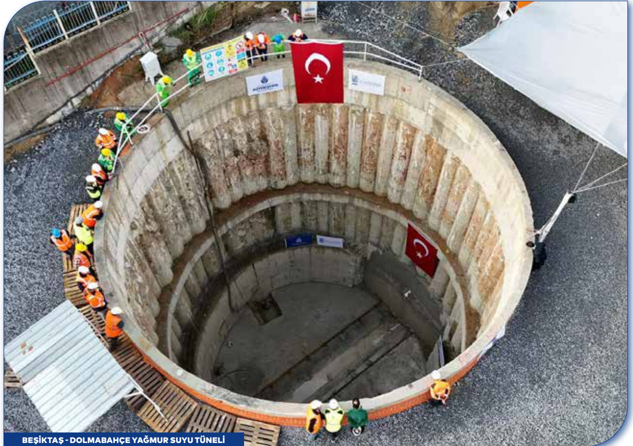
BEŞİKTAŞ - DOLMABAĞÇE YAĞMUR SUYU TÜNELİ
