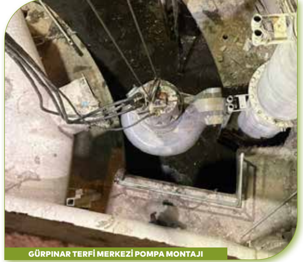
GÜRPINAR TERFİ MERKEZİ POMPA MONTAJI
