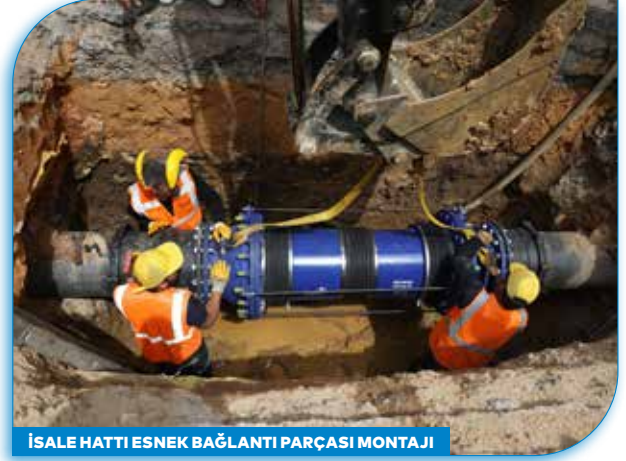
İSALE HATTI ESNEK BAĞLANTI PARÇASI MONTAJI
