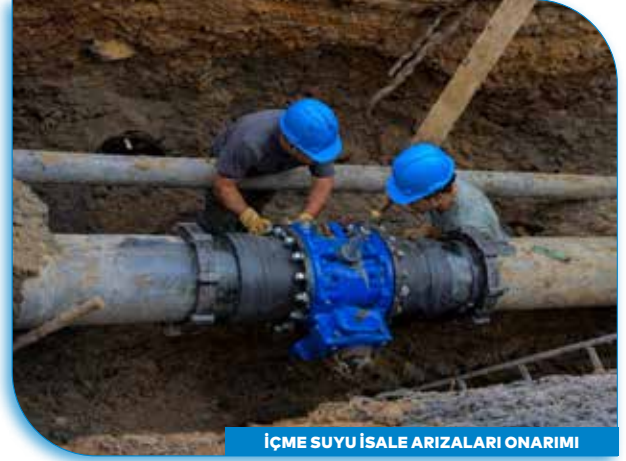
İSALE HATTI ESNEK BAĞLANTI PARÇASI MONTAJI
