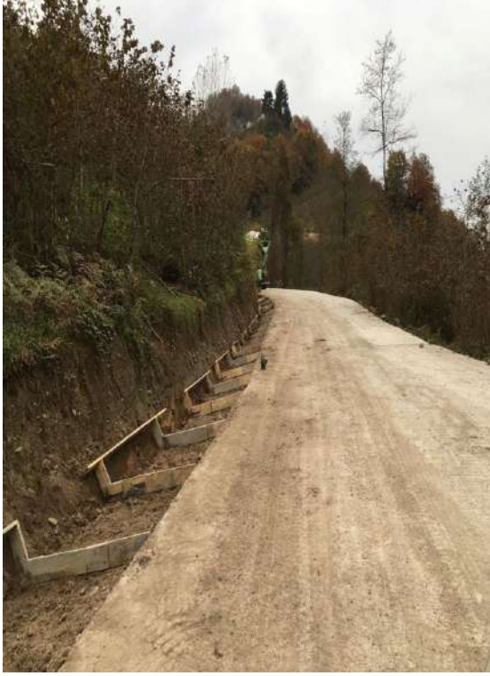
Akkese - Yağızlı Mahallesi Beton Yol- V Kanal Çalışması İlk/Son Hali
