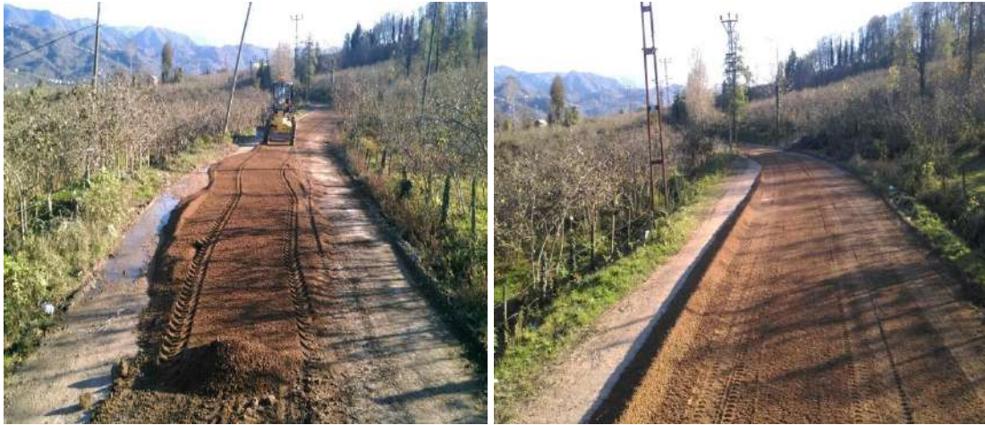
Karapınar Mahallesi Yol Genişletme Bakım-Onarım Çalışması
