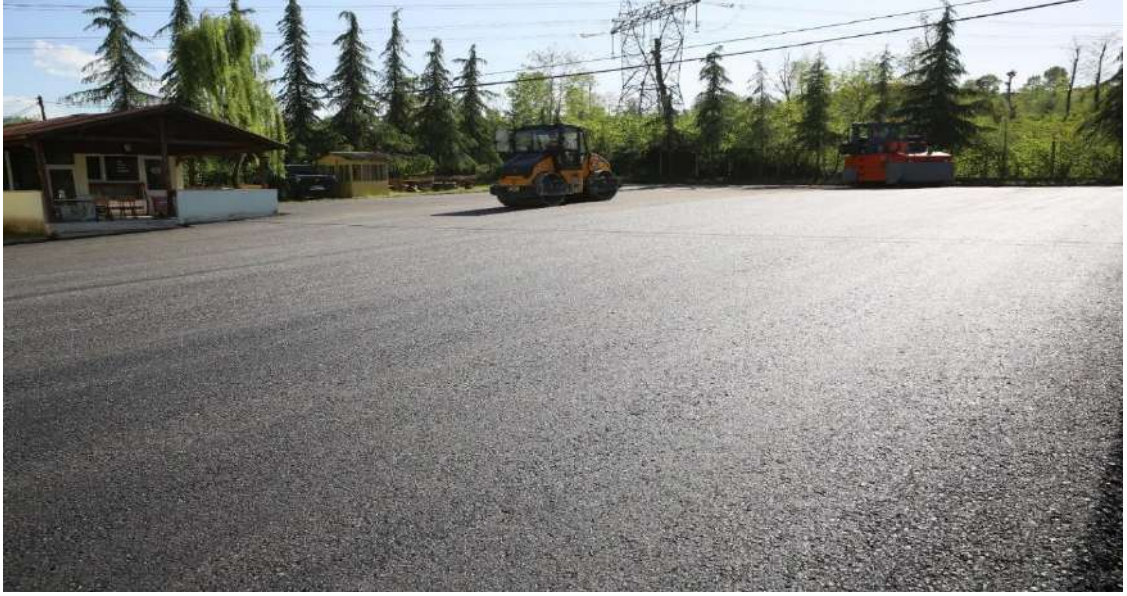
Kökenli Mahallesi Kamyon Garajı Asfaltlama Yapım İşi
