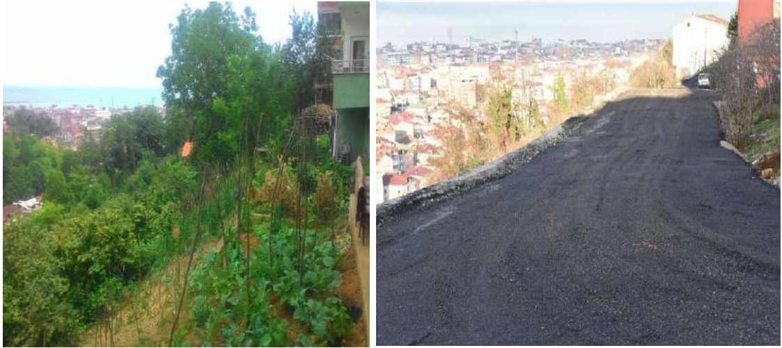
Bucak Mahallesi 403. Sokak İmar Yolu Çalışması İlk/Son Hali
