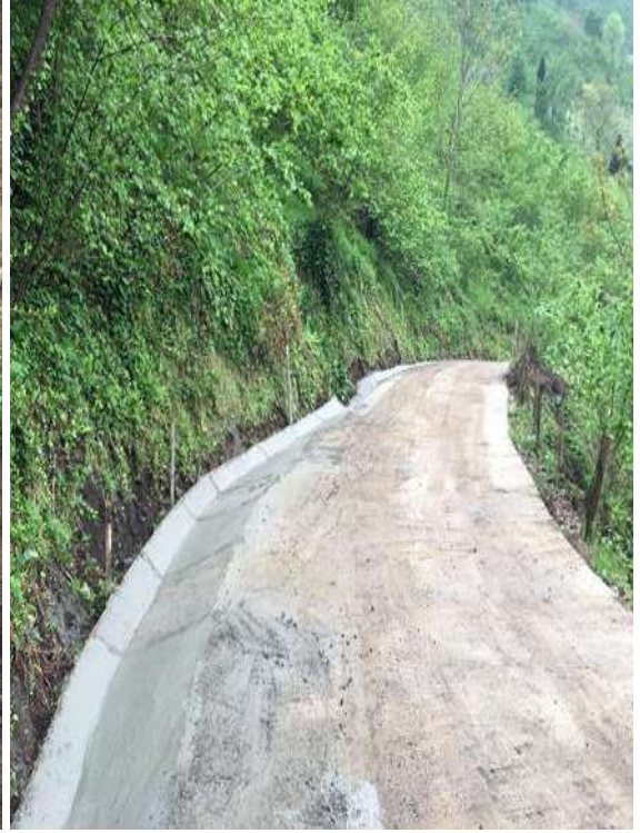
Ataköy Mahallesi Erikli Sokak Beton Yol- V Kanal Çalışması İlk/Son Hali
