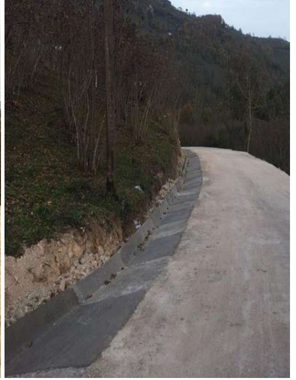
Akkese - Yağızlı Mahallesi Beton Yol- V Kanal Çalışması İlk/Son Hali
