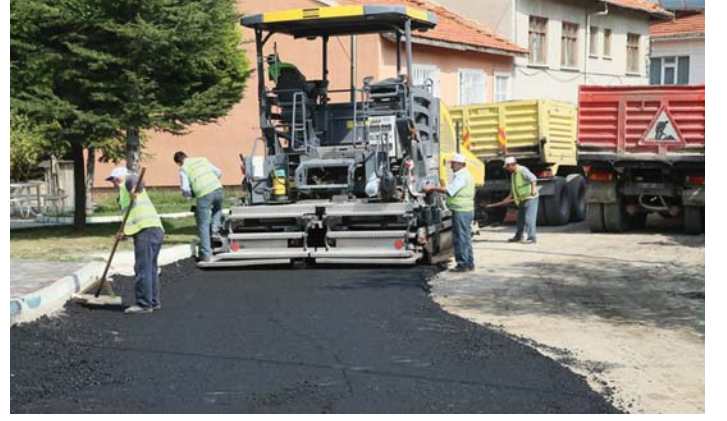
OKMEYDANI MAHALLESİ SOKAK ÇALIŞMASI-2017
