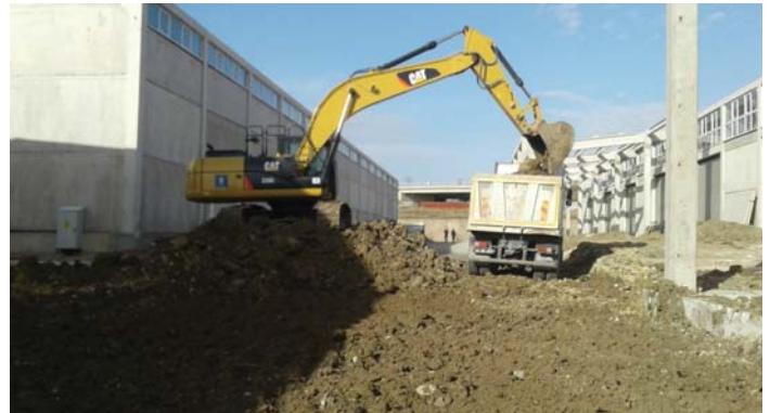
Yeni Bosna Mahallesi Kimyacılar Sitesi Yol Çalışması-2017
