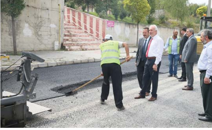
75.YIL(ATAKENT) MAHALLESİ CADDE ÇALIŞMASI-2017
