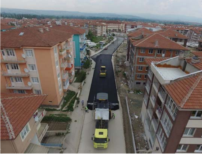
DUMLUPINAR MAHALLESİ ZAFER CADDESİ YOL ÇALIŞMASI-2017
