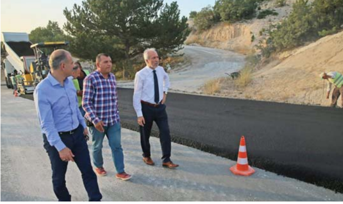
KIRGILLI MAHALLESİ YOL ÇALIŞMASI-2017
