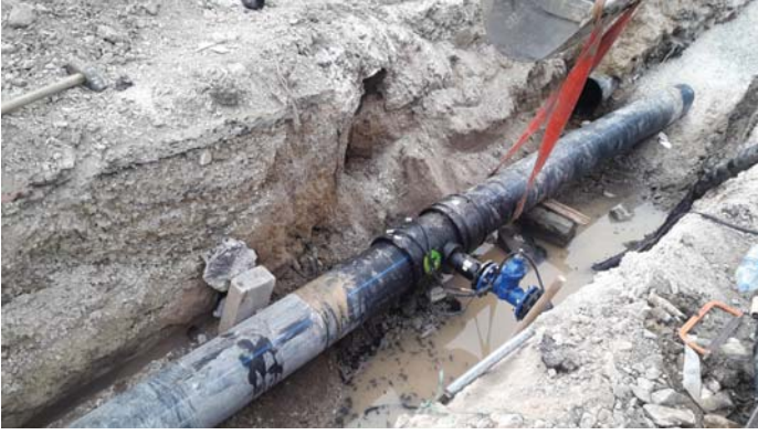
Sakıp Sabancı Caddesi TCDD İçmesuyu Hattı Deplase Çalışmaları
