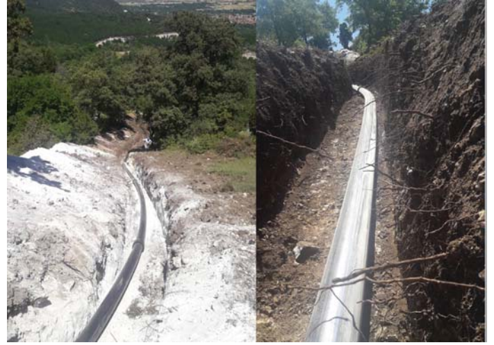
Çamlıca Bölgesi İçmesuyu Deposundan Aydoğdu İçmesuyu Deposu Arasına Döşenen Terfi Hattı
