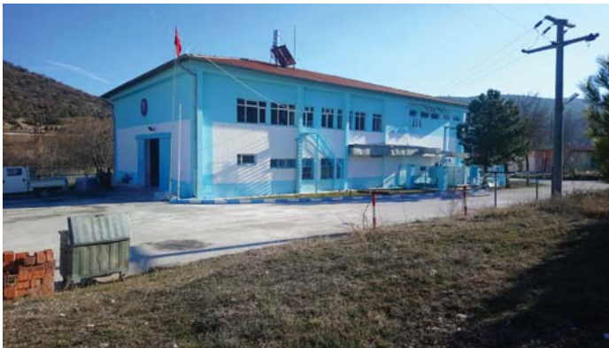
Porsuk İçmesuyu Tesisimiz
