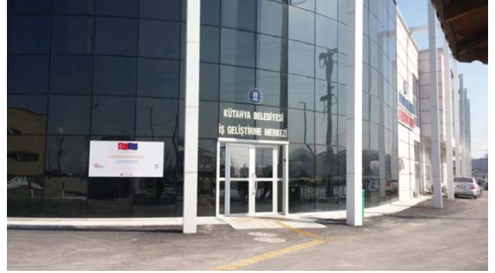
Resim 10: Kütahya İş Geliştirme Merkezi Binaları Yeni Bina
