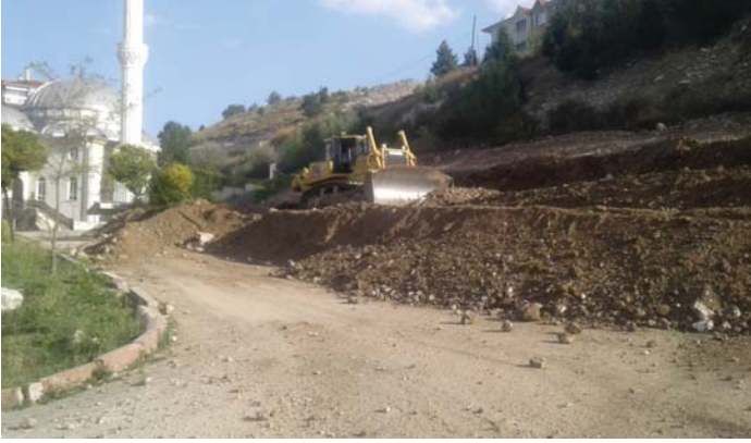
Yoncalı Mahallesi 120 Metrelik Yolun 40.Metre Şev Kesim Çalışması
