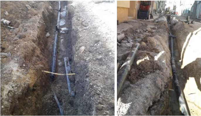
Meydan Mahallesi Hat Yenileme Çalışmaları
