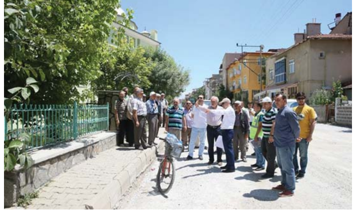
BAHÇELİ EVLER MAHALLESİ ÇUBUK CADDESİ YOL ÇALIŞMASI-2017
