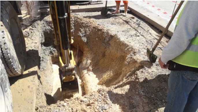
Yunus Emre Mahallesi Selimiye Caddesi İçmesuyu Hat Çalışması
