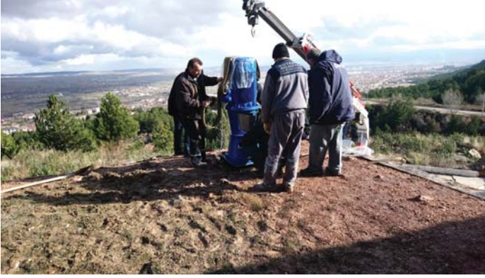
Çamlıca Depo Dik Milli Pompa Kurma Çalışması
