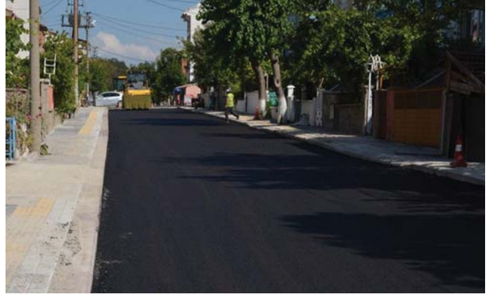
EVLİYA ÇELEBİ MAH. DUAGÜR CADDESİ ASFALT ÇALIŞMASI-2017
