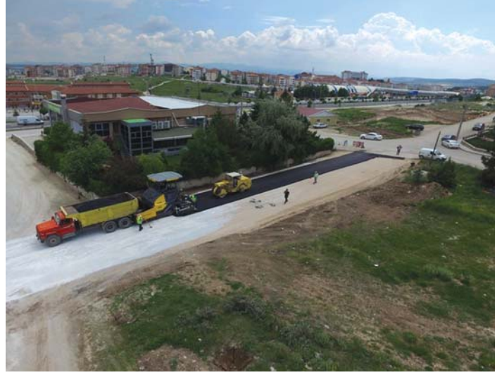
100.YIL(SOSYAL KONUTLAR) MAHALLESİ YOL ÇALIŞMASI-2017
