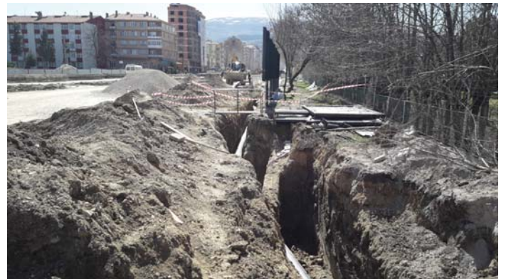
Atatürk Bulvarı TCDD İçmesuyu Hattı Deplase Çalışmaları
