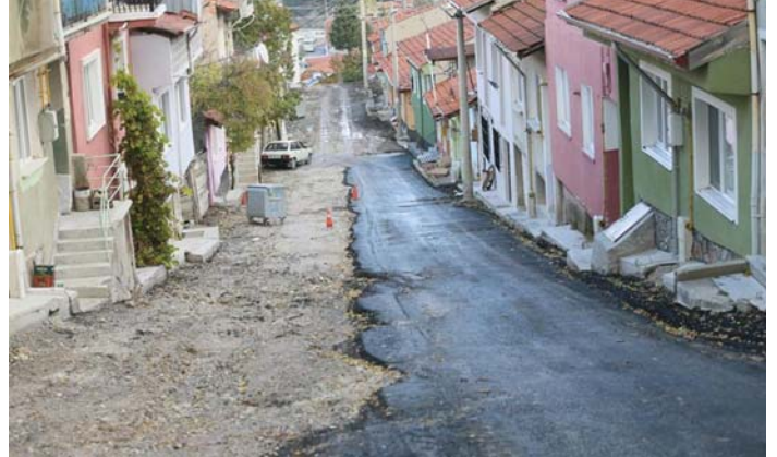
GÜLTEPE MAHALLESİ SOKAK ÇALIŞMASI-2017
