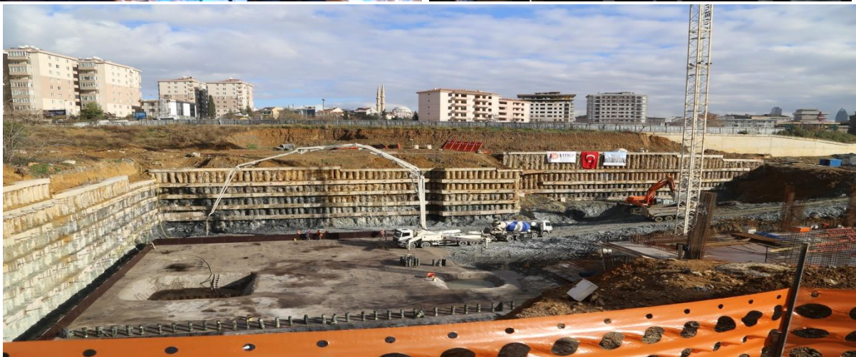
Resim: Merkez Araştırma Laboratuvarımızın Temel Atma Töreninden Görünüm
