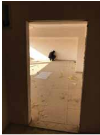
Soğukkuyu Atölyesi İç Mekanda Devam Eden İnşaat Görünümü
