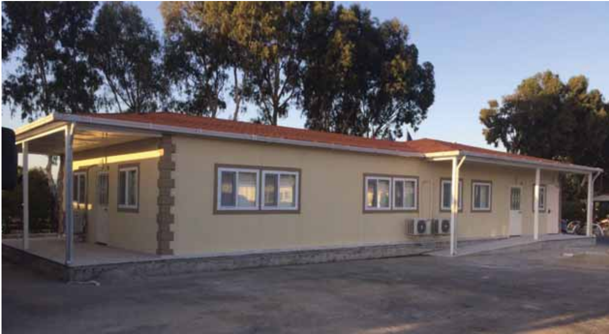
Ulaşım Bölge Müdürlüğü Prefabrik İdari Bina Görünümü
