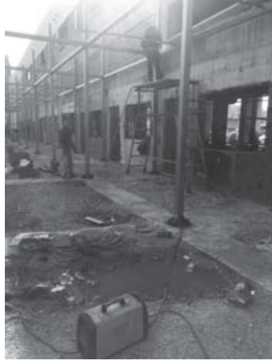
Soğukkuyu Atölyesi Arka Ofisler Devam Eden İnşaat Görünümü
