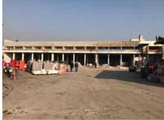
Çiğli Atölye ve Garaj Tesisleri Fırça İç Görünümü
