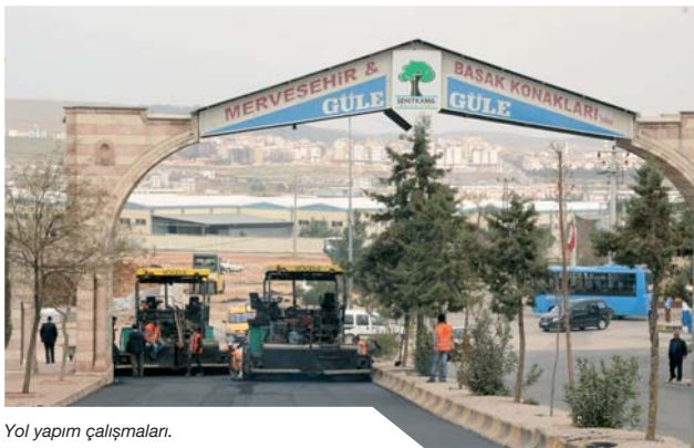
Yol yapım çalışmaları.
