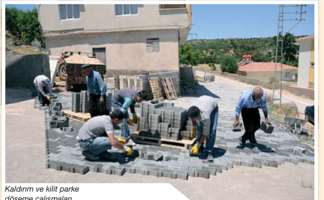
Kaldırım ve kilit parke döşeme çalışmaları.
