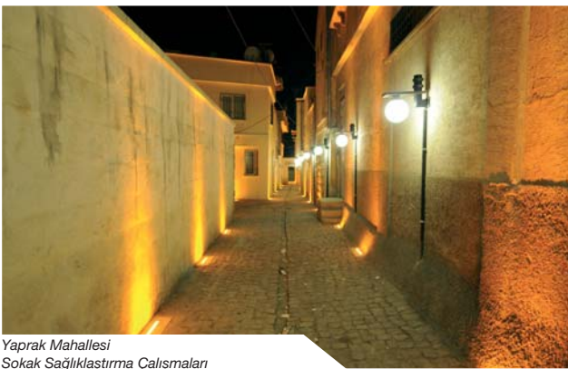
Yaprak Mahallesi Sokak Sağıklaştırma Çalışmaları
