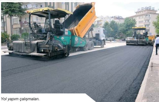
Yol yapım çalışmaları.
