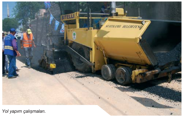
Yol yapım çalışmaları.
