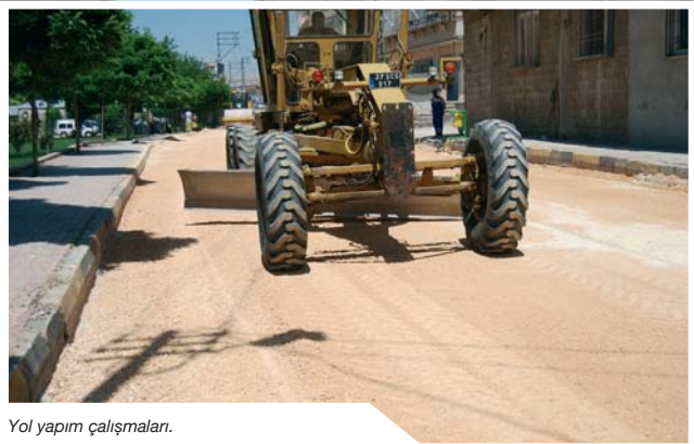
Yol yapım çalışmaları.
