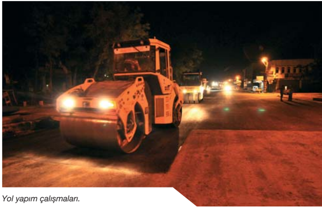
Yol yapım çalışmaları.
