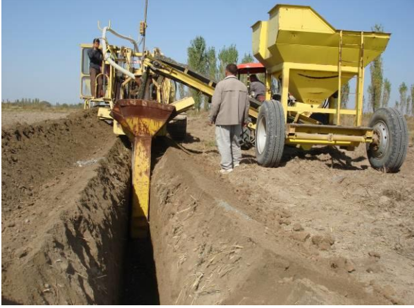
Drenaj Borusunun Döşenmesi
