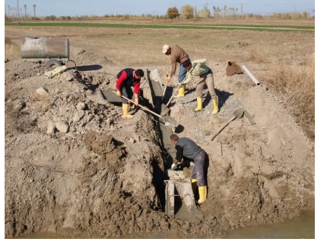
Beton Başlık Yapımı
