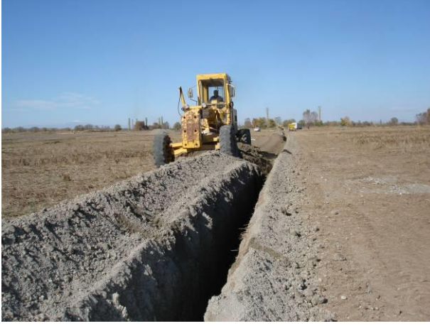
Döşenmiş Drenaj Hattının Kapatılması
