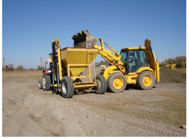
Kum Treylerine Filtre Malzemesi Yüklmesi
