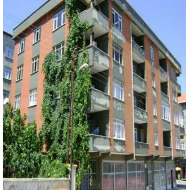
İlçemizde 6306 Sayılı Afet Riski Altındaki Alanların Dönüştürülmesi Hakkındaki Kanun Kapsamında Riskli Yapı Tespiti Yapılan Bina Örneği
