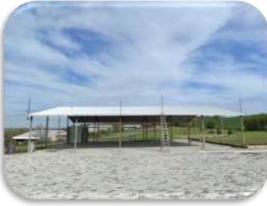
Vakıfıdemir Mahallesi Çok Amaçlı Salon Tadilatı
