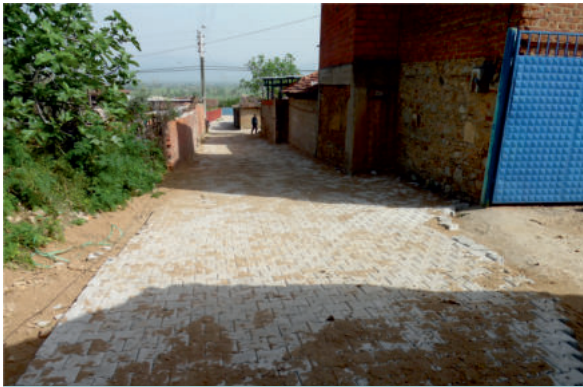
Balabanlı mahallesi kilit parke taş döşeme
