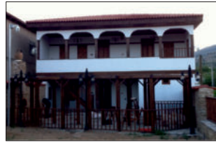
Kayaköy Çakırcalı Mehmet Efe Konağı Restorasyonu
