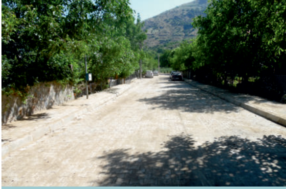
Bozdağ mahallesi kilit parke taş döşeme
