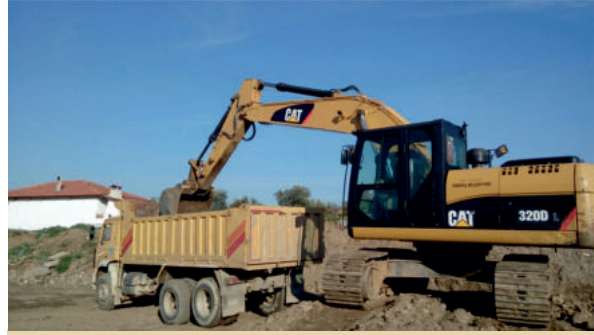
Üretim ve ulaşım yollarında stabilize dolgu çalışmaları yapıldı
