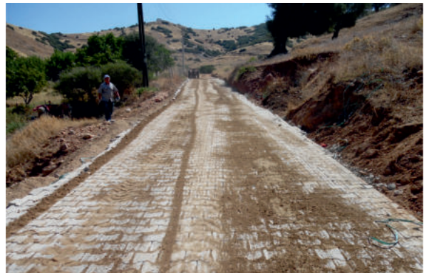
Alaşarlı mahallesi kilit parke taş döşeme
