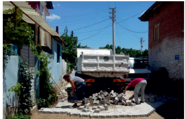
Çaylı mahallesi kilit parke taş döşeme
