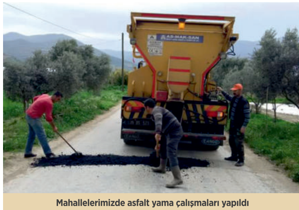
Mahallelerimizde asfalt yama çalışmaları yapıldı
