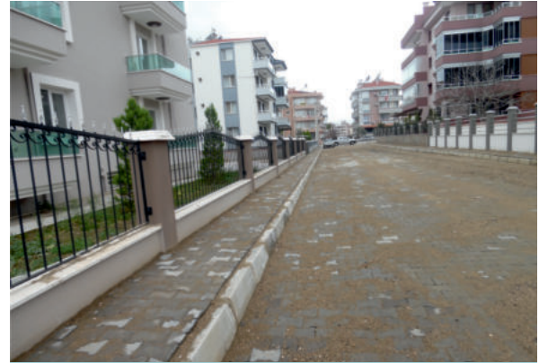
1385 sokak kilit parke taş döşeme
