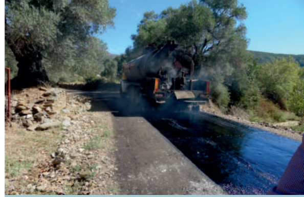
Bayırlı-Oğuzlar yolu asfaltlama
