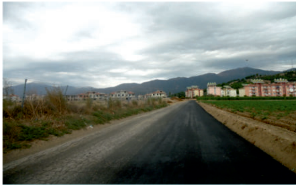
Yenikent-Birgi yolu asfaltlama
