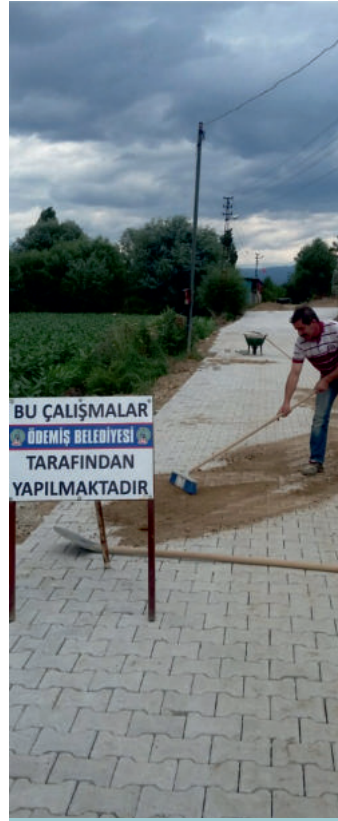
Mesçitli mahallesi kilit parke taş döşeme
