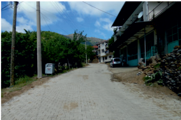
Güney mahallesi kilit parke taş döşeme
