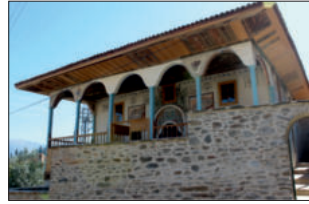
Bademli Kılıczade Mehmet Ağa Camii Restorasyon Uygulaması
