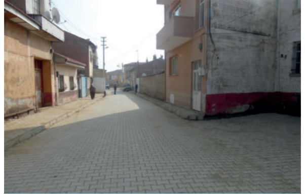
Alpaslan sokak kilit parke taş döşeme
