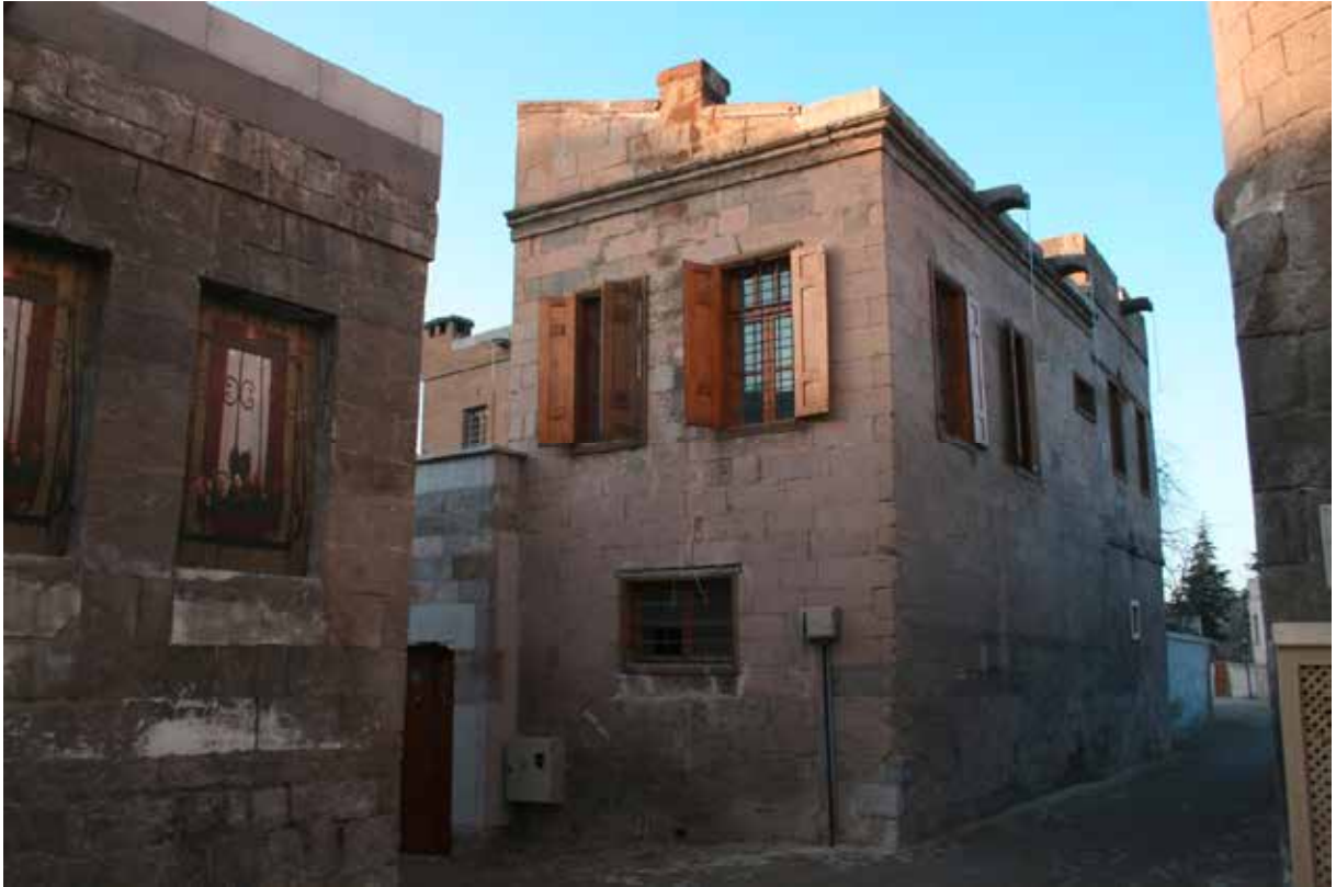
55 ADA 69 PARSEL/DERİ İŞLERİ ATÖLYESİ ONARIMI
