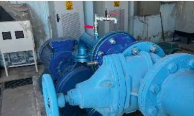
(Onkoloji İçme suyu Tesisi Yenilenen Motopomplar ve İnverter Panoları)
