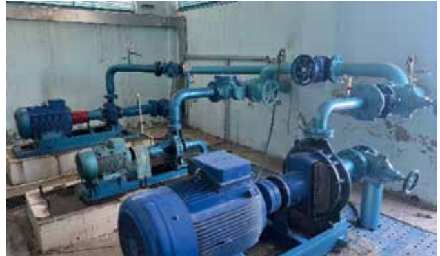
(Onkoloji İçme suyu Tesisi Yenilenen Motopomplar ve İnverter Panoları)
