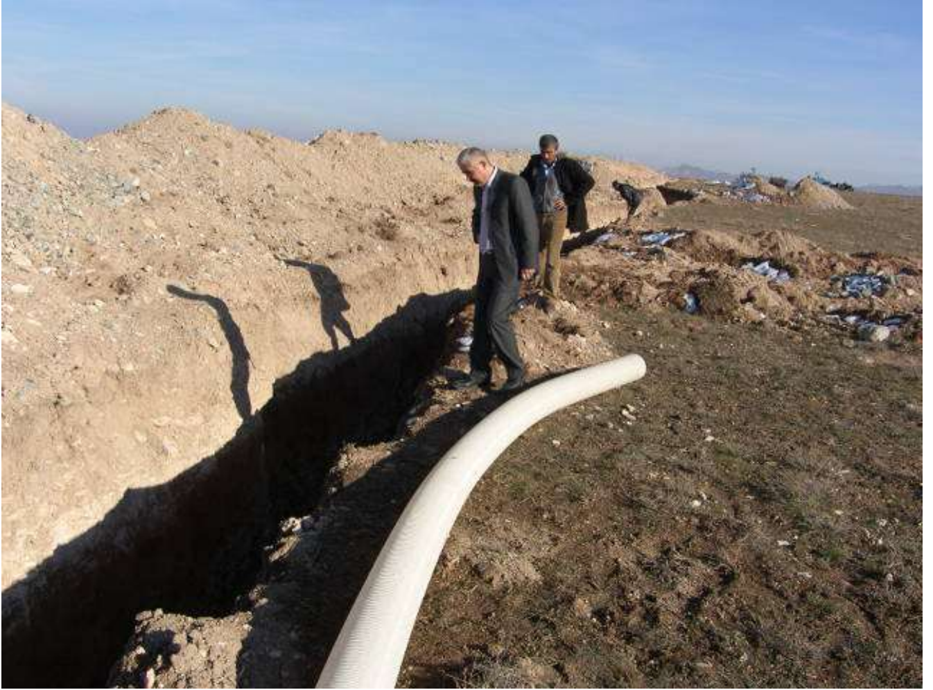
Acogöl Bađlıca Ky İmesuyu Drenaj alıřmaları
