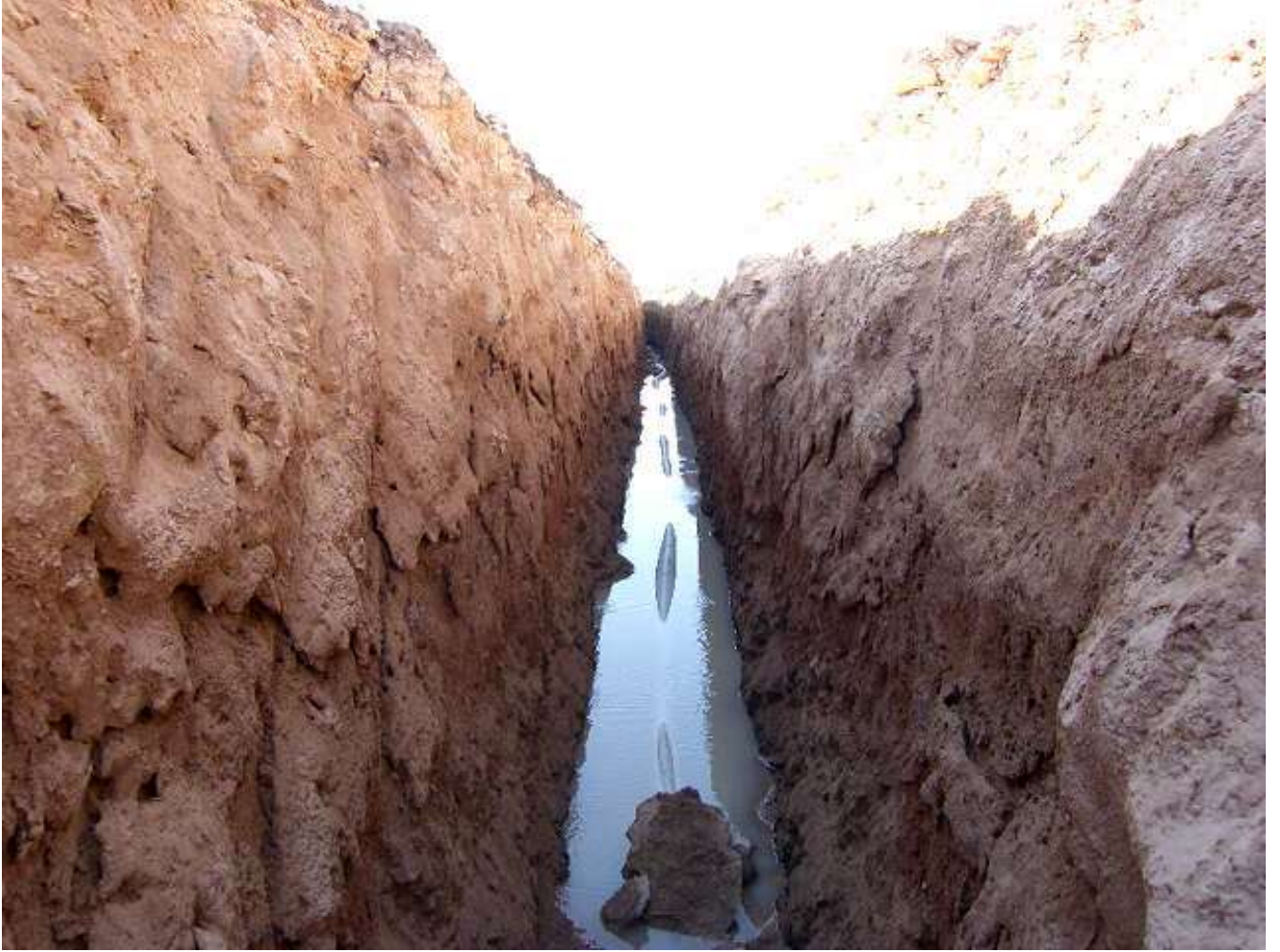
Acogöl Bađlıca Ky İmesuyu Drenaj alıřmaları
