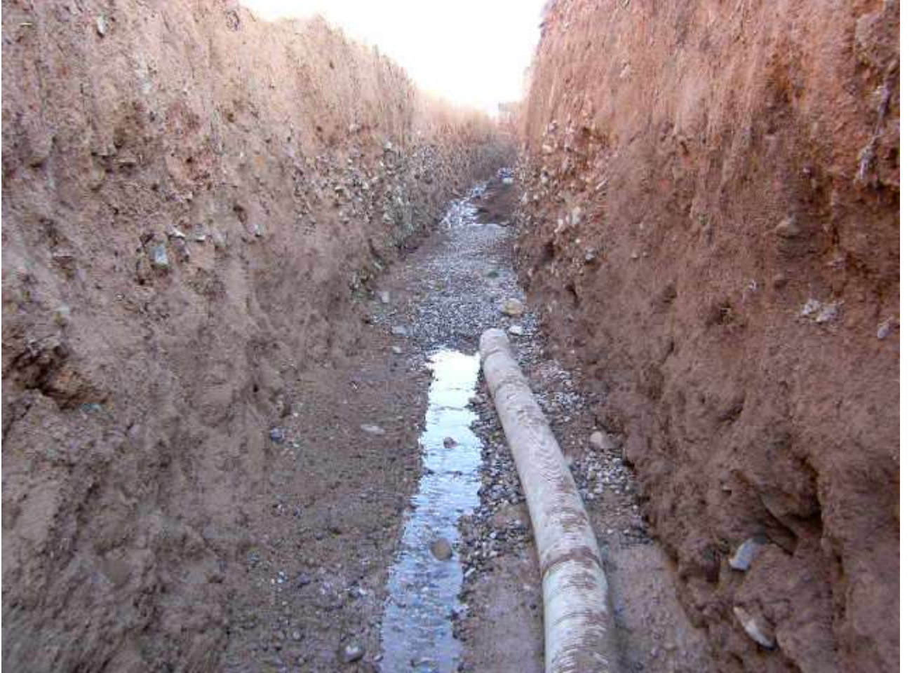
Acogöl Bađlıca K6yü İmesuyu Drenaj alıřmaları
