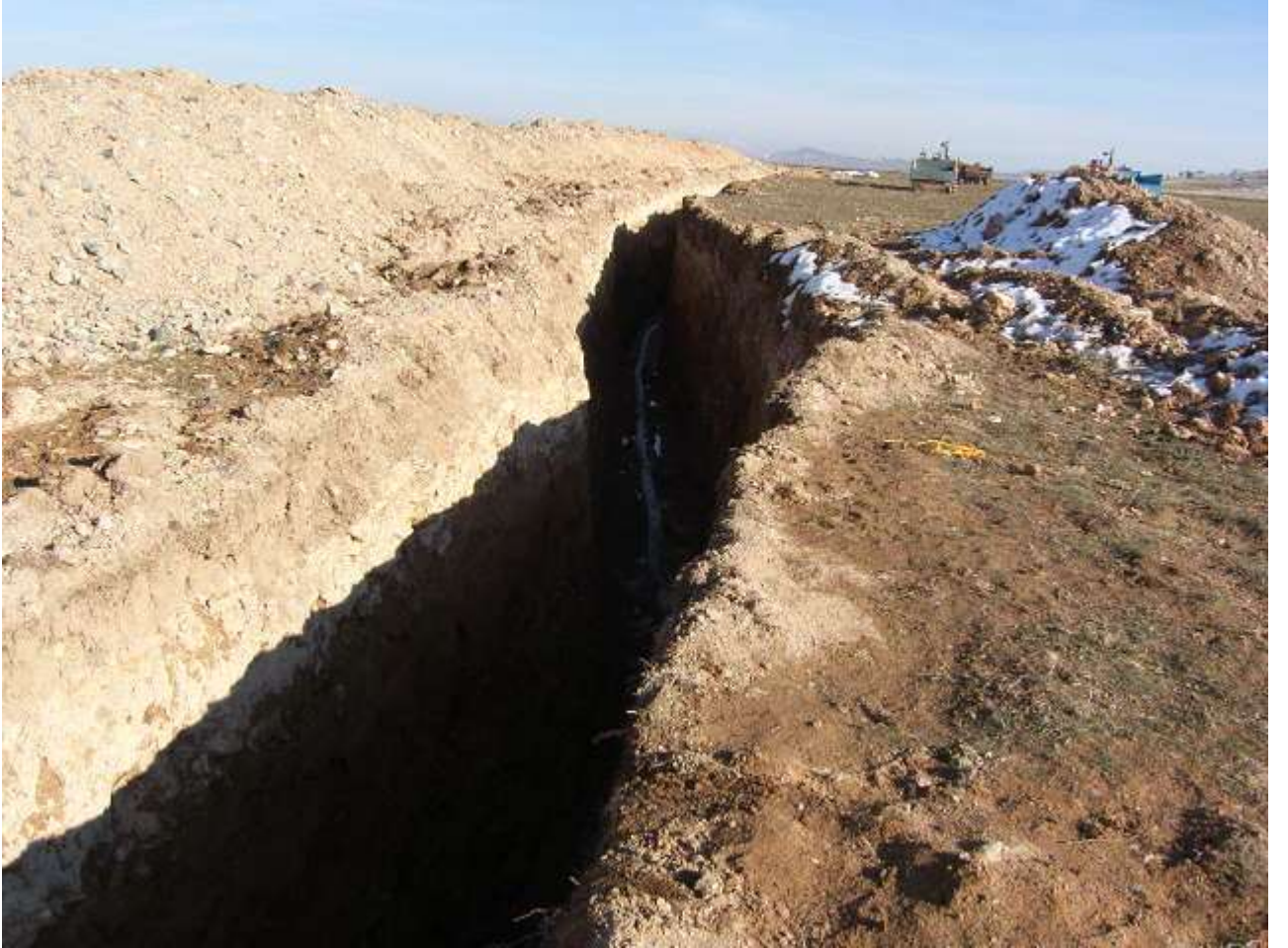
Acogöl Bađlıca K6yü İmesuyu Drenaj alıřmaları
