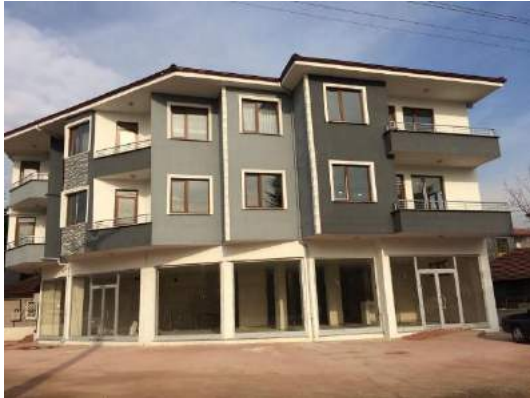
Fotoğraf 7 %95 Hakediş seviye kontrolü yapılmıştır.
