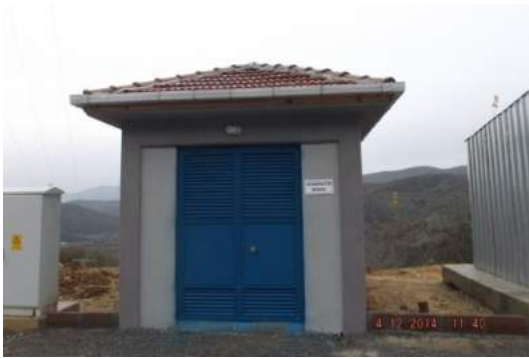
Fotoğraf 12 Jeneratör Binası
