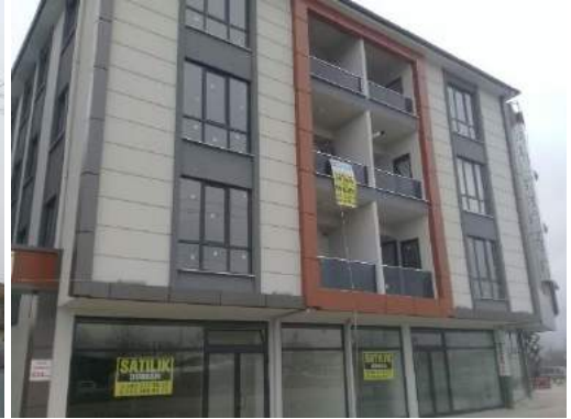
Fotoğraf 6 %90 Yapı kullanım izin belgesi seviye kontrolü yapılmıştır.
