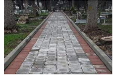
Fotoğraf 26 Beton Karo Taş Döşemesi
