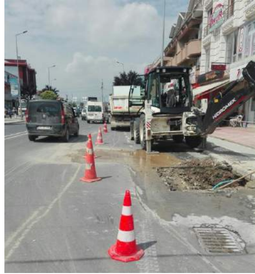
Cumhuriyet Mahallesi Muhtarlık binası Abone bağlantısı.90'lık ana borudan 15 metre 32mm orjinal kangal boru ile bağlantısı yapılmıştır.
