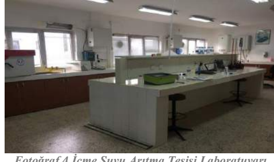
Fotoğraf 4 İçme Suyu Arıtma Tesisi Laboratuvarı
