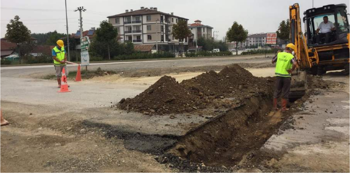
Cumhuriyet Mahallesi Muhtarlık binası Abone bağlantısı.90'lık ana borudan 15 metre 32mm orjinal kangal boru ile bağlantısı yapılmıştır.
