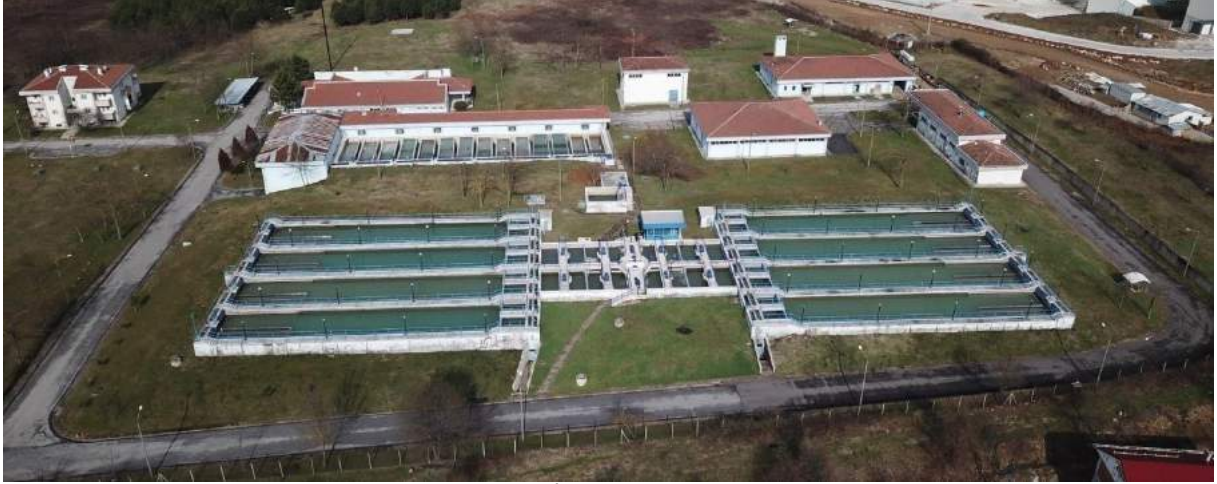
Fotoğraf 2 İçme Suyu Arıtma Tesisi
