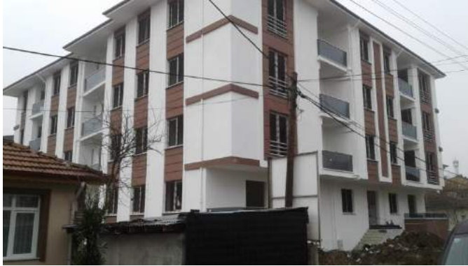
Fotoğraf 5 %80 yapı kullanım izin belgesi seviye kontrolü yapılmıştır.
