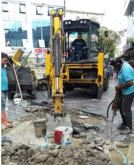
Gaziantep Caddesi 32'lik Abone arızası su arıza ekiplerimiz tarafından onarım yapılarak kapatılmıştır.
