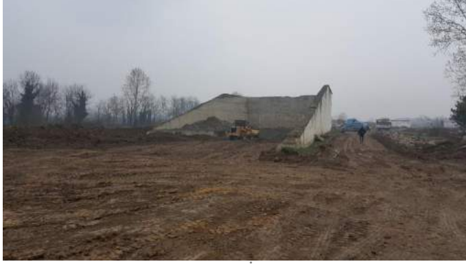
Fotoğraf 15 Konuralp Evsel Atık Aktarma İstasyonu Yapım Aşamasından Bir Görüntü
