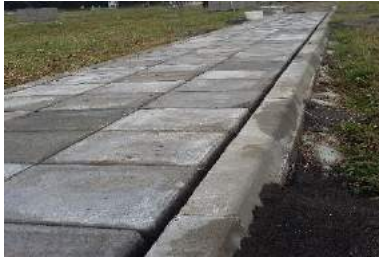
Fotoğraf 24 Beton Bordür
