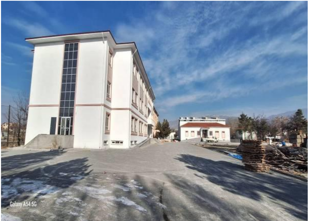
ERZİNCAN MERKEZ 16 DERSLİKLİ VE SPOR SALONU YAPIM İŞİ
