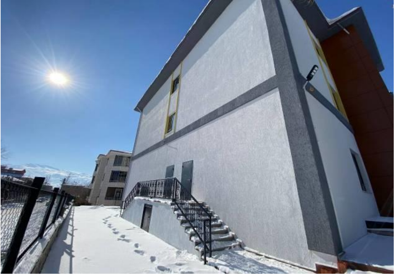
ERZİNCAN MERKEZ MEHMETÇİK ORTAOKULU EK BİNA YAPIM İŞİ
