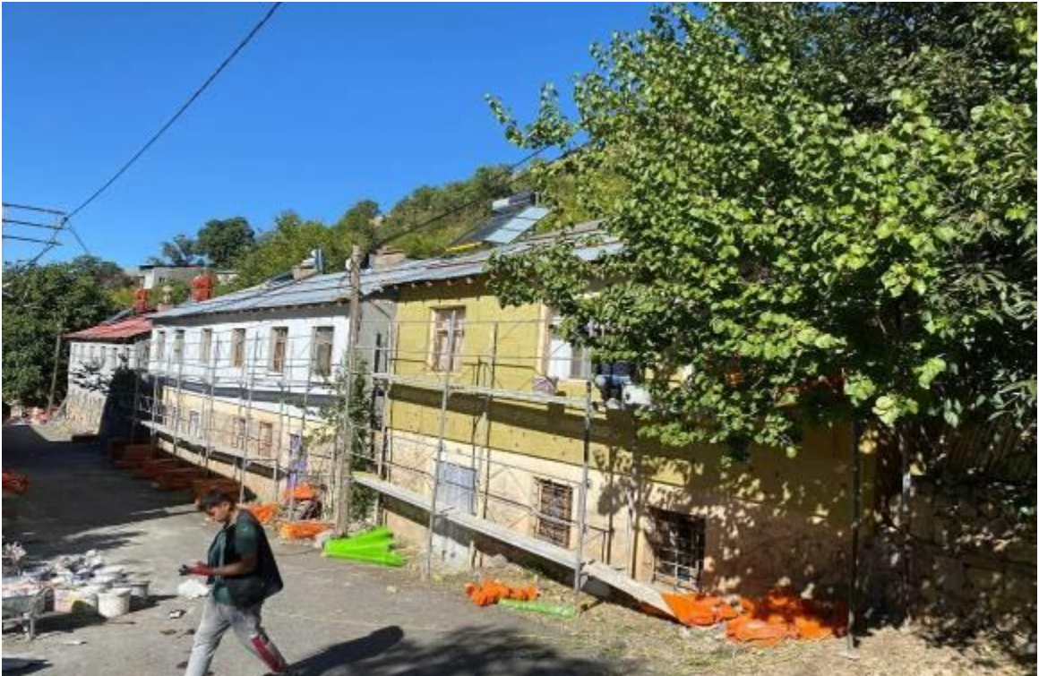
ERZİNCAN KEMALİYE İLÇESİ BAŞBAĞLAR KÖYÜ AFET KONUTLARI DIŞ CEPHE YALITIM YAPIM İŞİ
