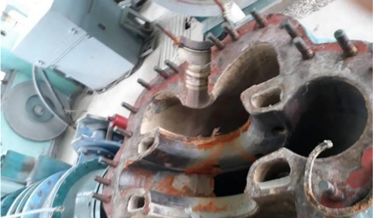
P1 - P2 Pompa İstasyonları Bakımı
