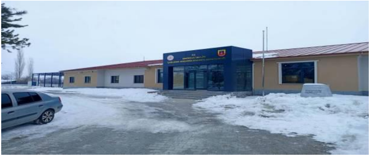
ERZİNCAN ÇAĞLAYAN JANDARMA KARAKOL YAPIM İŞİ
