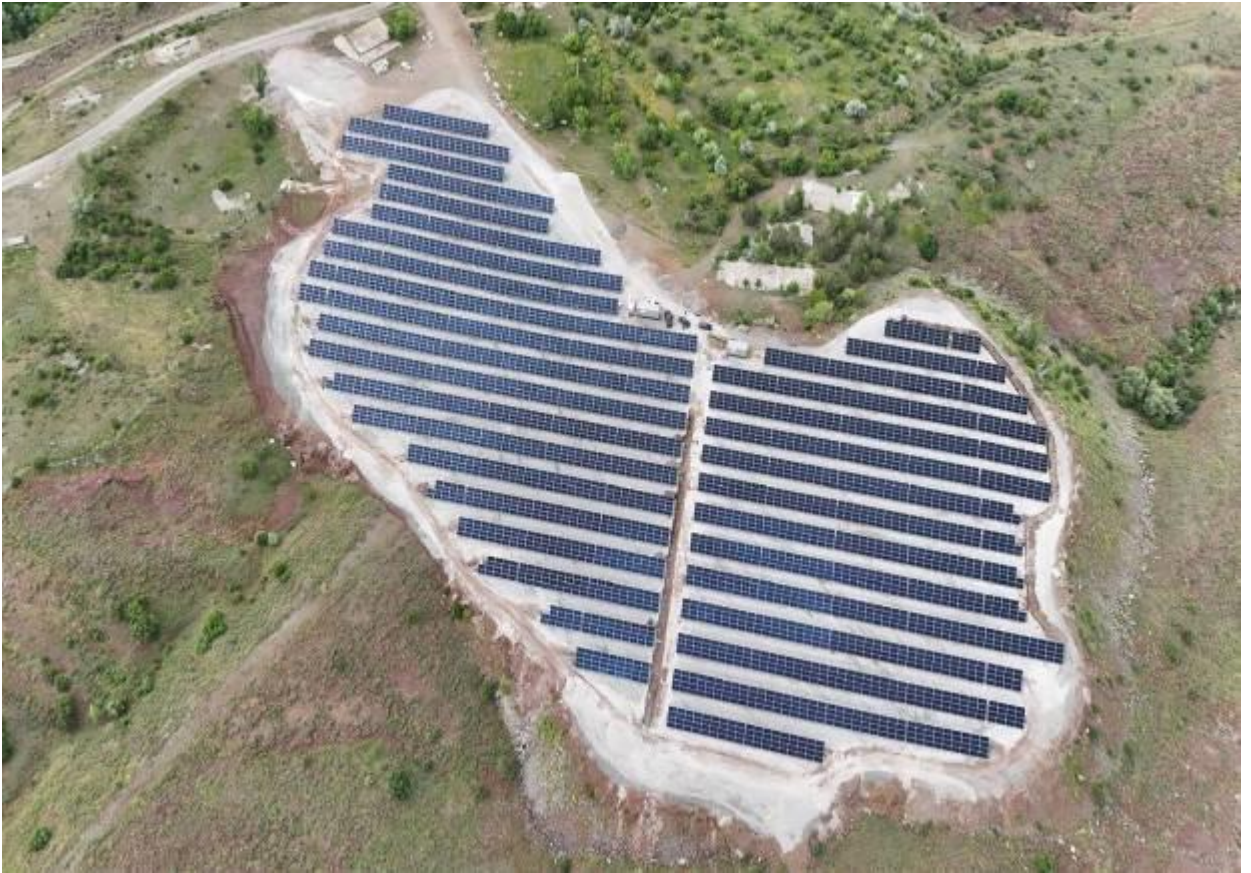
ERZİNCAN MERKEZ ÇATALARMUT KÖYÜNDE 2400 KW GES YAPIM İŞİ
