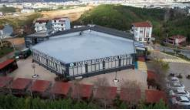
Çayirova Belediyesi Merkez Sosyal Tesisi
