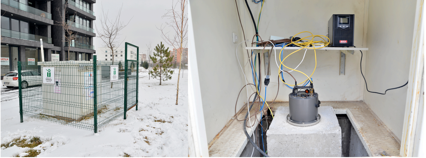
Deprem İzleme İstasyonu ve İç Yapısı (Batıkent)
