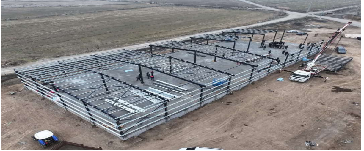
Soğuk Hava Deposu Yapım İşi
