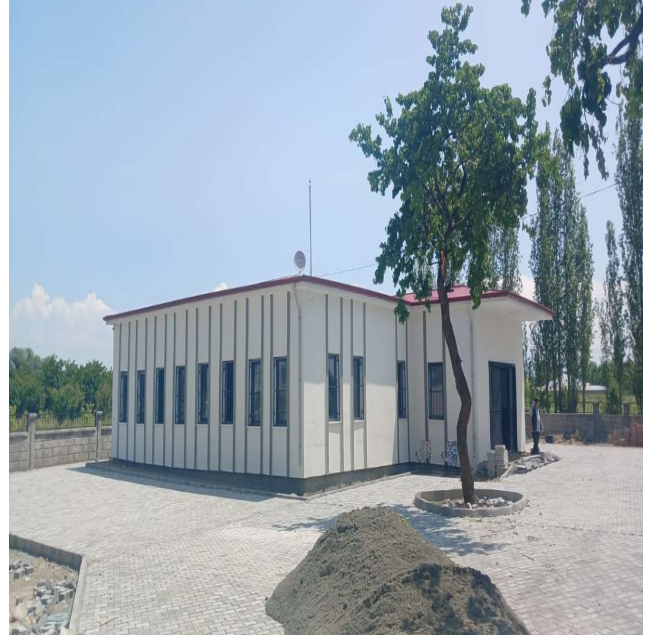
Taşburun ASM Yapım İşi
