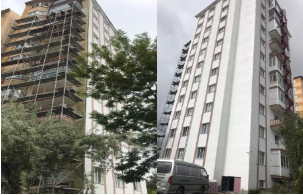
Dış Cephe Bakım Onarım
