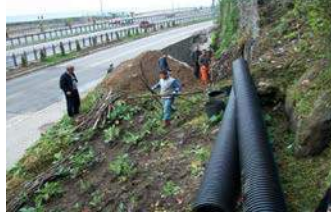
23-Kale Mah. Atatürk Bulvarı Askerlik Şubesi arkası ve yurt binası yanı kanalizasyon şebekesi yapımı.
