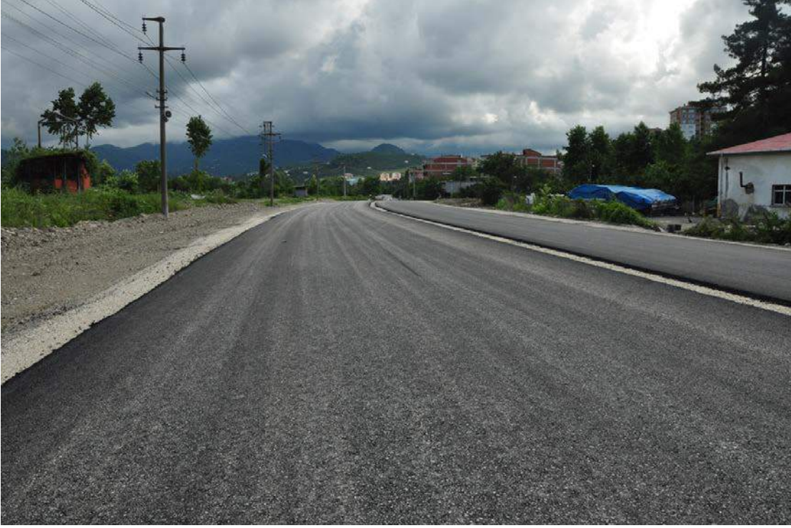
Aksu Mah. Pazar Sok. Asfaltlama Çalışması
