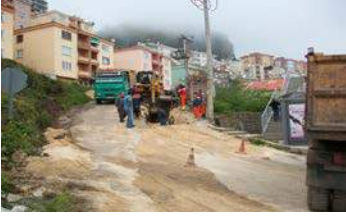
42-Gedikkaya Mah. Mercan Sok. da kanalizasyon ve yağmur suyu şebekesi yapılması
