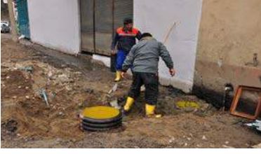
19-Gedikkaya Mah. Sanayi Sitesi 27 Nolu Sokak da kanal şebeke tamiri yapılması.
