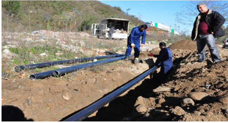
37-Teyyaredüzü Mah. Mollaoğlu Sok. da yeni içme suyu şebekesi yapımı
