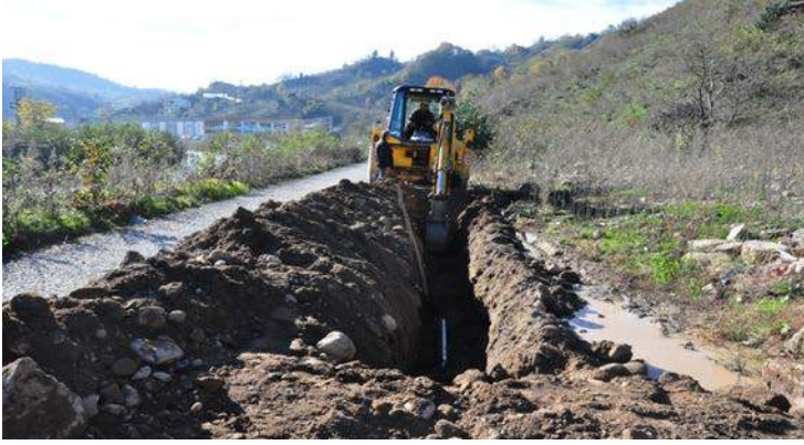
36-Teyyaredüzü Mah. Boztekke Cad. Yeşim Sok. da yeni içme suyu şebekesi yapımı.
