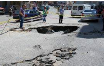
48-Orhan Yılmaz Cad. G-City önü yol çökmesine bağlı kanalizasyon hattı tamiri
