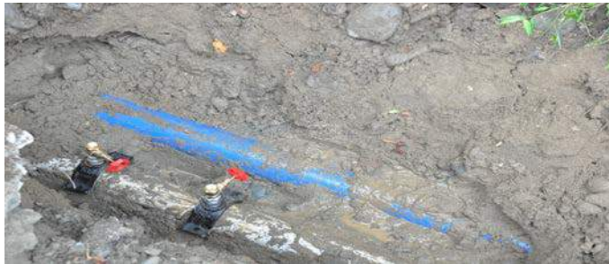
7- Küçükköy Mahallesi Sarvan Yoluna yeni içme suyu şebeke hattı yapılması
