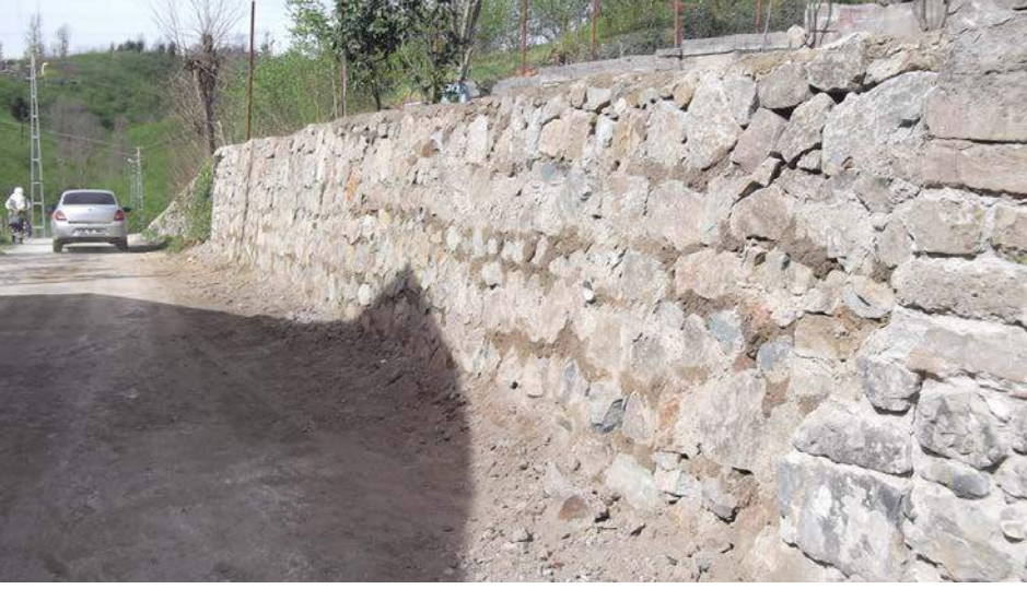
Kavaklar Mahallesi Tutkun Sokak
