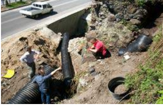
24-Çınarlar Mah. Erkut Sok. da kanalizasyon şebeke hattı yapımı
