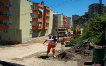
43-Gedikkaya Mah. Tez-Kop Sitesi arkası yeni açılan yolda kanalizasyon ve yağmur suyu şebekesi yapılması
