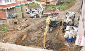
8-Aydınlr Mah. Ada Hastanesi yanı Kanalizasyon Hazır Pompa İstasyonu yapıldı.
