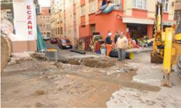
7-Fevziçakmak Mah. Kent Hastanesi karşısı ve Özgür Sok. da kanalizasyon şebeke hattı yapıldı.
