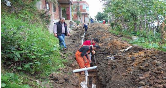
37-Teyyaredüzü Mah. Mollaoğlu Sok. da yeni içme suyu şebekesi yapımı
