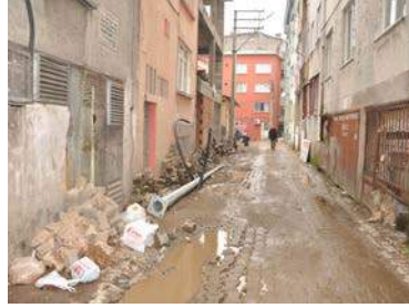
57-Kapukahve Mah. Çayırboğazı Sokak da yağmur suyu şebekesi ve ızgarası yapılması
