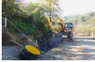
20-Gaziler Mah. 159 Nolu Sok. da kanalizasyon şebekesi yapılması
