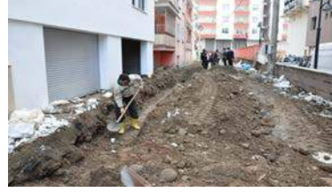
13-Çıtlakkale Mah. Petek Sok. da yeni kanalizasyon şebekesi yapımı
