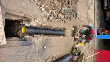
21-Büyük ve Küçük Güre Köprü ayaklarından kanalizasyon terfi hattı yapımı
