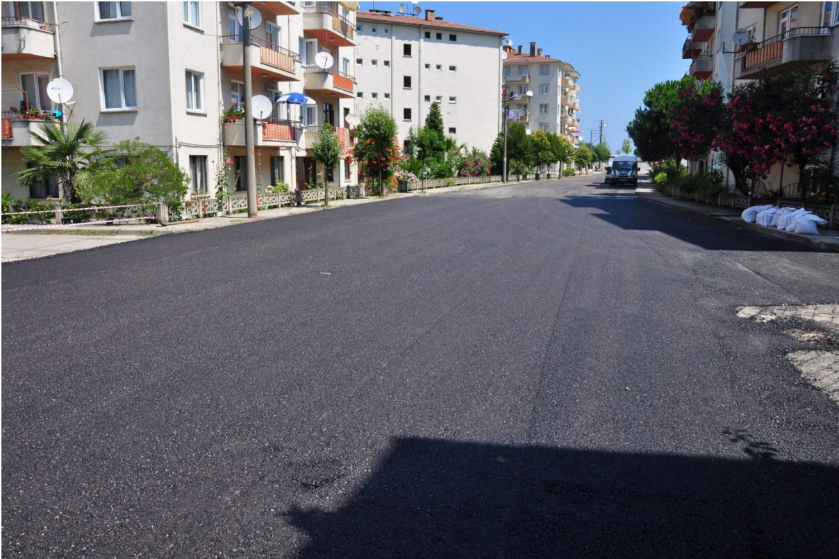
Teyyaredüzü Mah. Virandere Sok-Karabekir-Kısmet Ve 148 Nolu Sokakta Asfaltlama Çalışması
