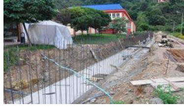
12-Çıtlakkale Mah. Batlama Toki Evleri yanı yağmur sularını toplamak için menfez yapıldı.
