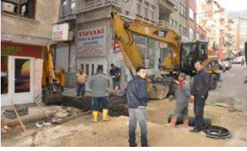
8-Aydınlr Mah. Ada Hastanesi yanı Kanalizasyon Hazır Pompa İstasyonu yapıldı.
