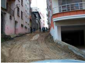
50-Hacıhüseyin Mah. Aydın Sok. da kanalizasyon şebeke hattı yenileme çalışması
