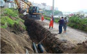
43-Gedikkaya Mah. Tez-Kop Sitesi arkası yeni açılan yolda kanalizasyon ve yağmur suyu şebekesi yapılması
