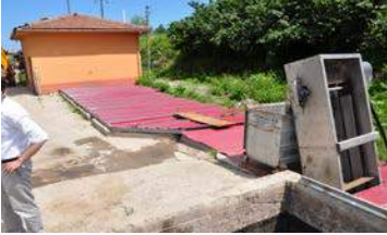
9-Aksu Mah. Kanal Terfi Merkezinde kaba ızgara ve revizyon çalışması yapıldı.
