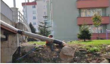
21-Büyük ve Küçük Güre Köprü ayaklarından kanalizasyon terfi hattı yapımı
