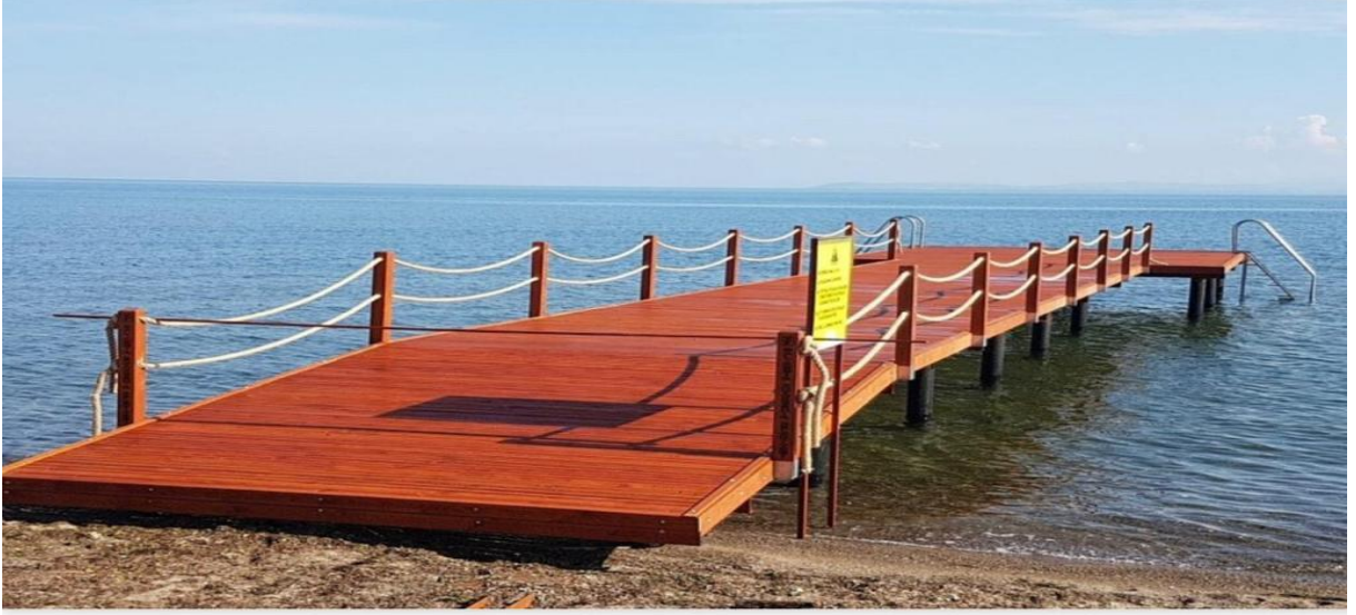
Edremit İlçesine ait ahşap iskele
