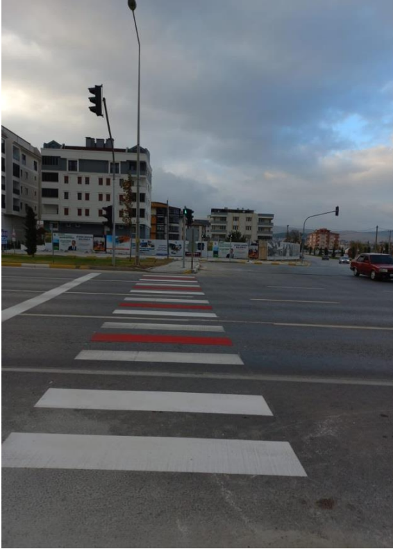
Karesi İlçesi Sanayi 2. Kapı Sinyalize Yaya Geçidi
