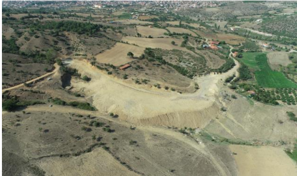
Sındırgı İlçesi Islah Çalışmaları
