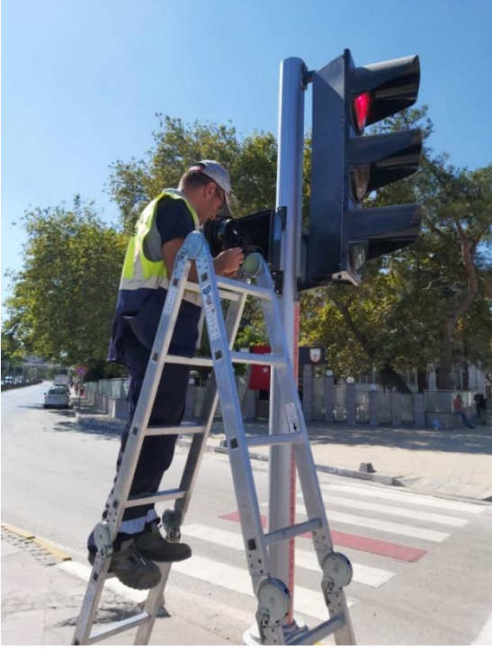
Karesi İlçesi İstasyon Kavşağı Sinyalizasyon Sistemi Bakım, Onarım Çalışması
