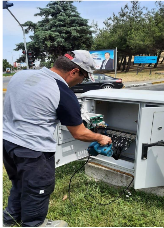
Karesi İlçesi Adnan Menderes Anıt Kavşağı Sinyalizasyon Sistemi Bakım, Onarım Çalışması
