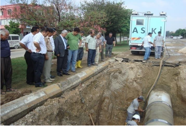
M.Kemal Paşa Blv.1000 Çaplı CTP Boru Onarımı
