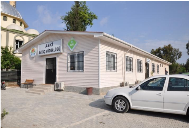
Sayaç Müdürlüğü Hizmet Binası
