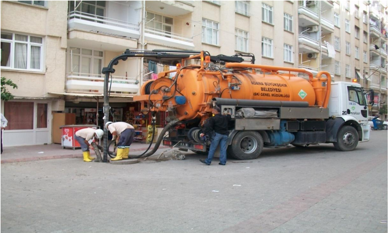
Vakumlu araç ile kanalizasyon tıkanıklığına müdahale işleminden bir görünüm.
