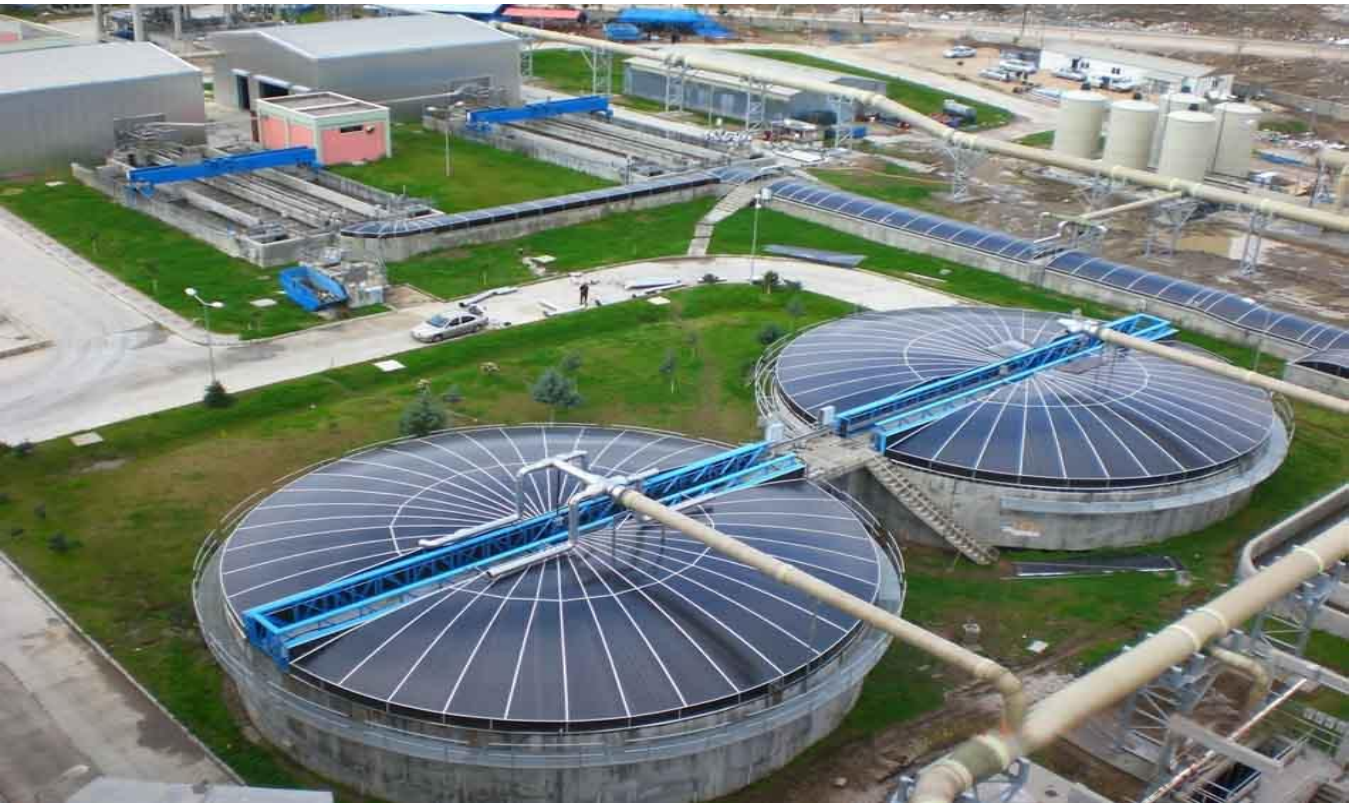
Yüreğir Atıksu Arıtma Tesisi koku giderim tesisinden bir görünüm
