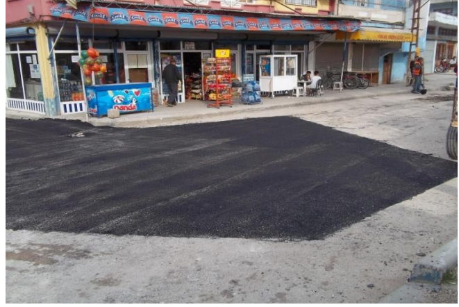
Asfalt uygulama işlemi.
