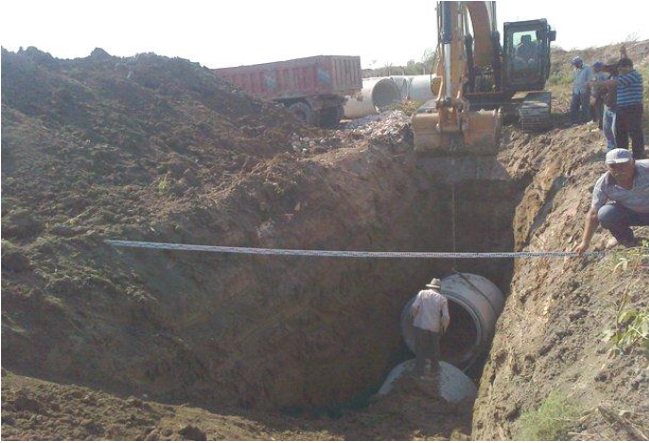
B6 Kanalizasyon Kollektör Döşenmesi
