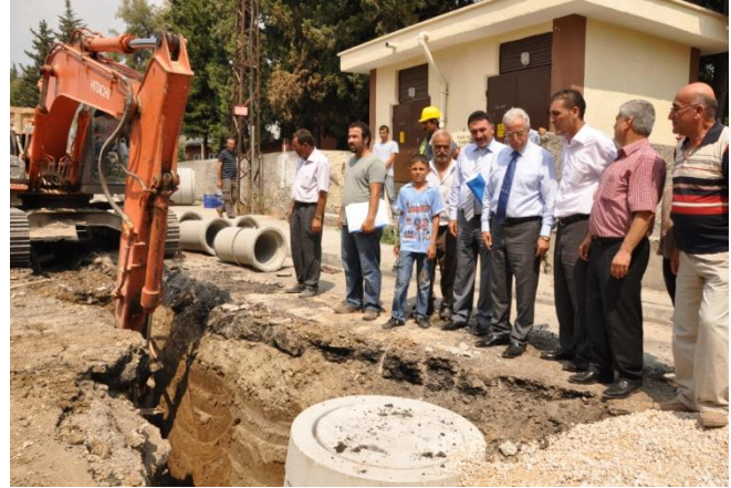
Kanalizasyon Şebekesi Döşeme Çalışması
