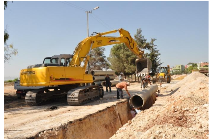
Turgut Özal Bulv. içme suyu Şebekesi Döşeme
