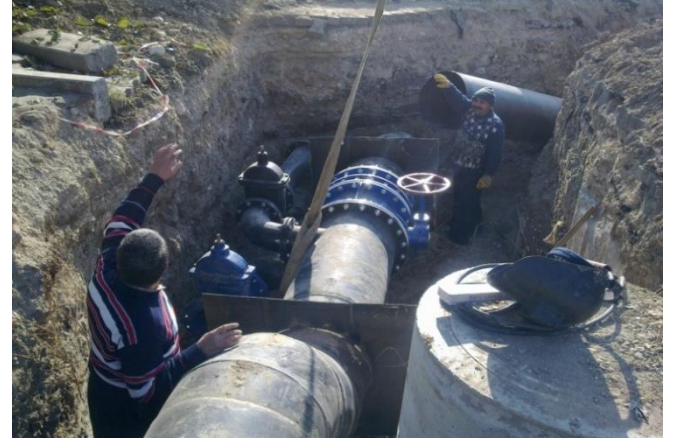
Karataş içme suyu Şebekesi Vana Odası Yapımı
