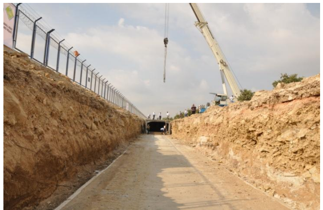
TD8 Yağmur Suyu Baks İnşaatı Yapımı
