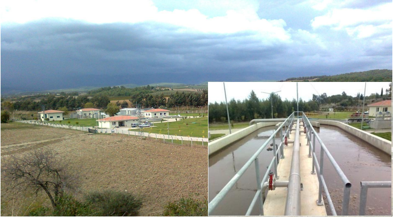
Karaisalı Atık Su Arıtma Tesisinden bir görünüm
