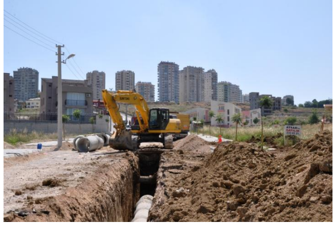
Aşıklar Bulv.Kanalizasyon Şeb. Döşeme
