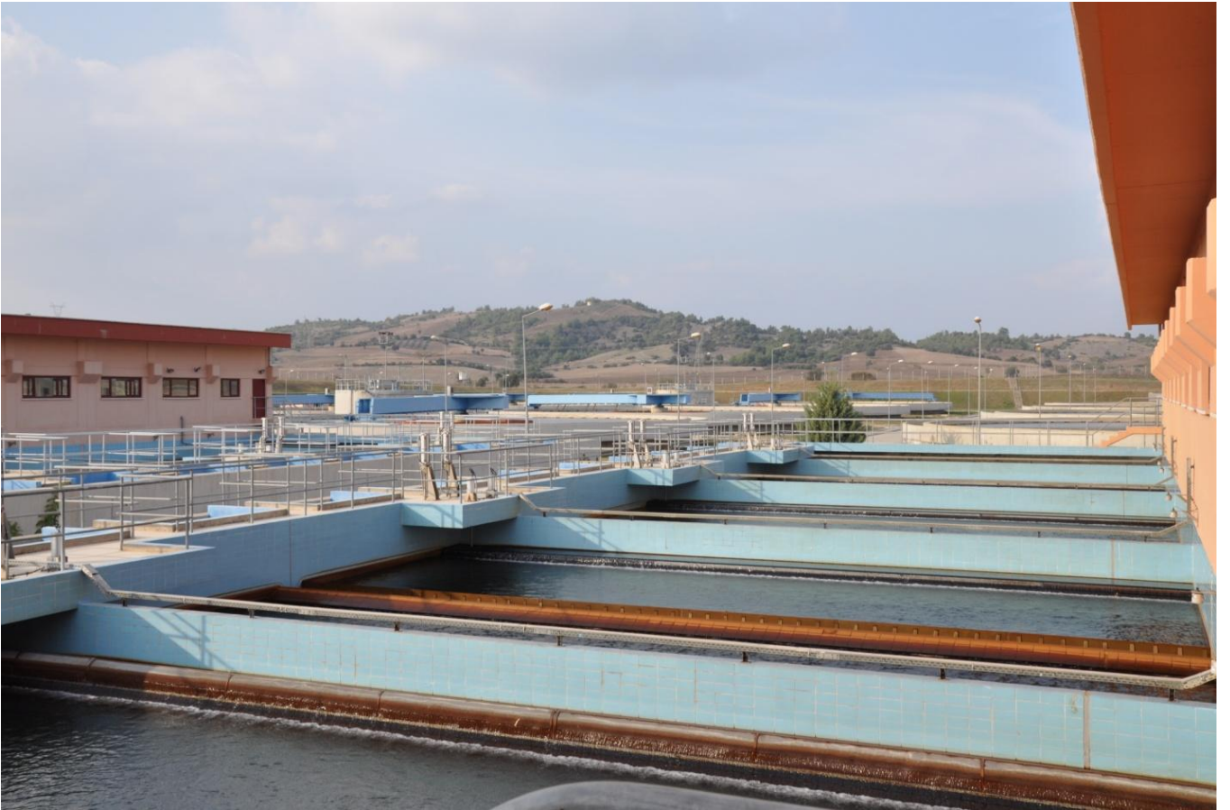
Çatalan İçmesu Arıtma Tesisi filtre havuzlarından bir görünüm
