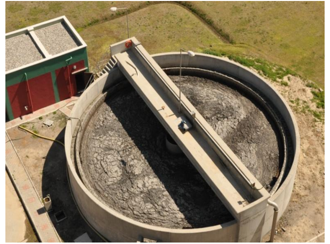
Çamur son yoğulaştırıcı havuzu
