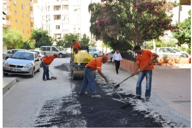
Asfaltlama çalışmalarından bir görünüm
