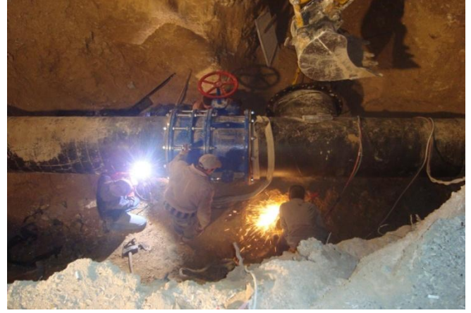
Çelik Boru Bakım Onarım Faaliyeti
