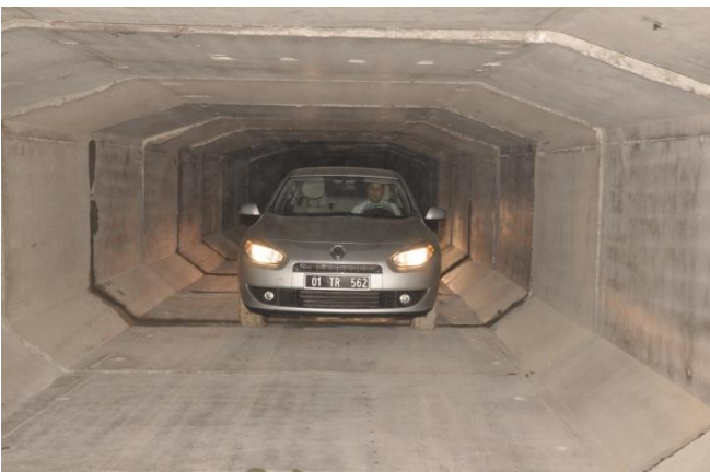
TD8 Yağmur Suyu Baks İnşaatı Yapımı
