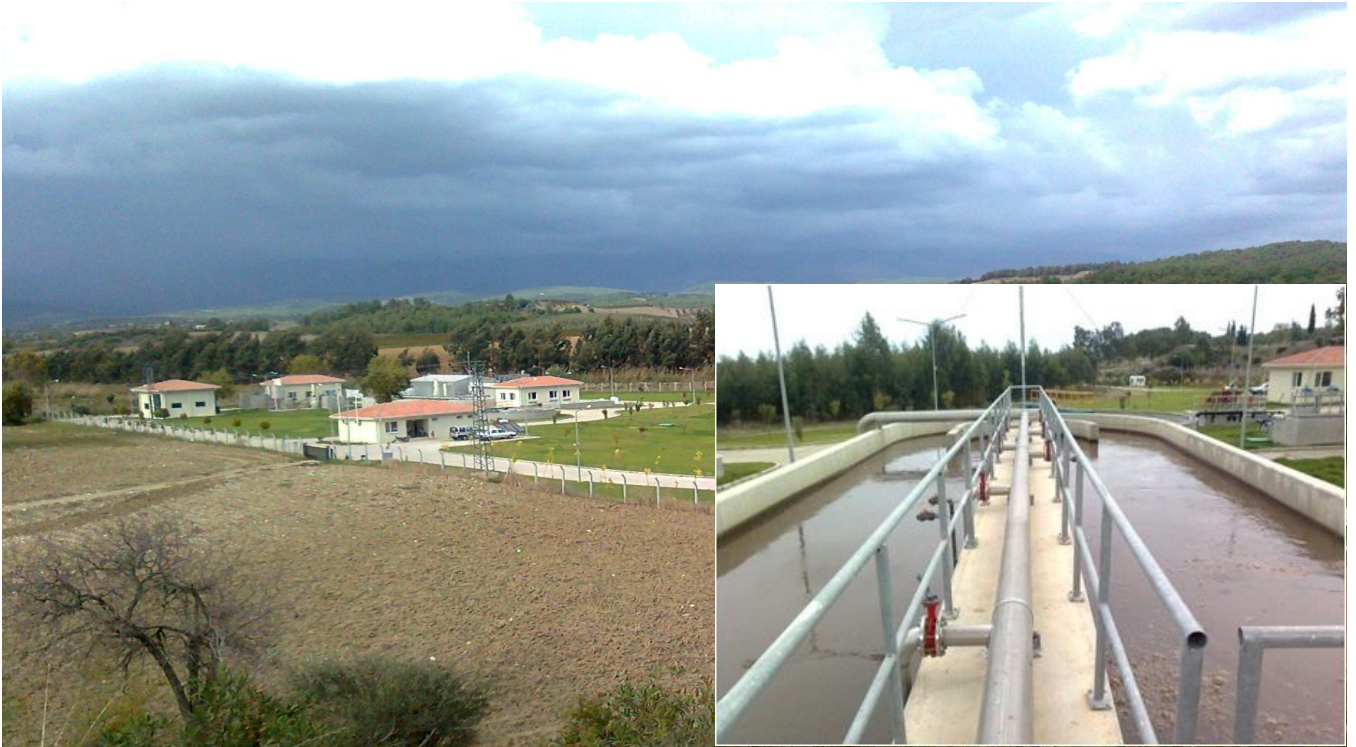
Karaisalı Atıksu Arıtma Tesisi
