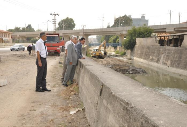
Sarıçam Deresi Bakım Çalışması
