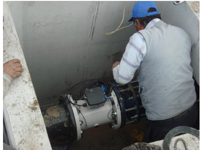
Su kayıp tespiti için debi metre montajı
