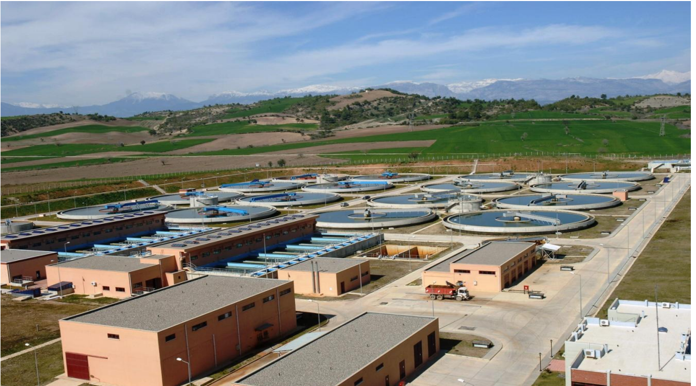
Çatalan İçmesu Arıtma Tesisinden bir görünüm.
