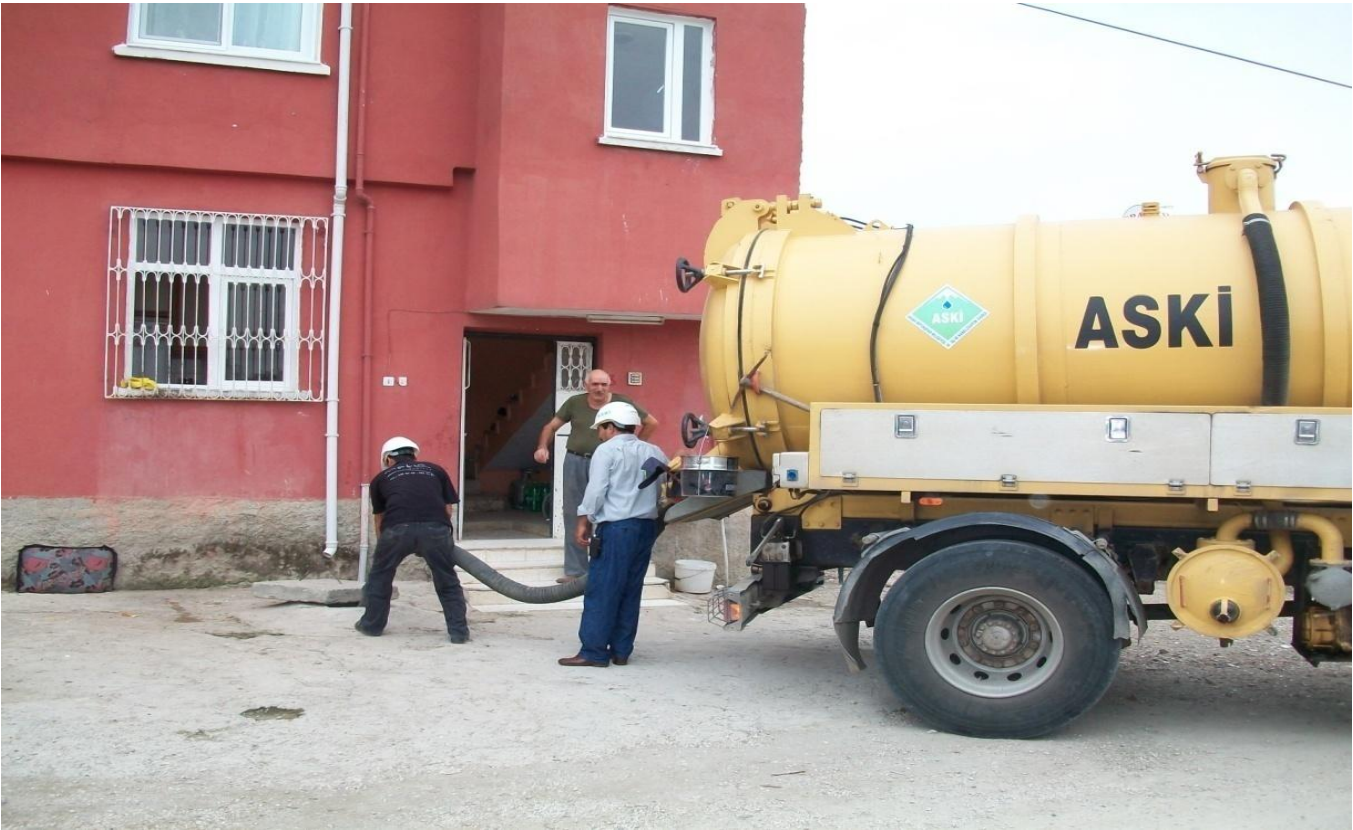
Vidanjör ile foseptik çekim işleminden bir görünüm.
