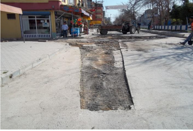
Asfaltlama öncesi kesim, sıkıştırma işlemi
