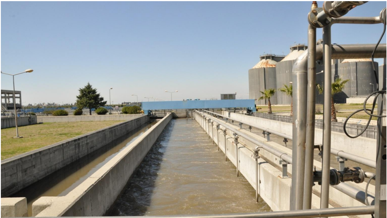
Seyhan Atıksu Arıtma Tesisi atıksu giriş kanalı
