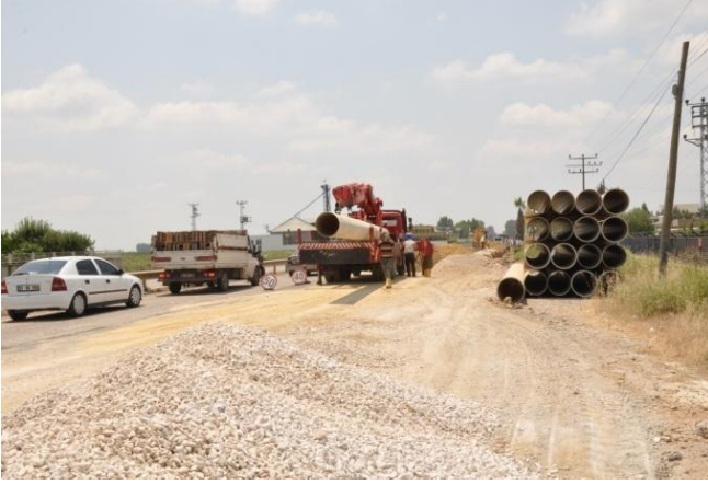
Karataş içme suyu Şebekesi Döşemesi
