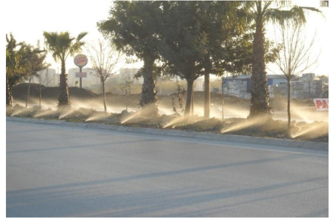
Refüj Sulama Suyu Şebekesi Yapımı
