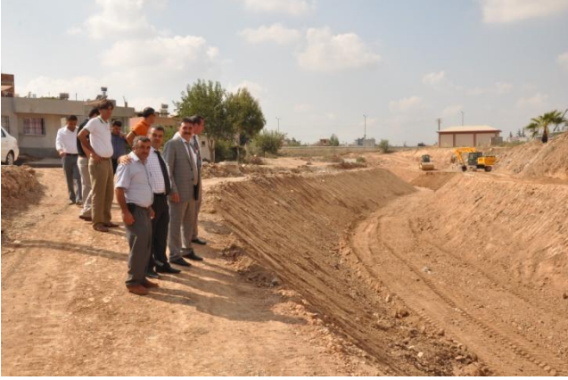
Bucak Deresi Yağmur Suyu Kanalı Yapımı
