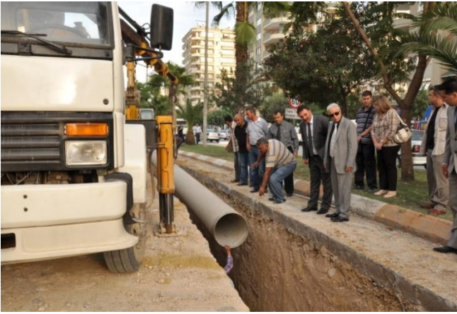
Turgut Özal Bulv. içme suyu Şebekesi Döşeme
