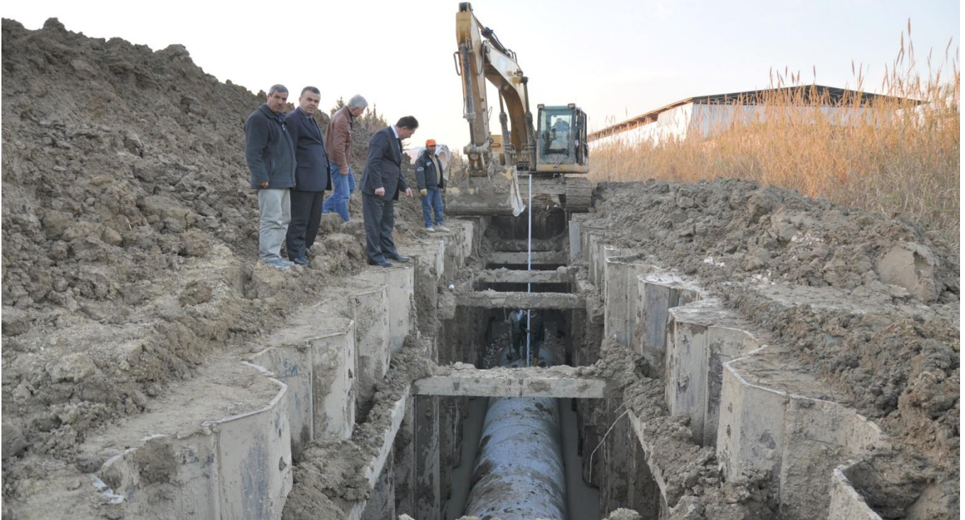
Çelik Palplanş Çakma Yöntemi ile B6 Kanalizasyon Kollektörü Yapım Çalışmaları
