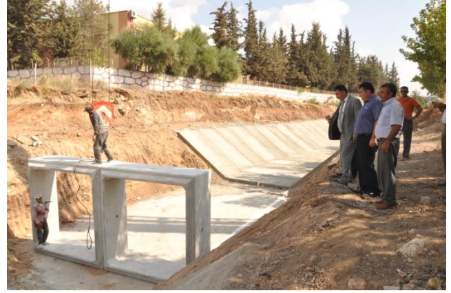
Bucak Deresi Yağmur Suyu Kanalı Yapımı
