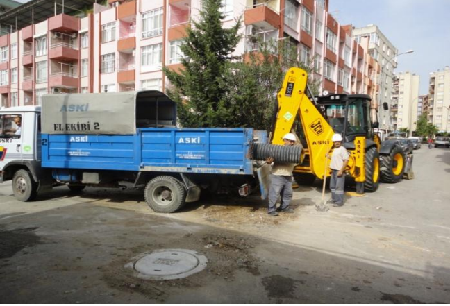
Kanalizasyon Bakım ve Onarım Çalışması
