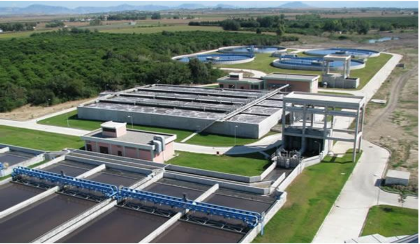
Yüreğir Atıksu Arıtma Tesisi
