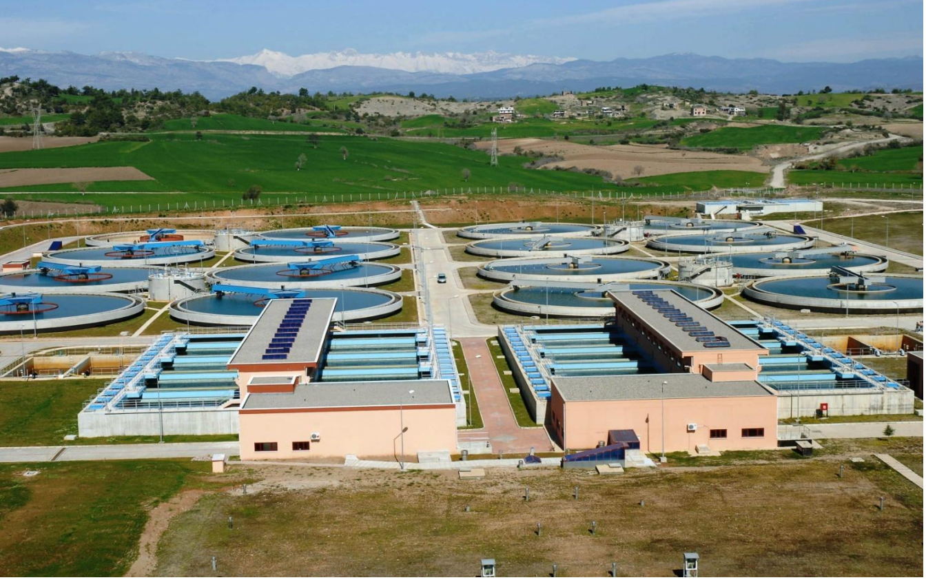
Çatalan İçmesu Arıtma Tesislerinden genel bir görünüm.
