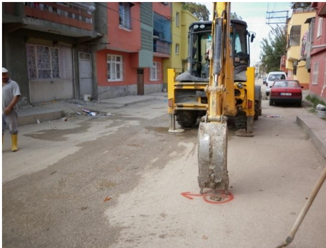
Şebeke Arıza Onarım Çalışması
