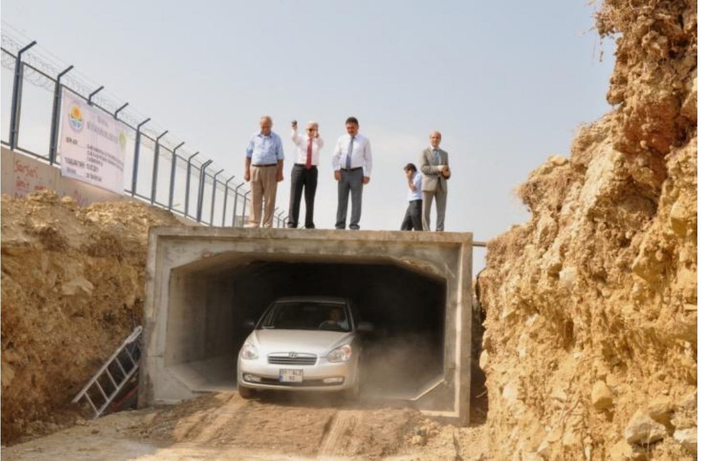
TD8 Yağmur Suyu Baks İnşaatı Yapımı
