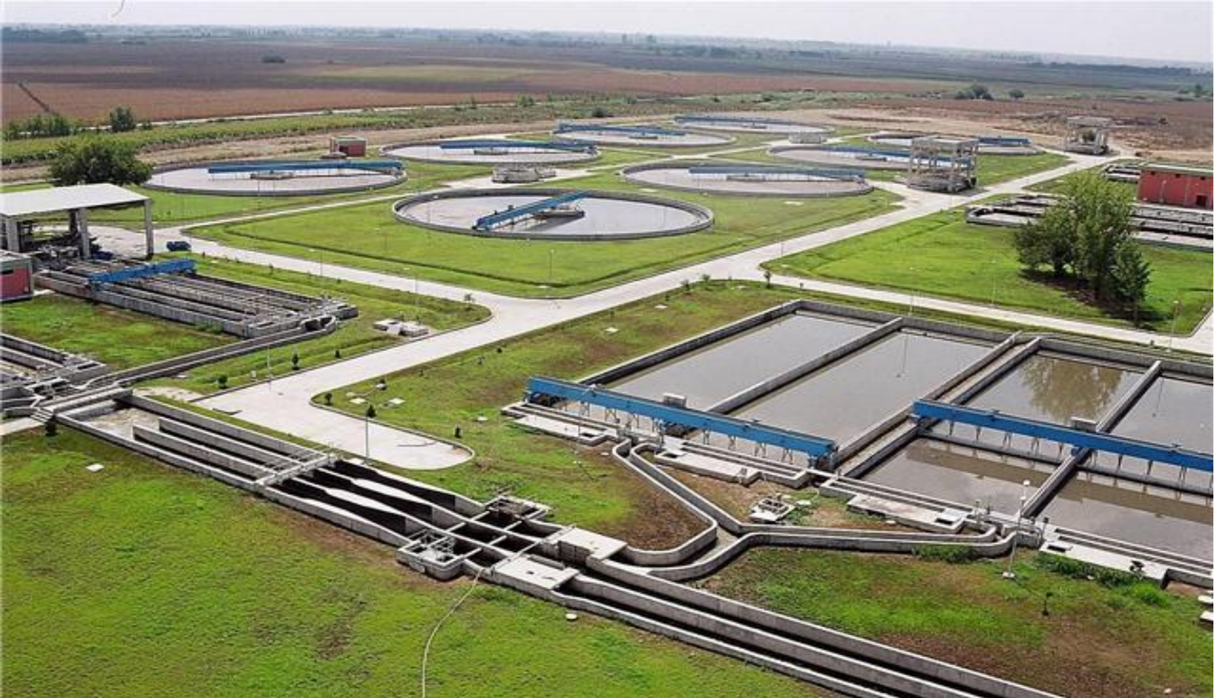
Seyhan ilçesinde bulunan Seyhan Atıksu Arıtma Tesisinden genel bir görünüm.
