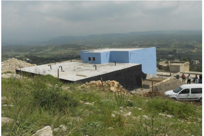
Karaisalı 500 m 3 Su Deposu Yapım Çalışmaları
