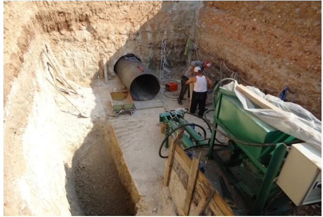
Suluca Beldesi Kanalizasyon Şeb.Döşenmesi
