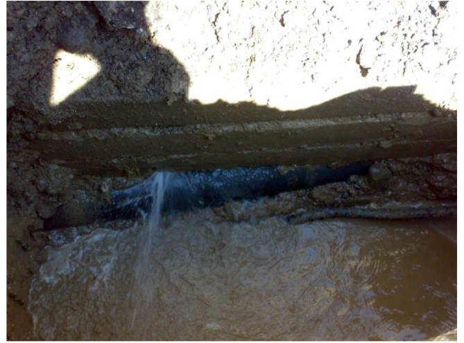
Şebeke Arıza Onarım Çalışması
