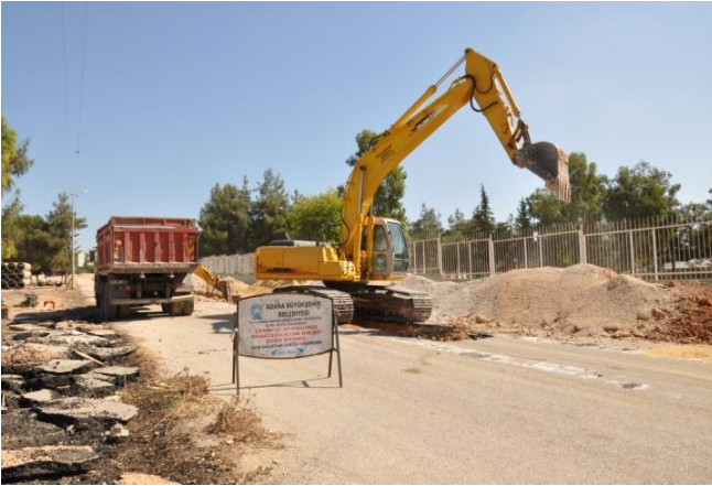
Ruh Sağlığı içme suyu Şebekesi Döşeme
