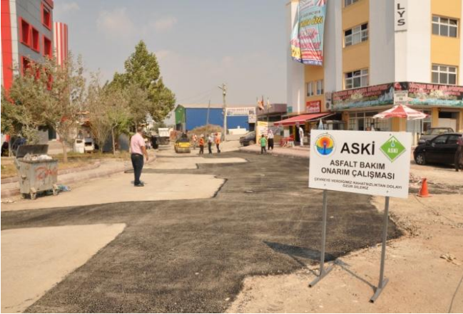
Asfalt kaplama işleminden bir görünüm
