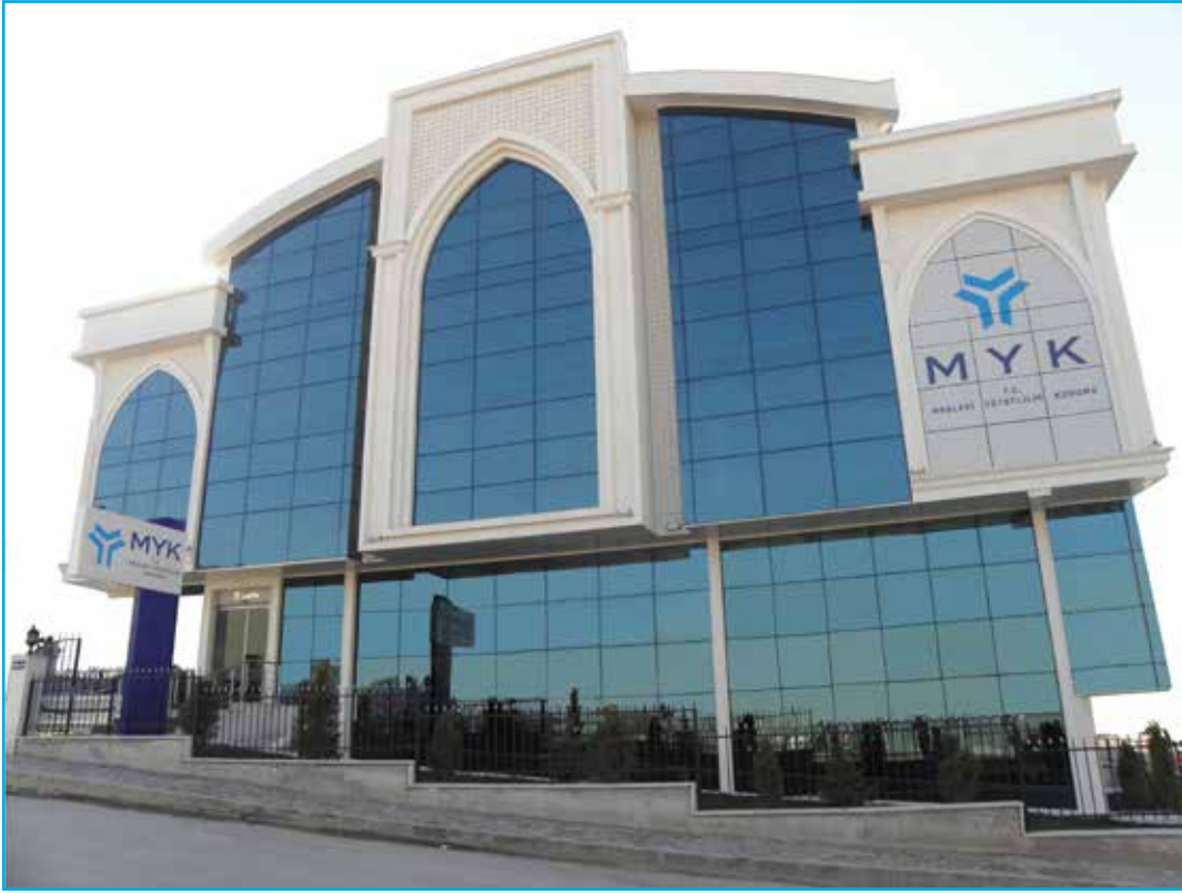
Resim 1: MYK Hizmet Binası
