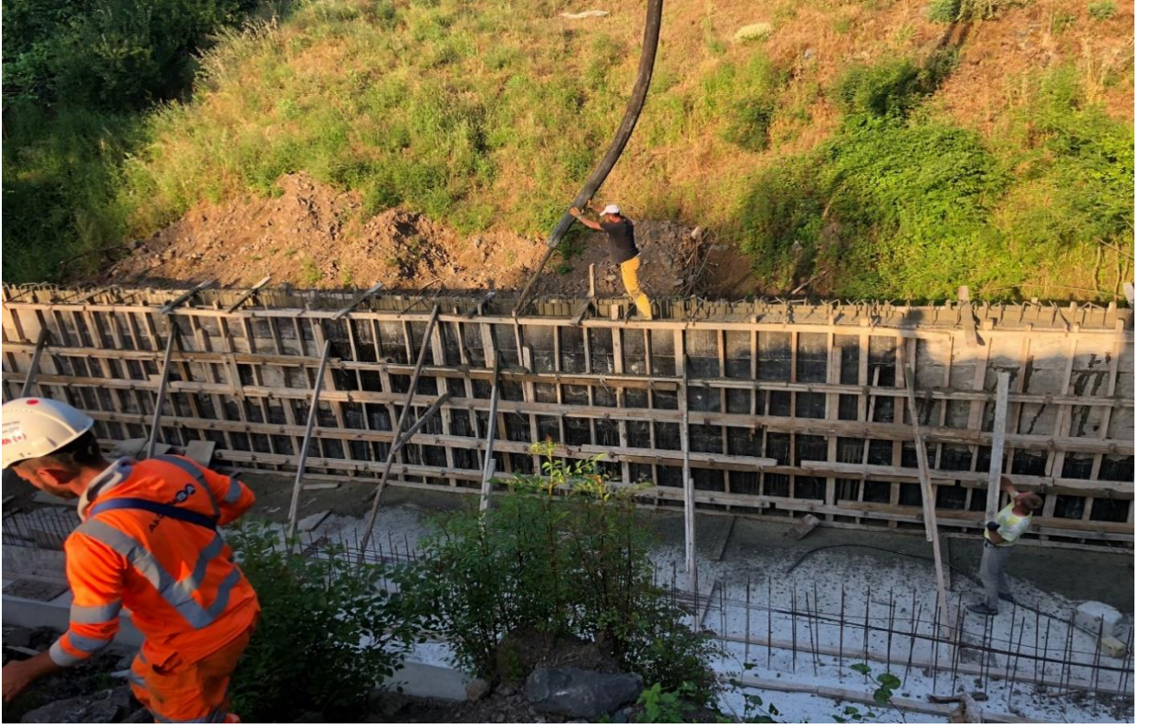
Dereler Mahallesi Beton Box Dökümü
