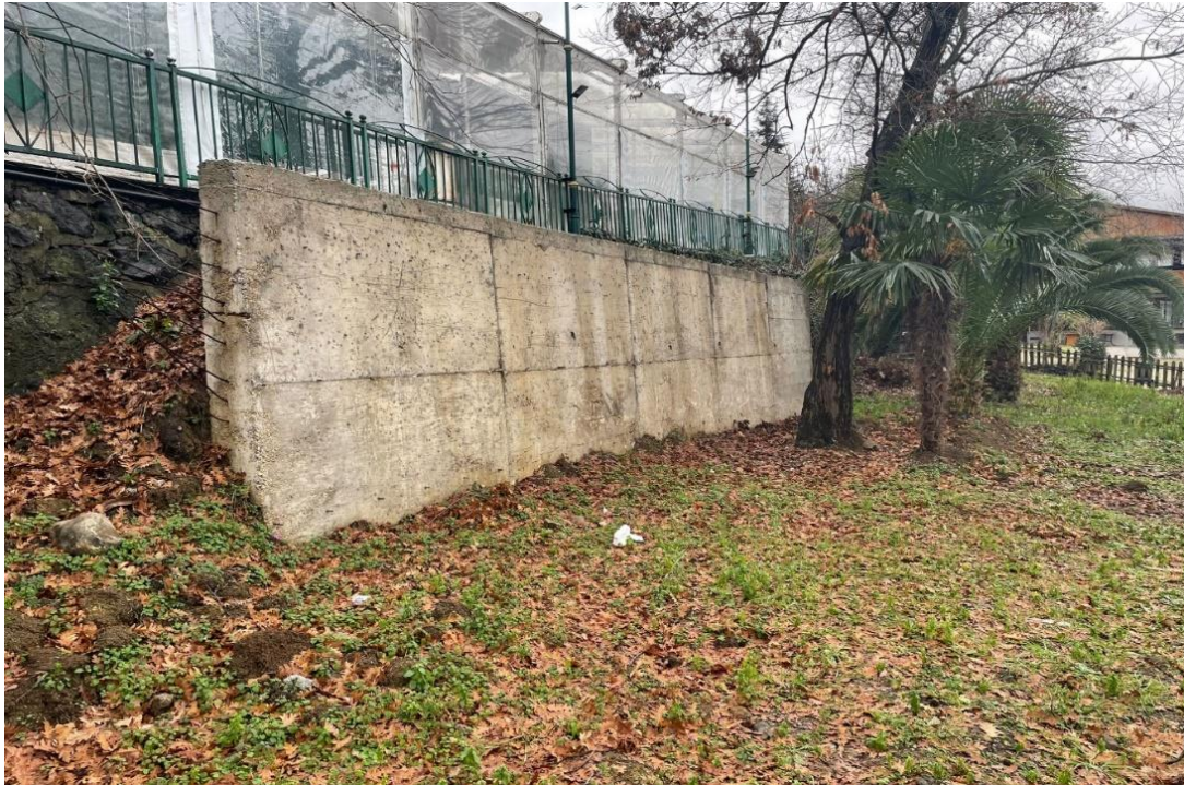
Meşe Tesisleri Kır Düğünü Arkası Betonarme Duvar Çalışması Tamamlandı
