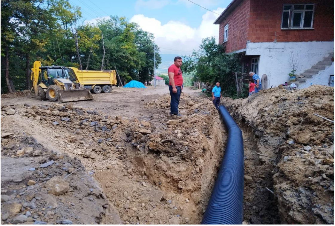
Düzardıç Mahallesi Korige Boru Döşenmesi
