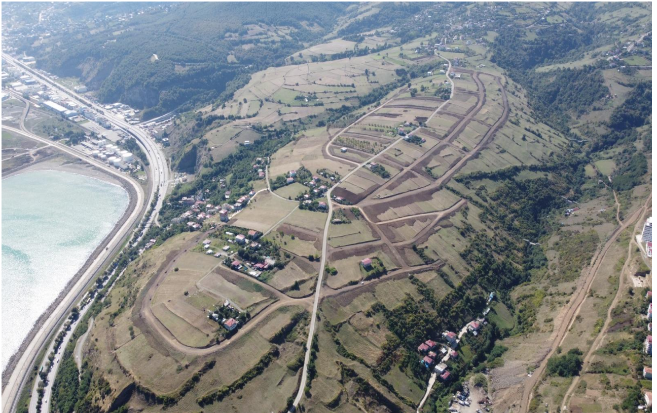
Devgeri Mahallesi Yol Açma Çalışması
