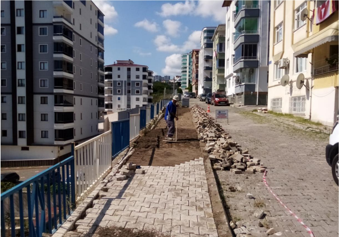
Belediye Evleri Mahallesi Kaldırım Çalışması
