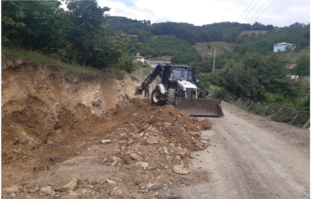
Başalan Mahallesi Kanal Açma Çalışması
