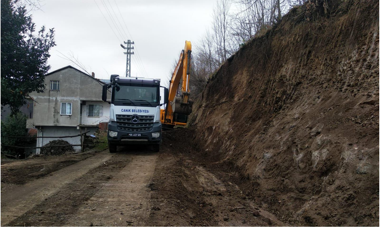
Gürgenyatak Mahallesi Yol Açma Çalışması
