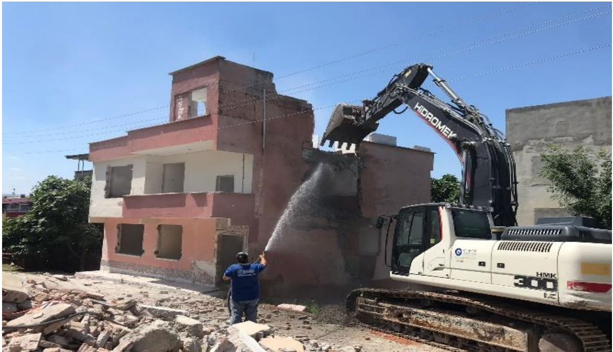
Kamulaştırma Yapılan Binaların Yıkımı
