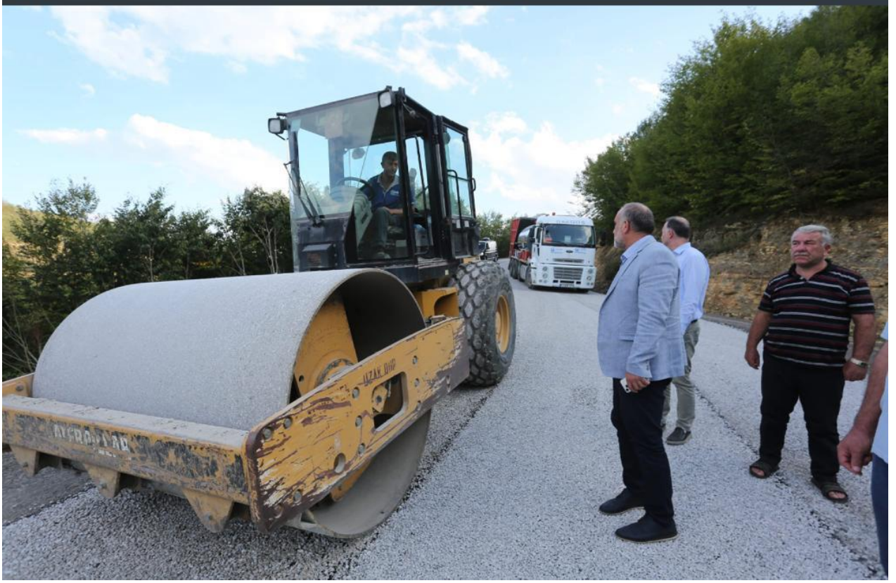
Başalan Mahallesi Sathi Kaplama Çalışması
