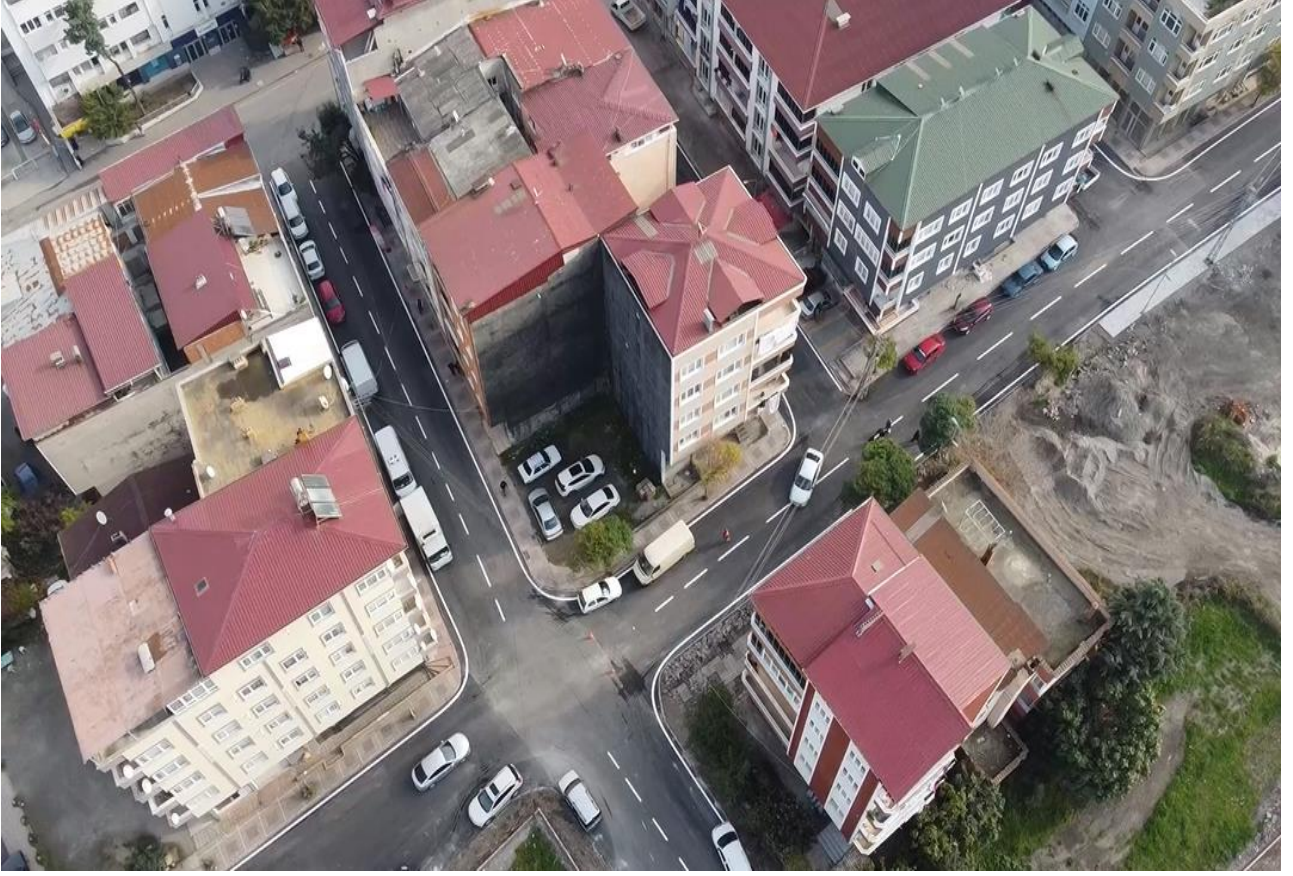
Soğuksu Mahallesi Asfalt Kaplama Çalışması
