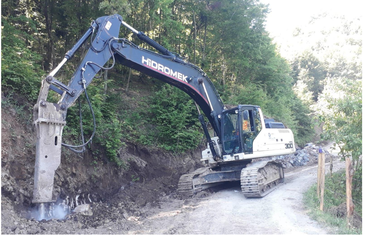
Gökçepınar Mahallesi Kanal Açma Çalışması
