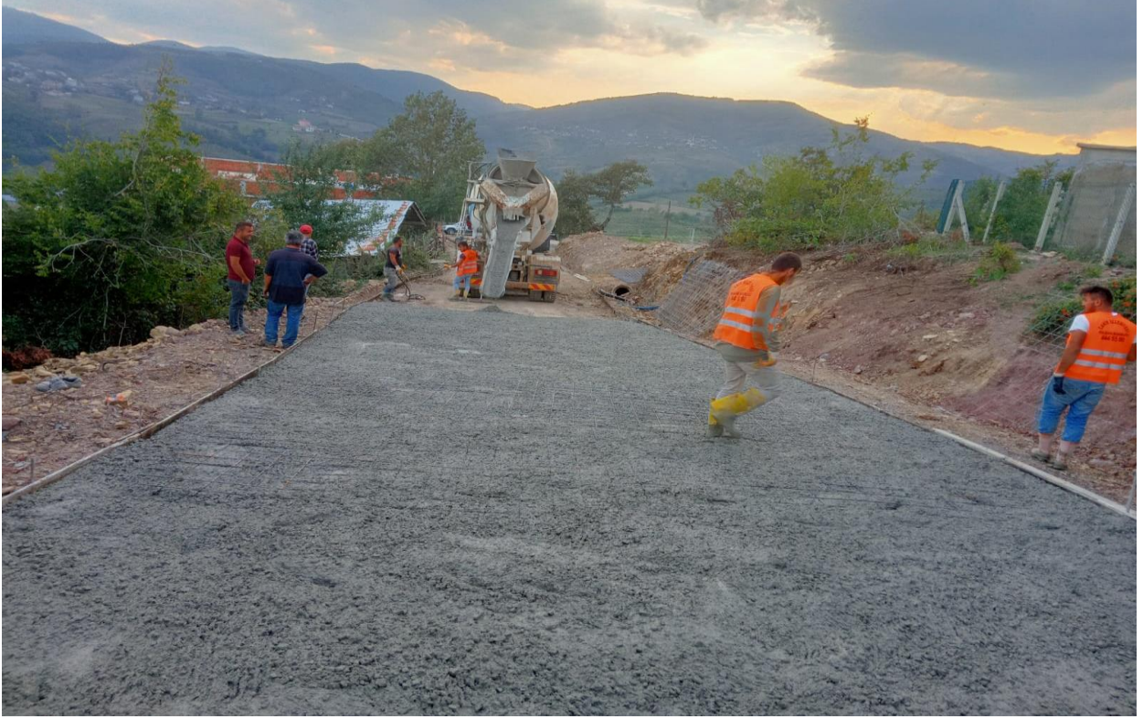
Yeşilpınar Mahallesi Beton Yol Çalışması
