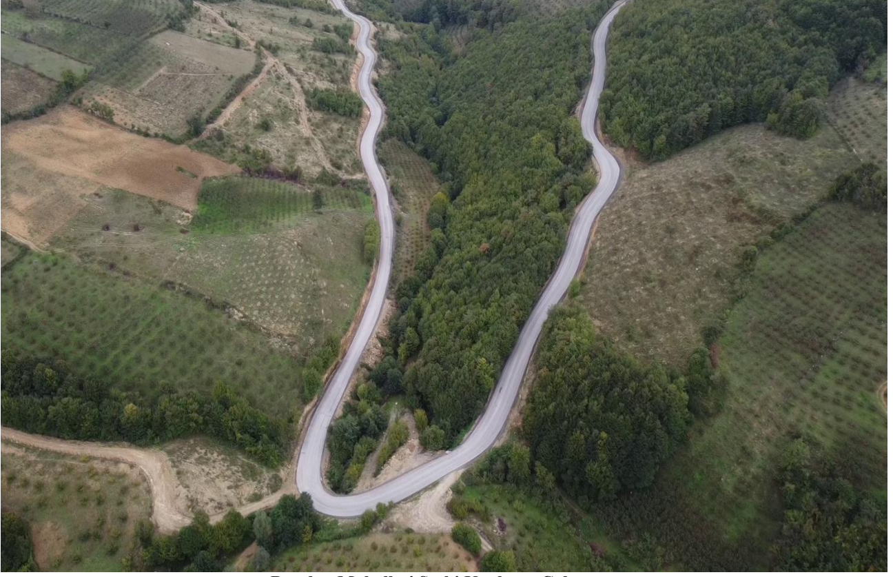
Başalan Mahallesi Sathi Kaplama Çalışması
