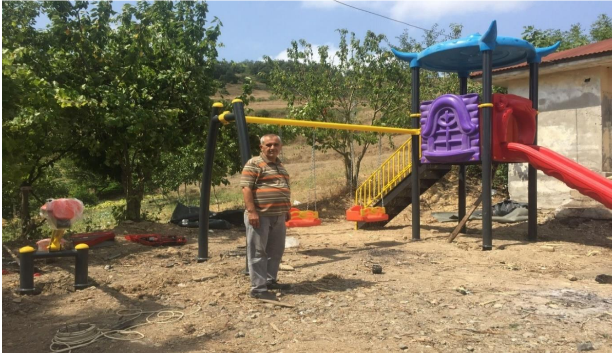
Demirci Mahallesi Yeni Park Alanı Yapımı
