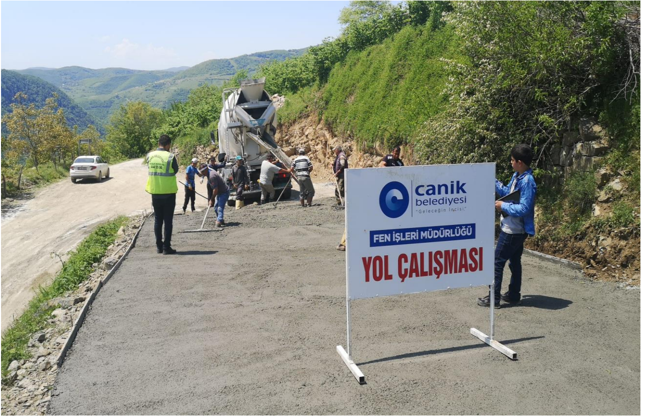
Yayla Mahallesi Beton Yol Çalışması
