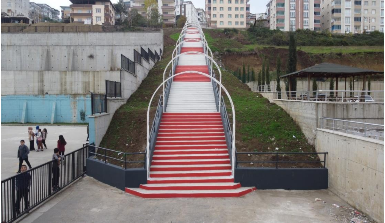
Uludağ Mahallesi Beton Merdiven İmalatı Tamamlandı.
