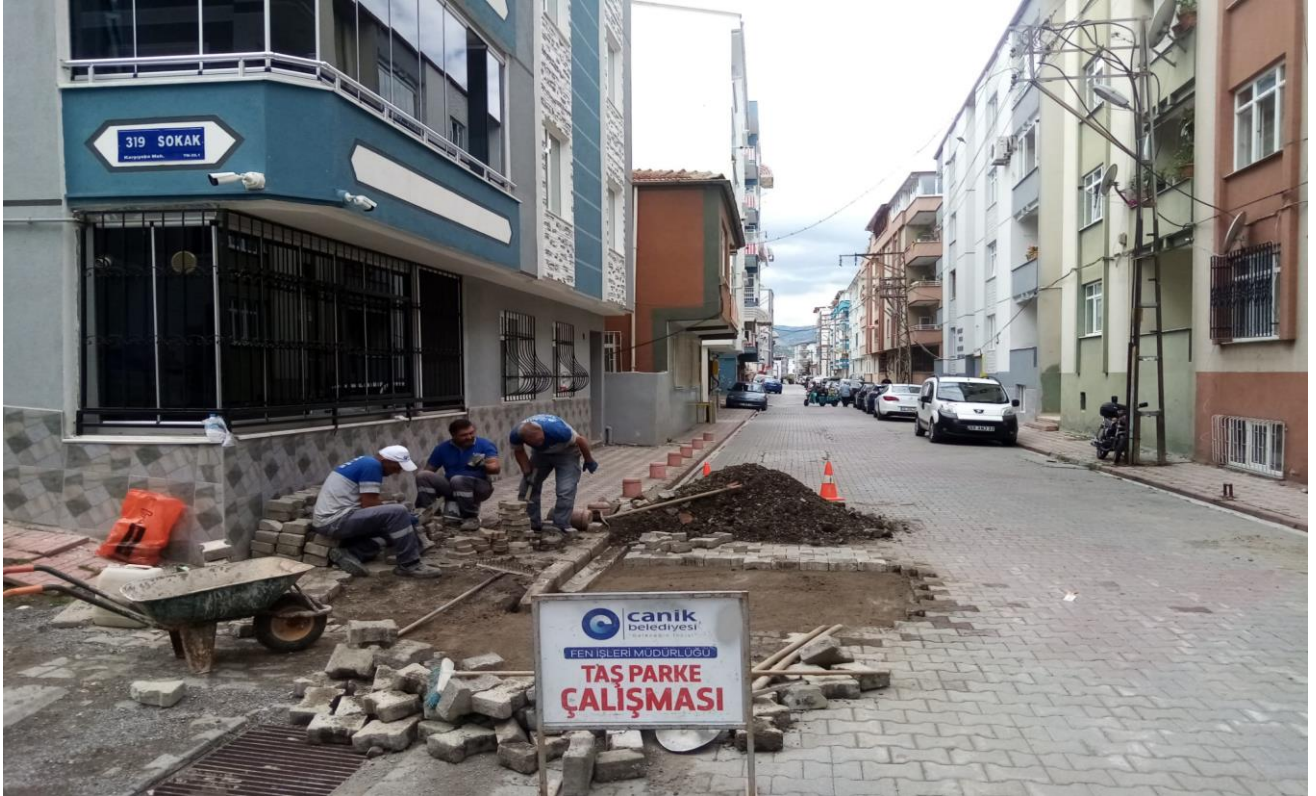
Karşıyaka Mahallesi Parke Yol Çalışması
