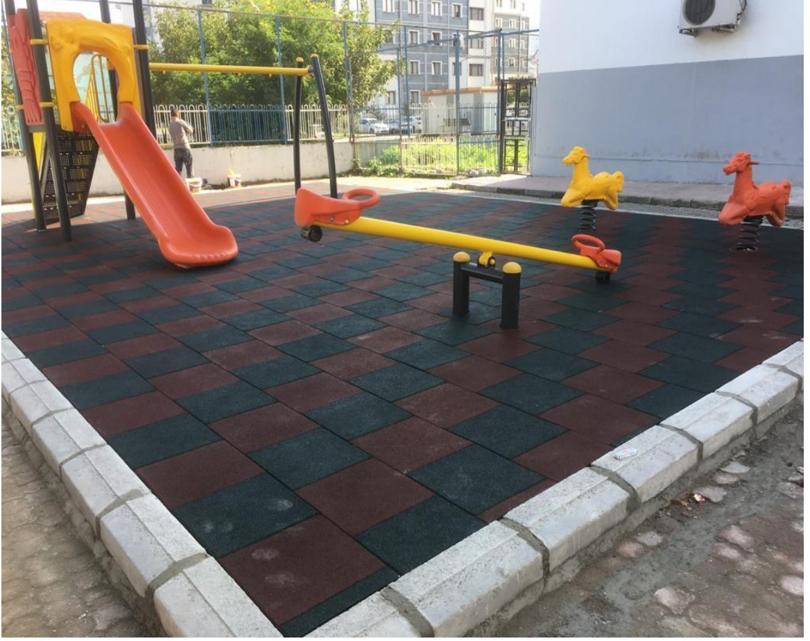
Kuzey Yıldızı Mahallesi Yeni Park Alanı Yapımı
