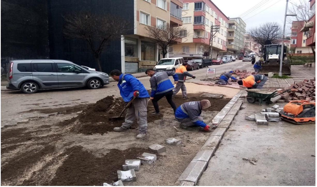
Soğuksu Mahallesi Oluk Taşı Yapım Çalışması
