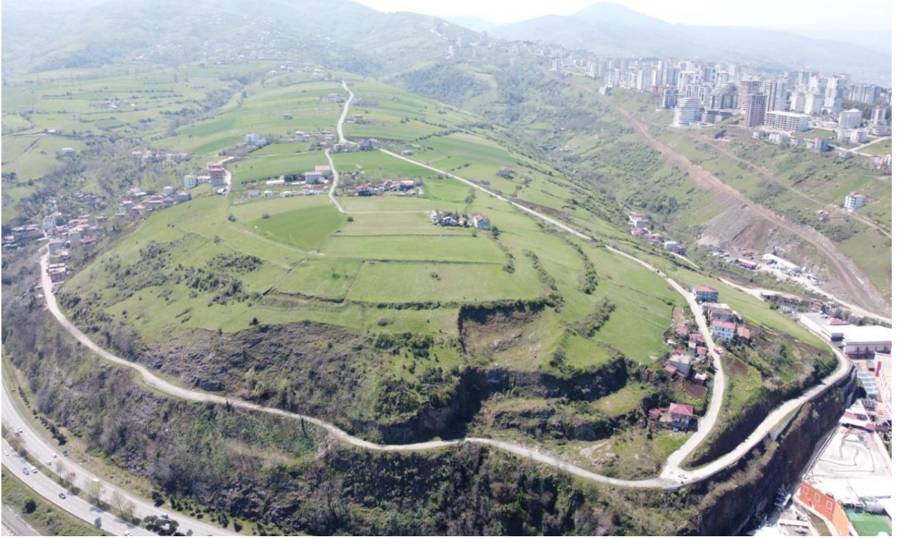
Devgeri Mahallesi Yol Açma Çalışması
