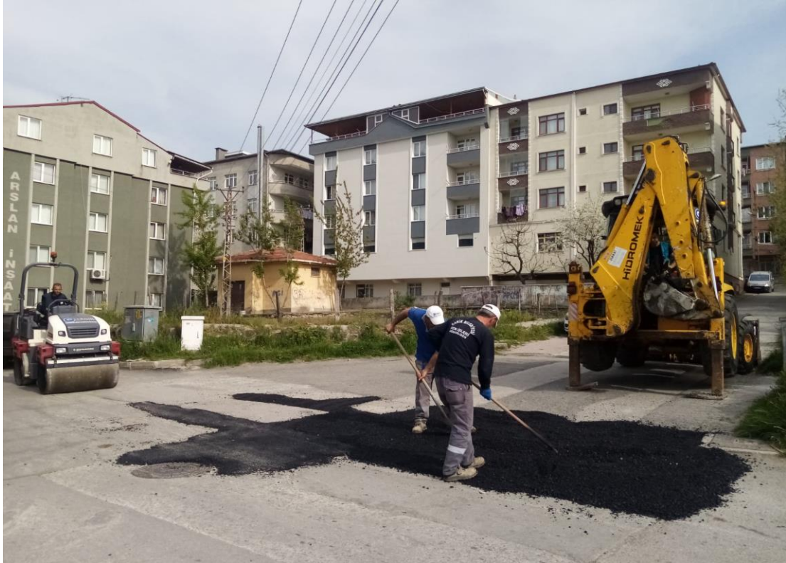
Karşıyaka Mahallesi Asfalt Yama Çalışması
