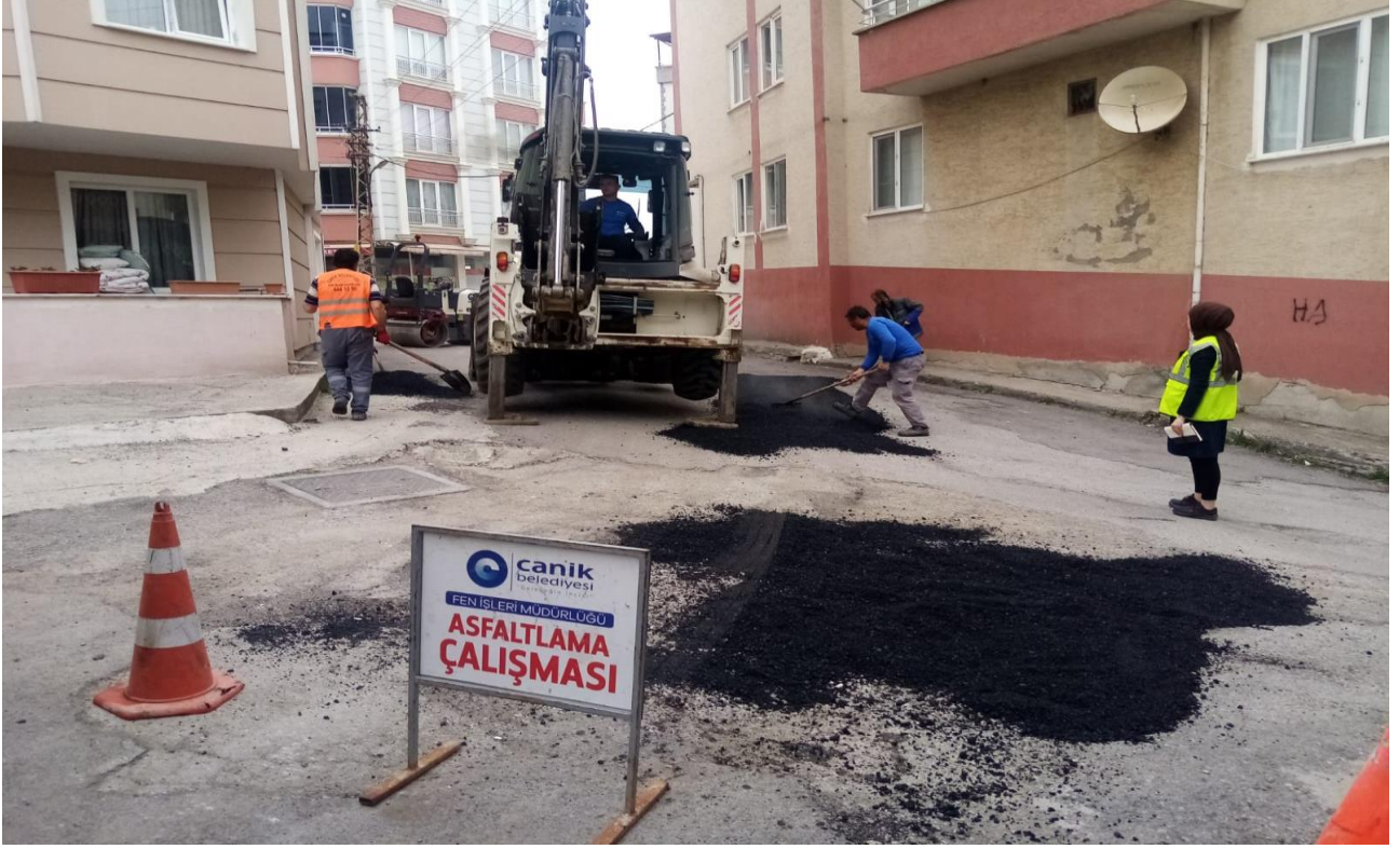
Uludağ Mahallesi Asfalt Yama Çalışması
