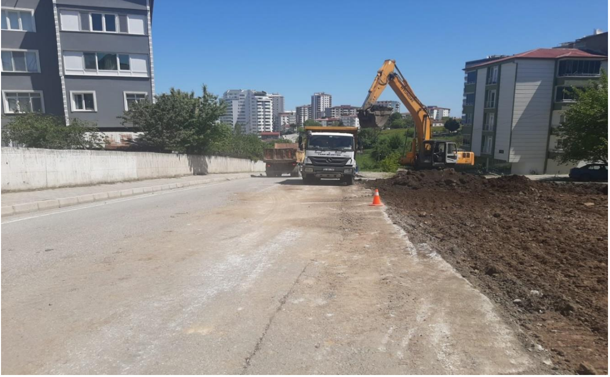
Hasköy Mahallesi Yol Geniřletme Çalışması
