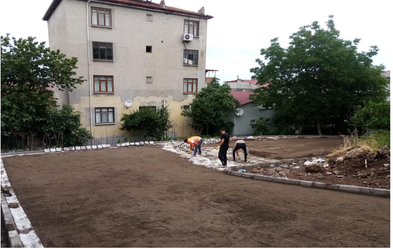
Gaziosmanpaşa Mahallesi Parke Yol Çalışması
