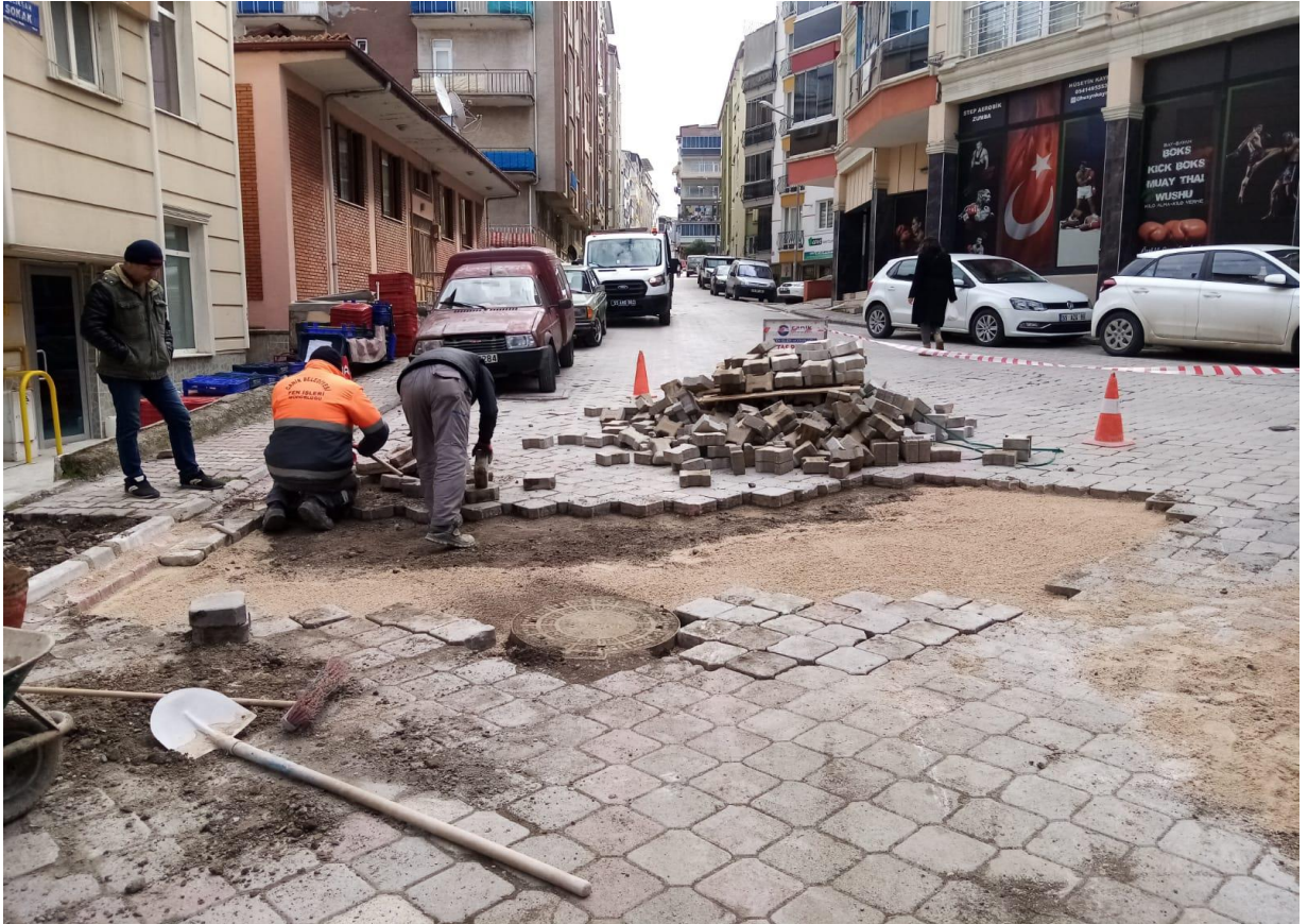
Uludağ Mahallesi Parke Tamirâtı Çalışması
