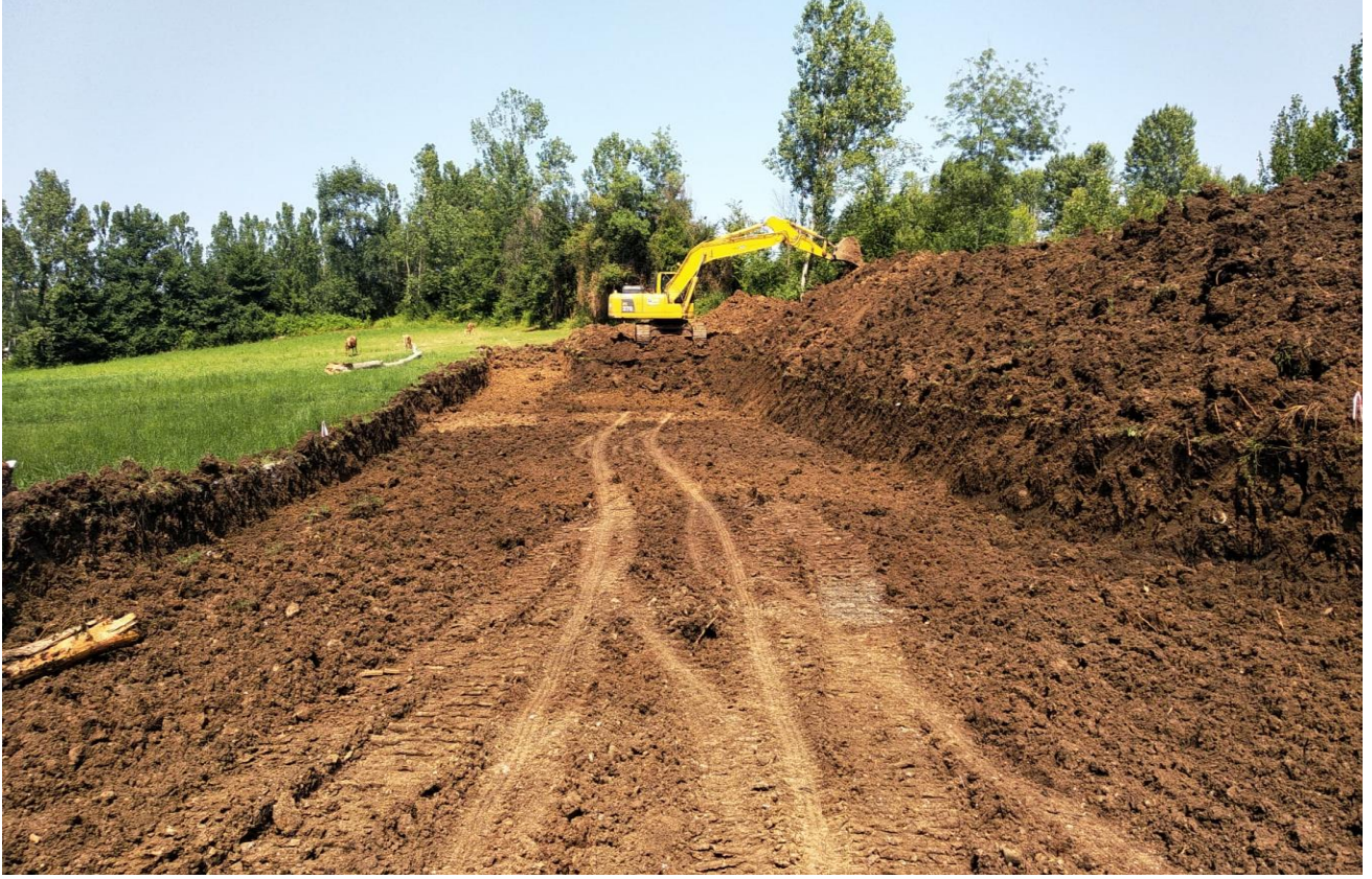
Düvecik Mahallesi Yol Açma Çalışması
