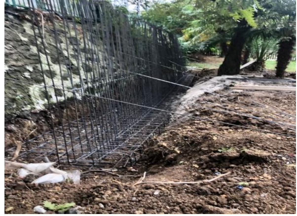
Meşe Tesisleri Kır Düğünü Arkası Betonarme Duvar Çalışması
