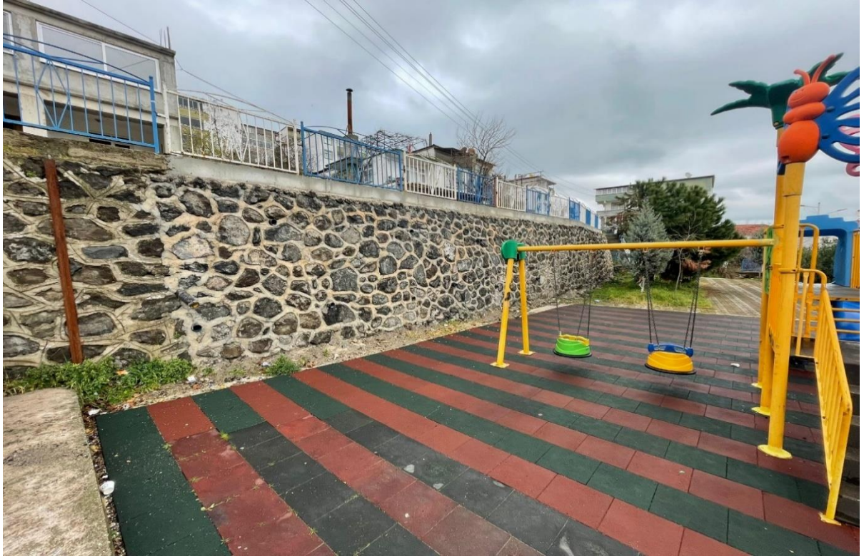
Toptepe Mahallesi Kamelya Sokak Taş Duvar İmalatı Tamamlandı.
