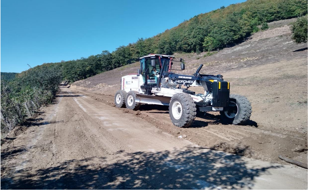
Kestanepınar Mahallesi Yol Tesviye Çalışması
