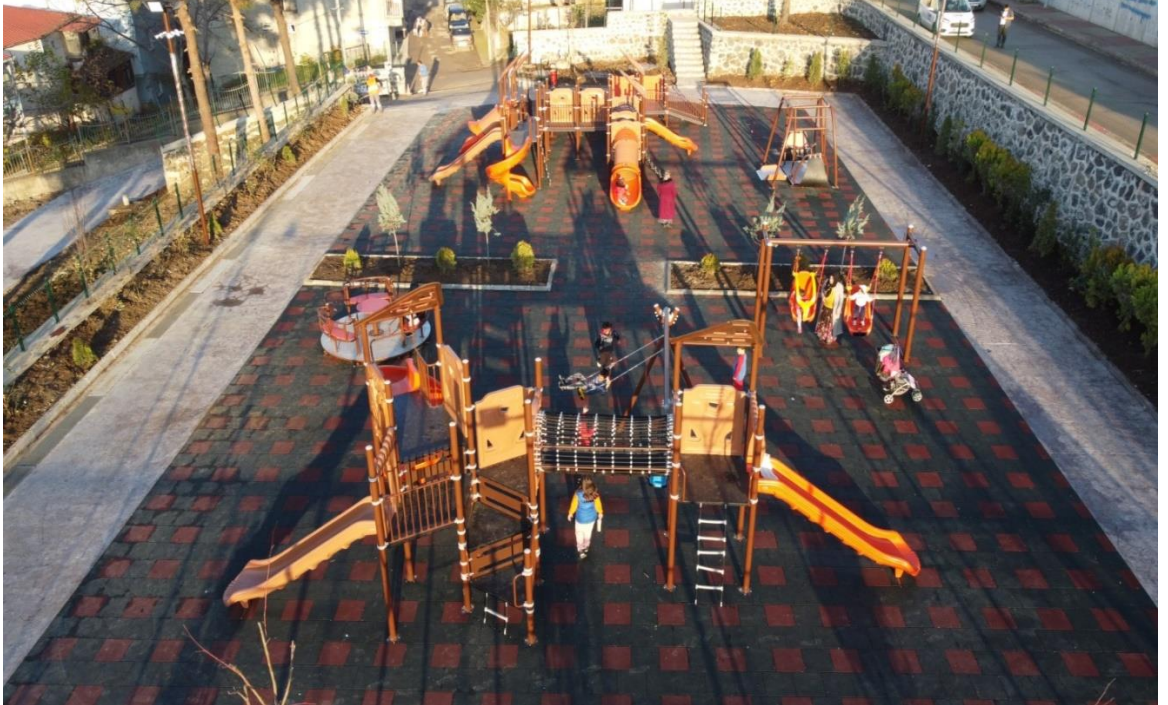
Uludağ Mahallesi Yeni Park Alanı Yapımı
