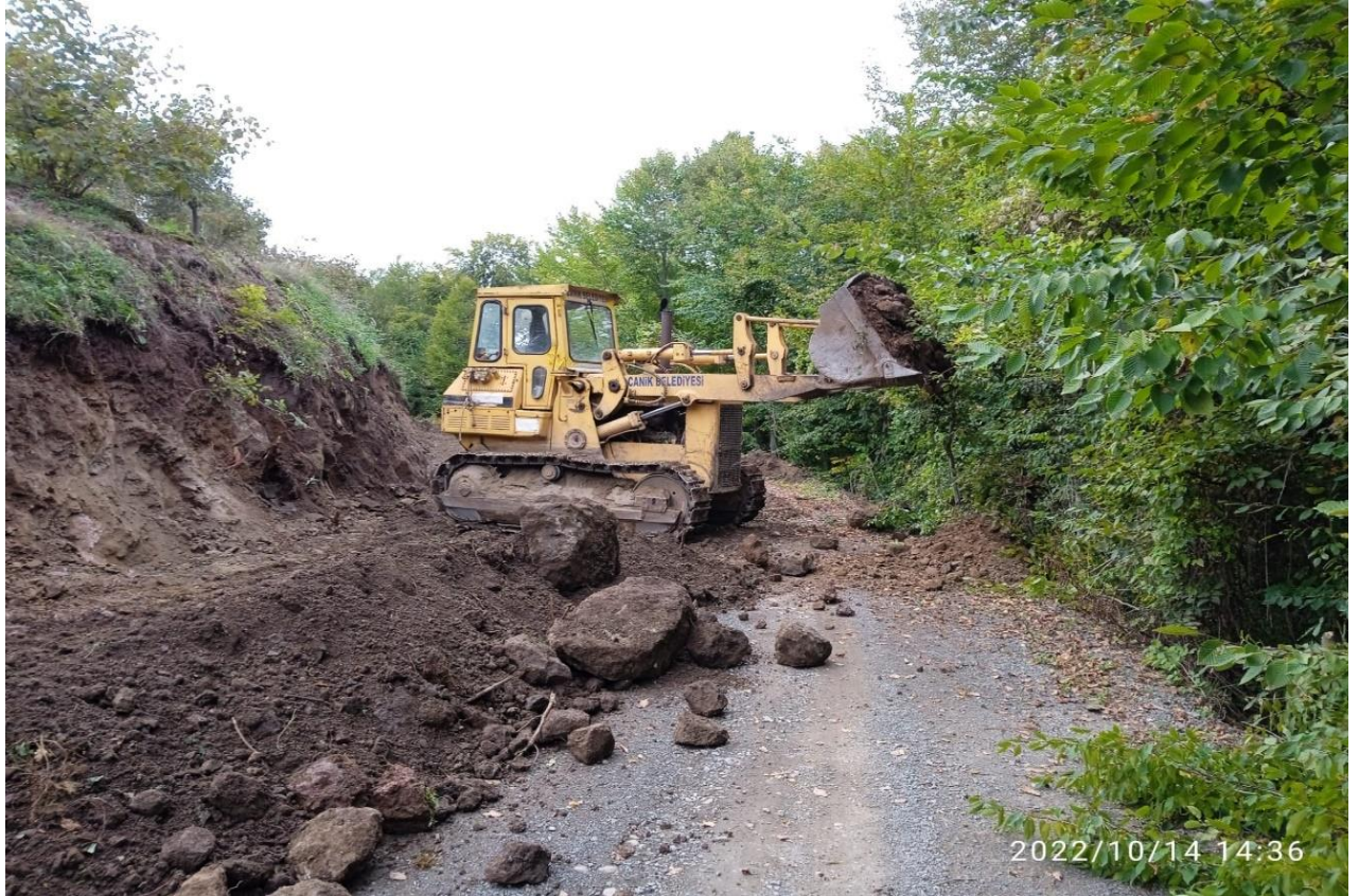
Kestanepınar Mahallesi Yol Geniştirme Çalışması
