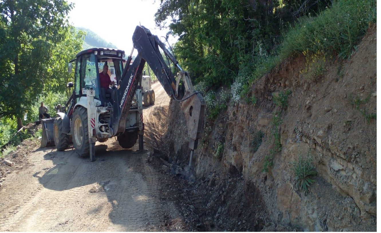
Çağlayan Mahallesi Kanal Açma Çalışması
