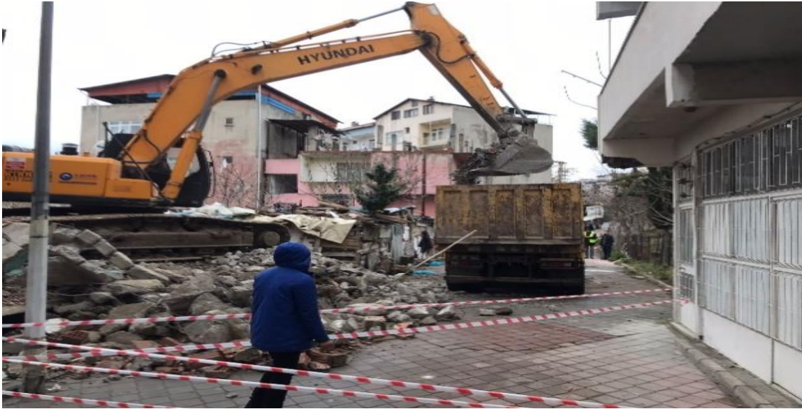
Metruk Binaların Yıkımı
