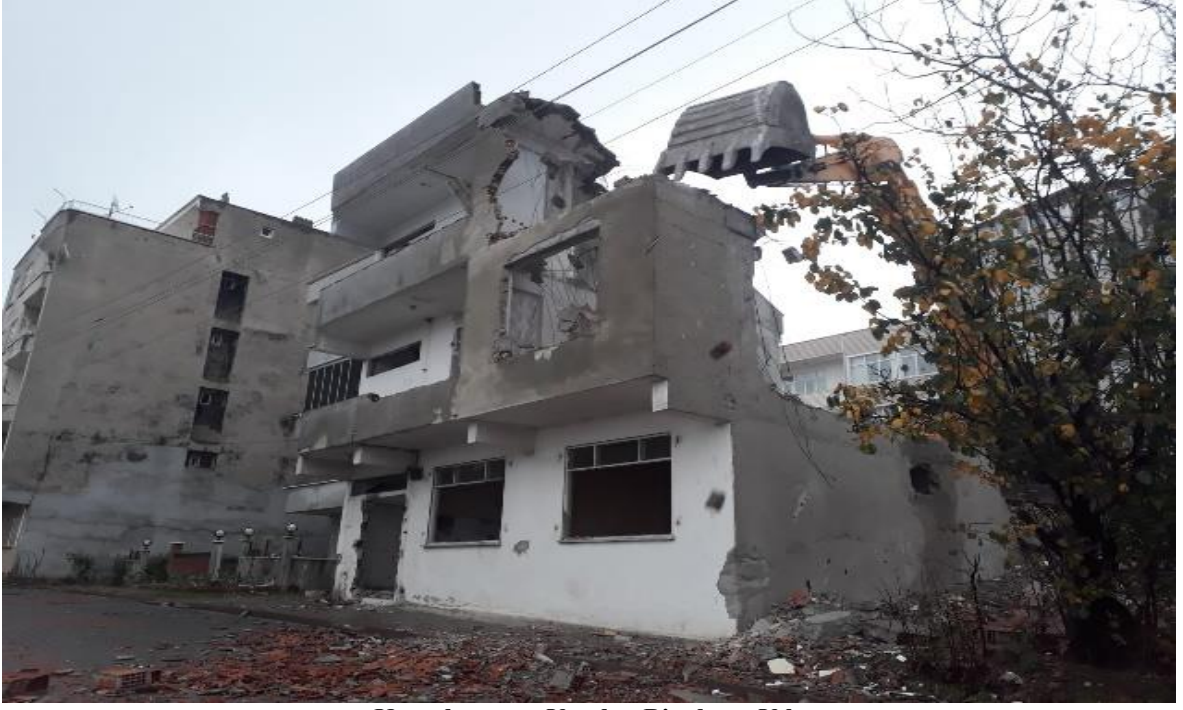
Kamulaştırma Yapılan Binaların Yıkımı
