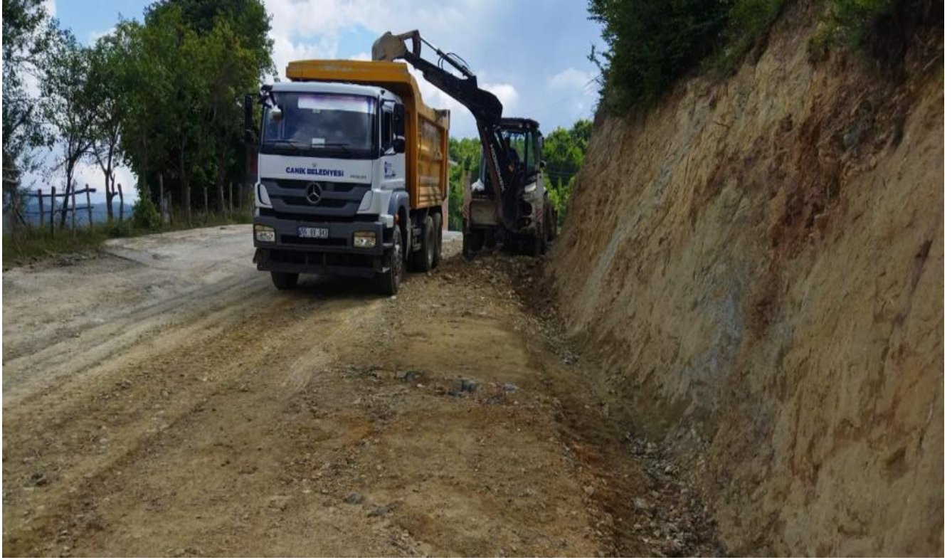
Gültepe Mahallesi Yol Geniştirme Çalışması
