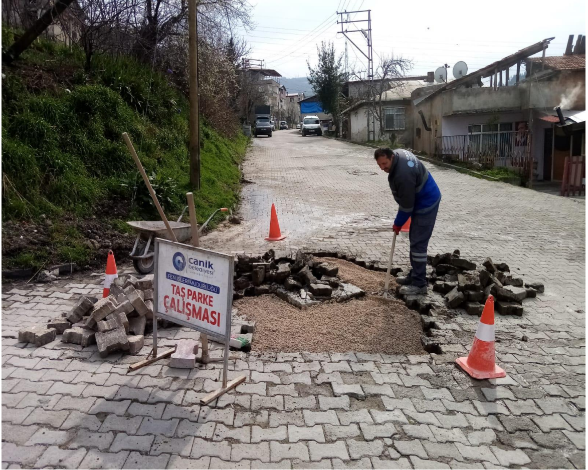
Gaziosmanpaşa Mahallesi Parke Tamirâtı Çalışması
