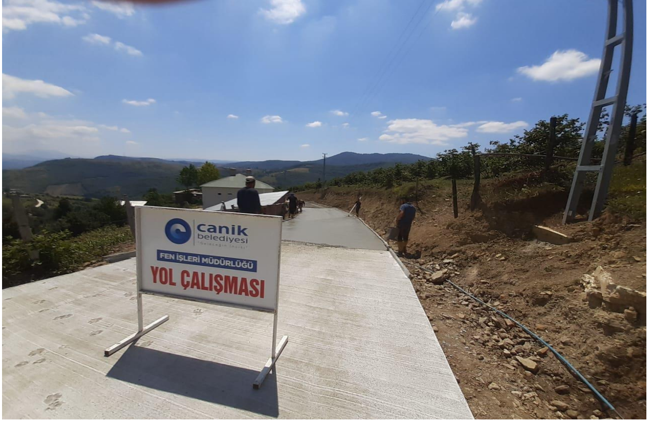
Hacınaipli Mahallesi Beton Yol Çalışması
