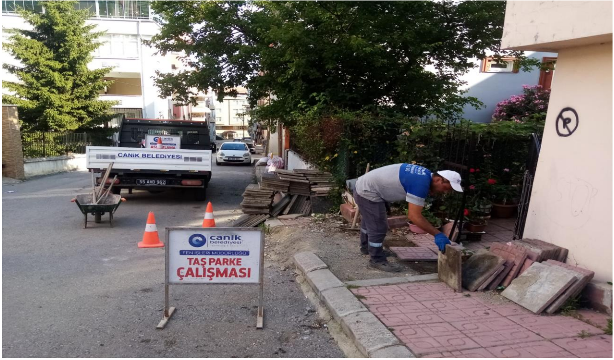
Uludağ Mahallesi Karo Tamirat Çalışması
