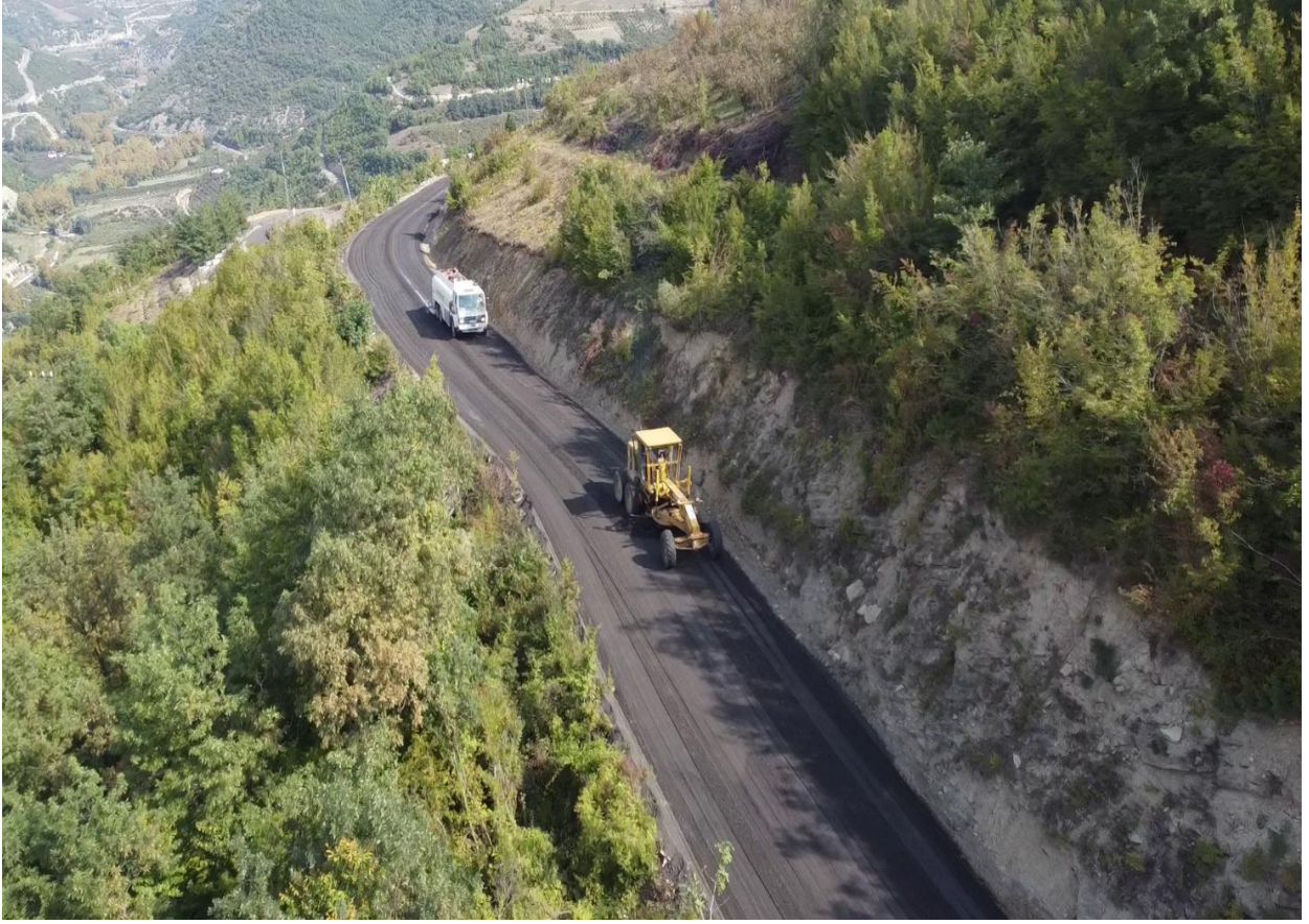
Kaleboğazı Mahallesi Sathi Kaplama Çalışması
