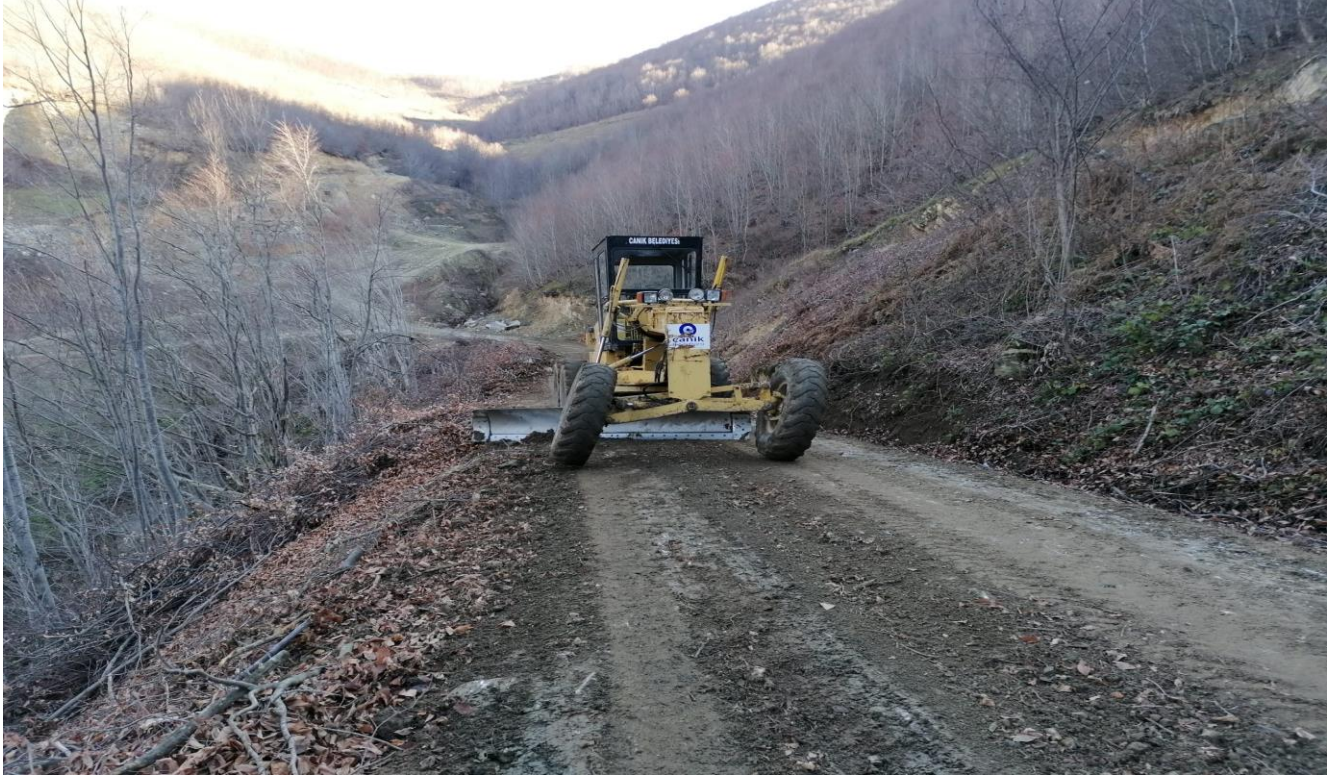
Kaleboğazı Mahallesi Yol Tesviye Çalışması
