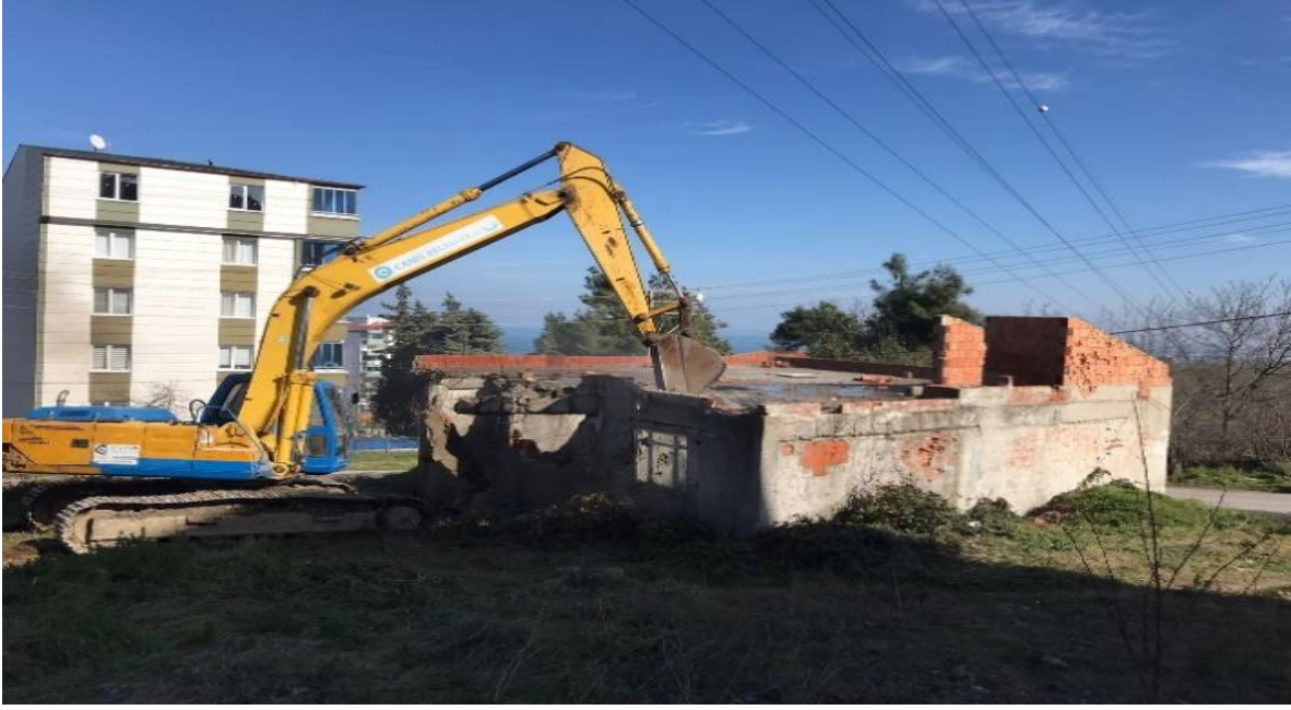
Metruk Binaların Yıkımı
