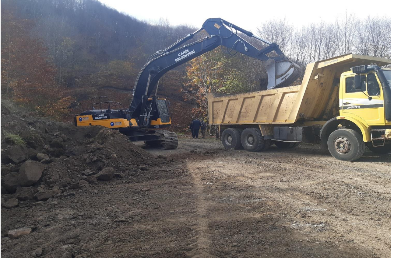
Gökçepınar Mahallesi Yol Geniştirme Çalışması
