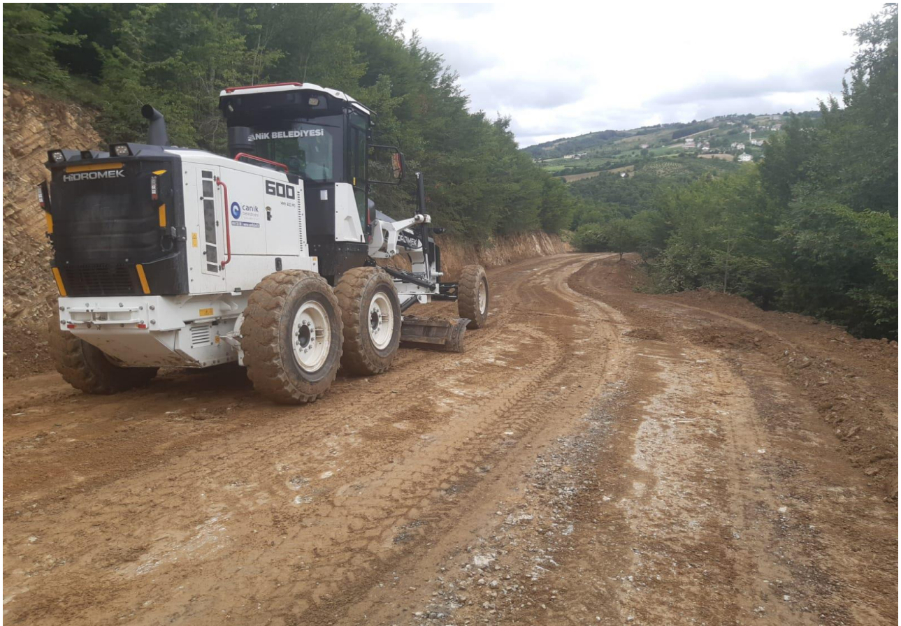
Başalan Mahallesi Yol Tesviye Çalışması
