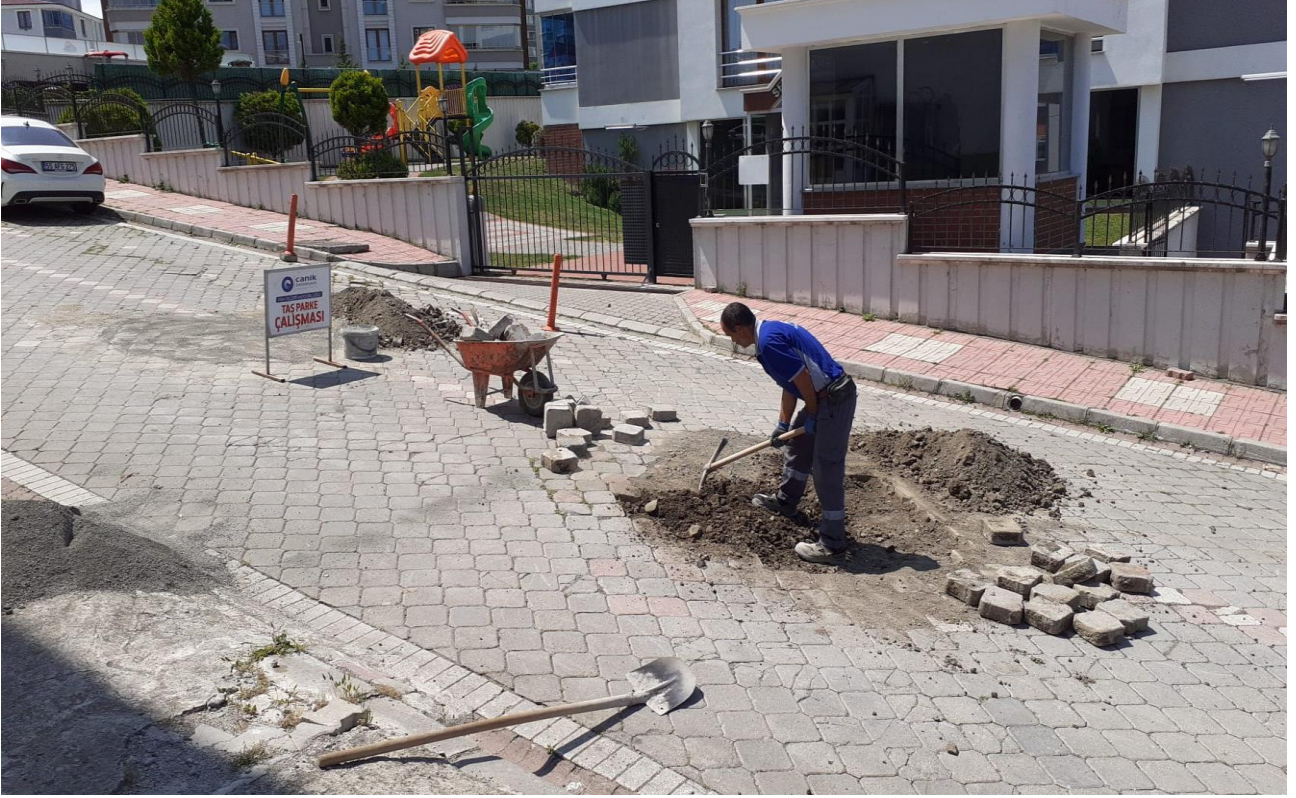
Hasköy Mahallesi Parke Tamirâtı Çalışması
