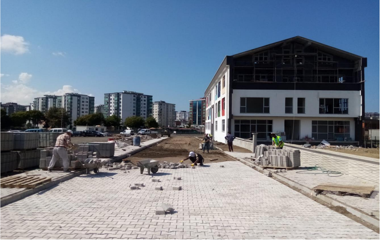
Kuzey Yıldızı Mahallesi Parke Yol Çalışması
