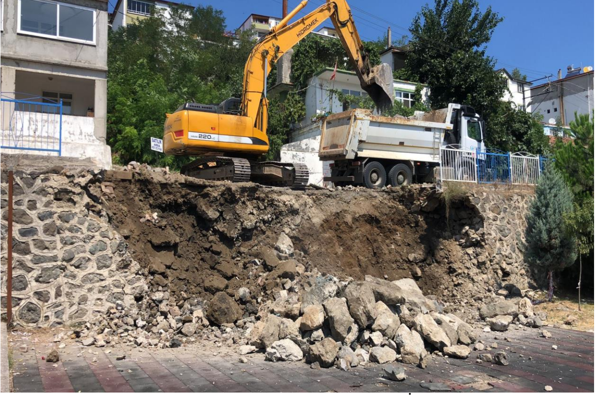
Toptepe Mahallesi Kamelya Sokak Taş Duvar İmalatı
