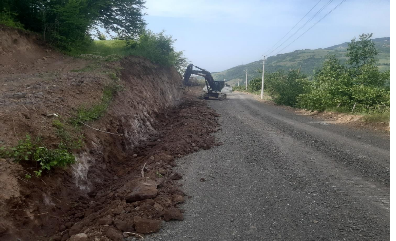
Hilaltepe Mahallesi Kanal Açma Çalışması
