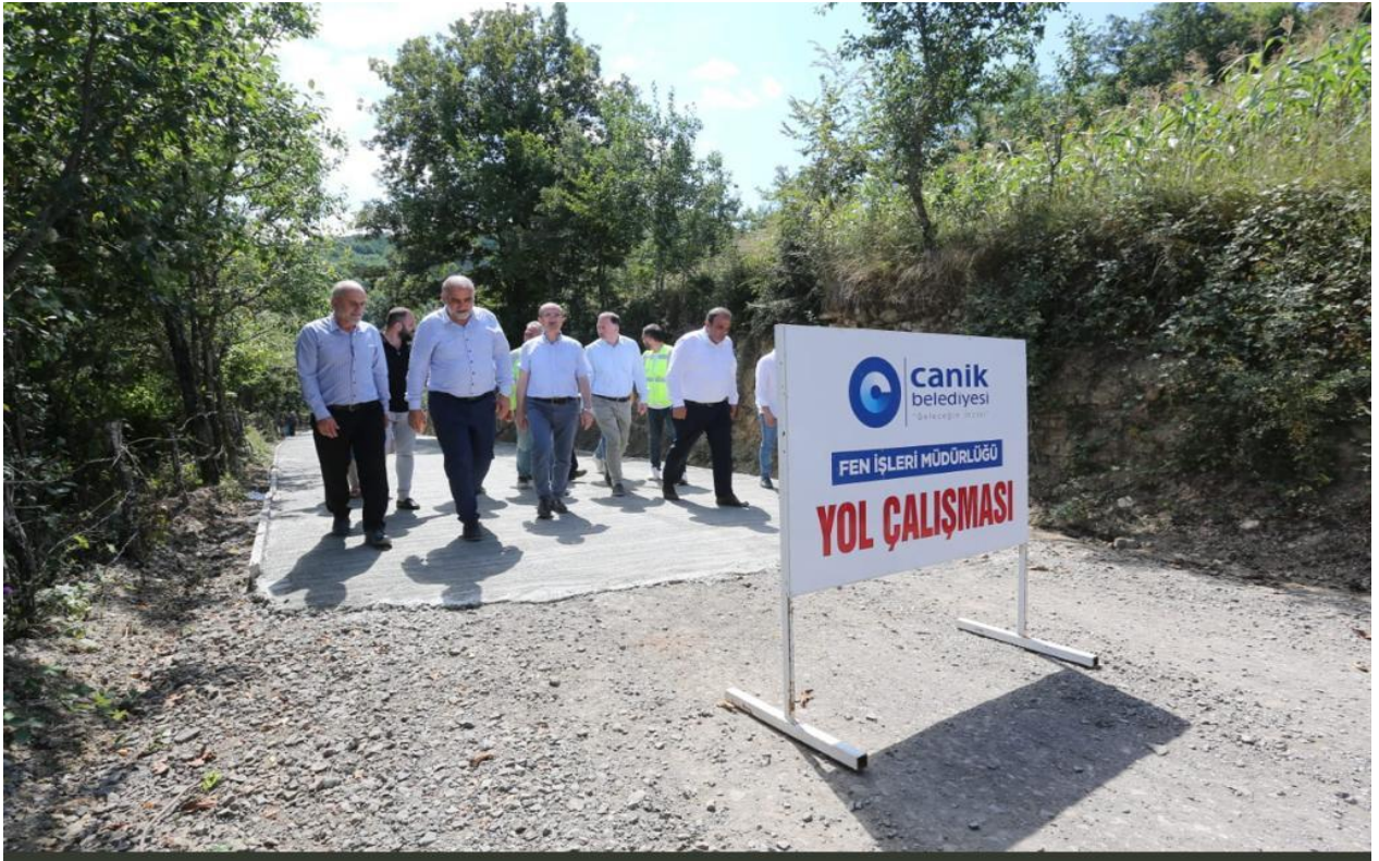
Hacınaıpli Mahallesi Beton Yol Çalışması
