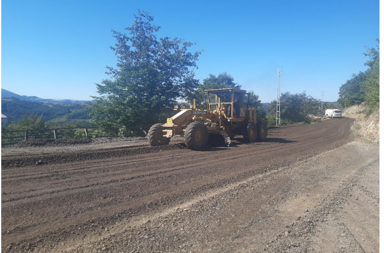
Hilaltepe Mahallesi Yol Tesviye Çalışması
