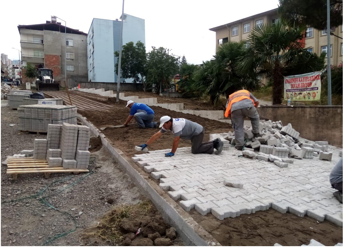
Gaziosmanpaşa Mahallesi Kaldırım Çalışması
