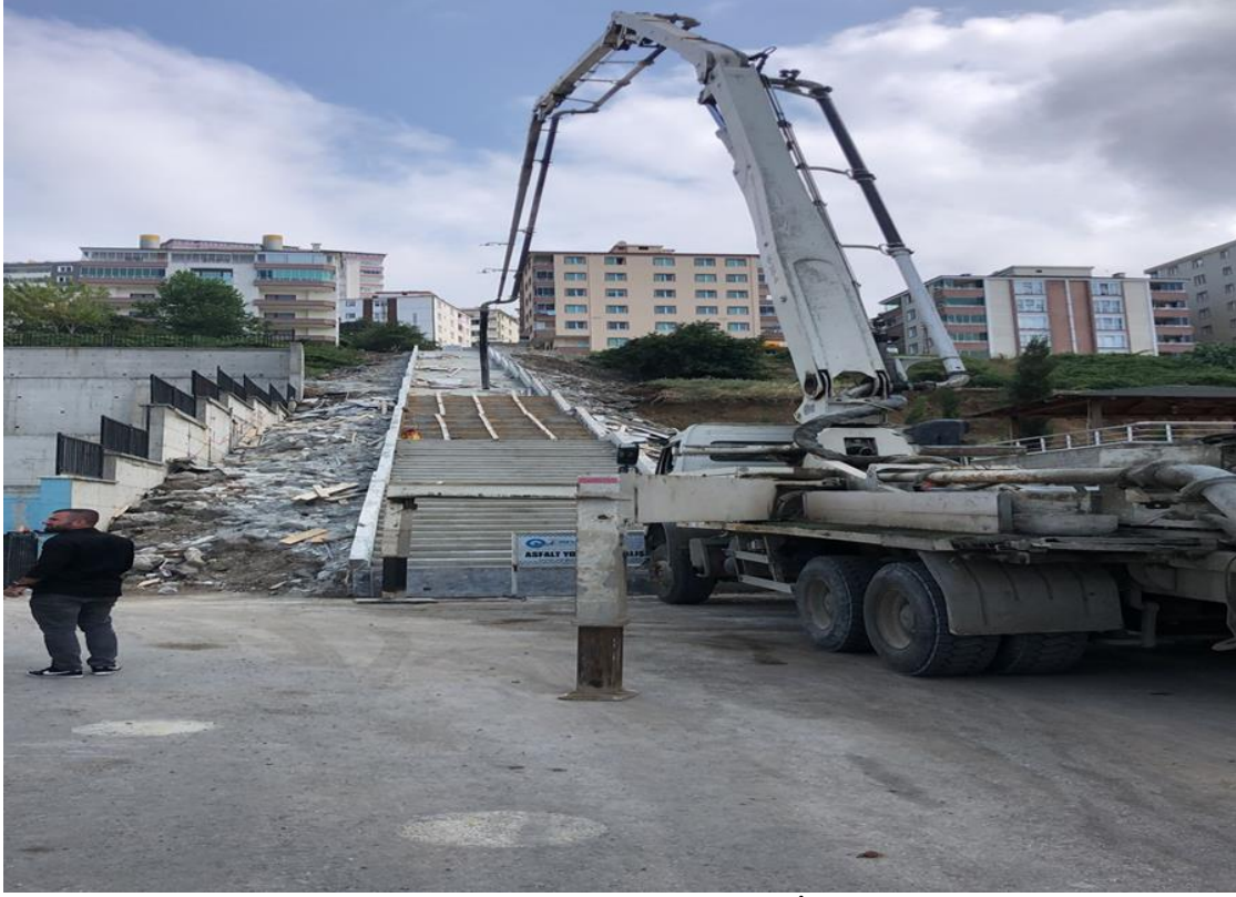
Uludağ Mahallesi Beton Merdiven İmalatı
