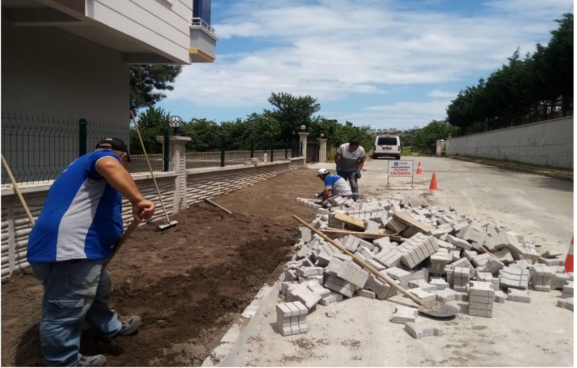
Atatürk Mahallesi Kaldırım Çalışması
