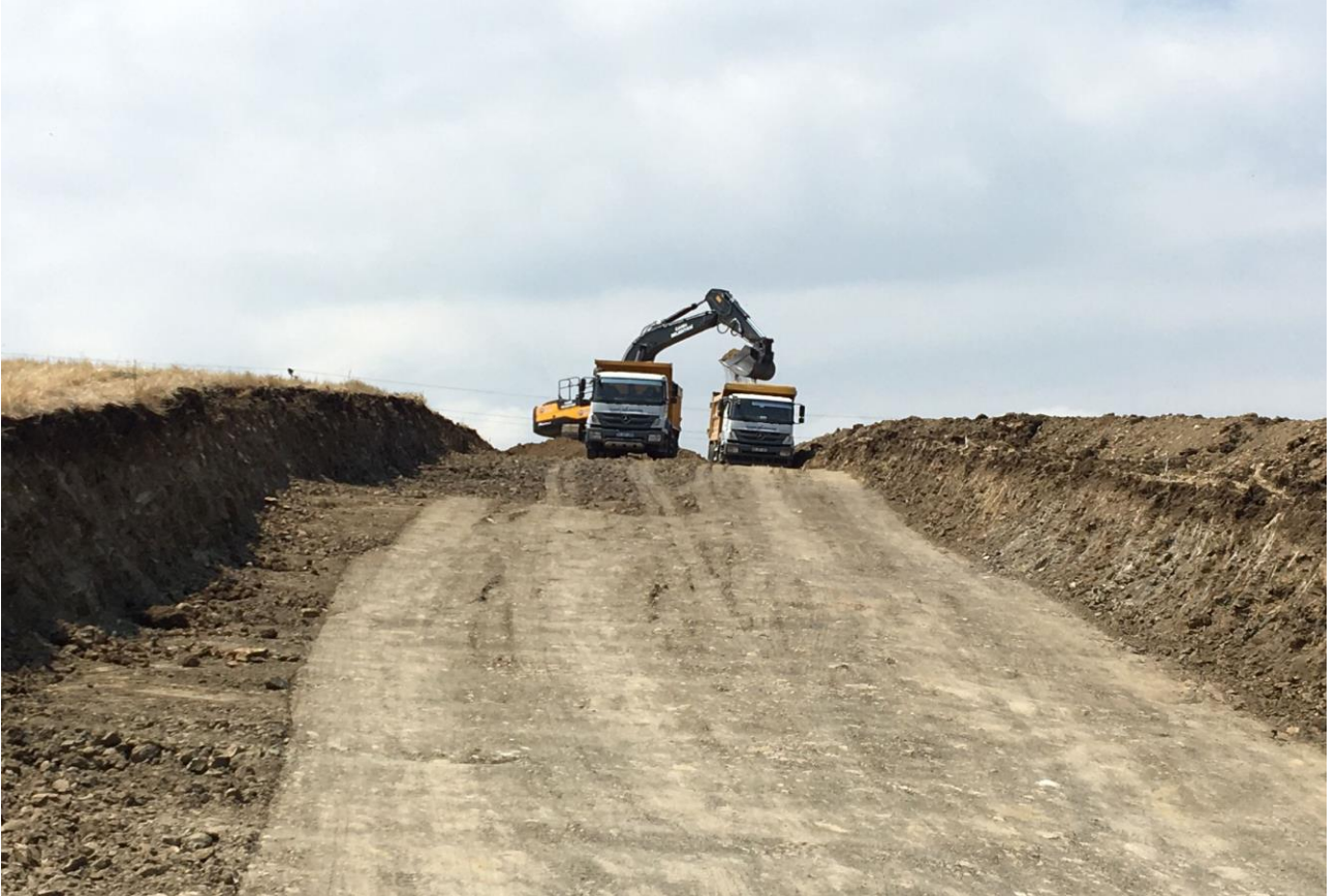
Devgeriş Mahallesi Yol Açma Çalışması
