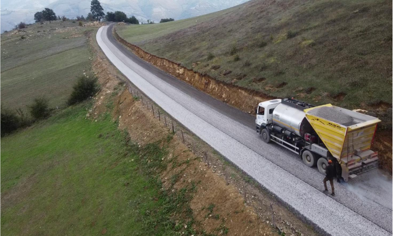
Hilaltepe Mahallesi Sathi Kaplama Çalışması
