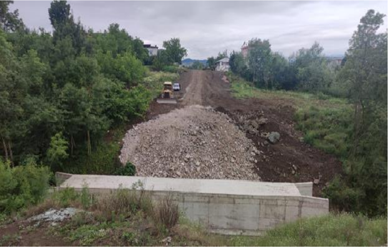
Dereler Mahallesi Beton Box Dökümü
