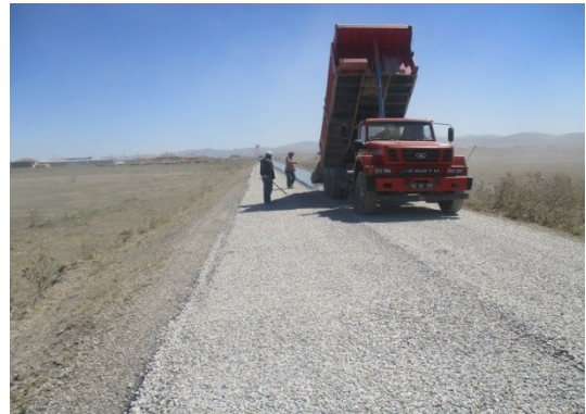
1. Kat Asfalt Çalışmaları
