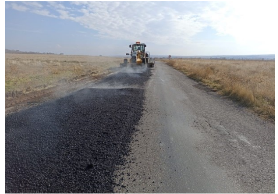
Asfalt Yama Çalışmaları
