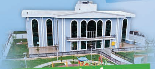
Derebahçe Sosyal Tesisleri
